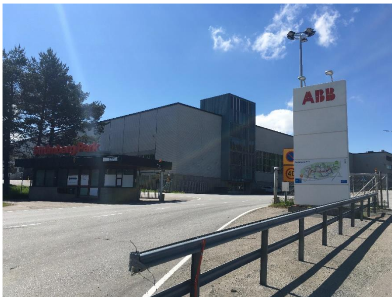
Bild 2. Transformatorporten för fordonstrafik invid Dynamovägen.
