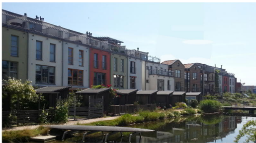
Bild 48. Exempel på en town house-byggnadsmassa invid Uddnäs vägen.
