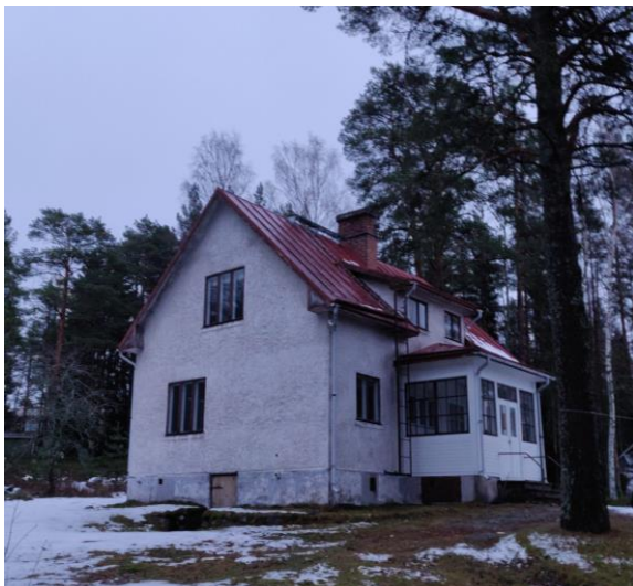
Kuva: Jouko Seppänen. Purkukohde Huvilatä, Isolampi.
