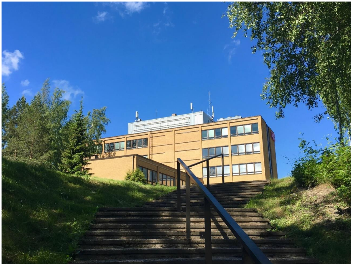
Bild 10. SO-byggnaden sedd för den nedre gårdens parkeringsområde.
