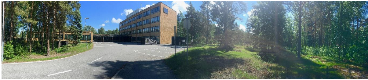
Bild 8. SO-byggnadens placering mitt i blandskog är en fortsättning på Aaltos idé om byggnader som är fritt placerade i terrängen, fastän den är uppförd på 1970-talet.
