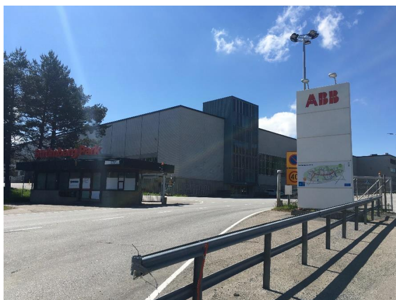
Bild 2. Transformatorporten för fordonstrafik invid Dynamovägen.
