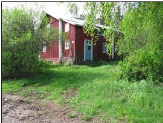
Asuinrakennuksen takpuolella oleva pieni lisärakennus.
