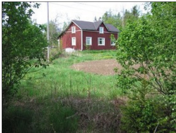
Päätyseinä leveämpi koska talon pihapuolelle tehty lisärakennus Kuvaaja: Annika Harjula Kuvausaika: 31.5.2007
