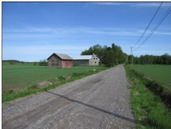
Söderlandintie 60:n iso talousrakennus kuvattuna etelästä. Kuvaaja: Annika Harjula Kuvausaika: 31.5.2007
