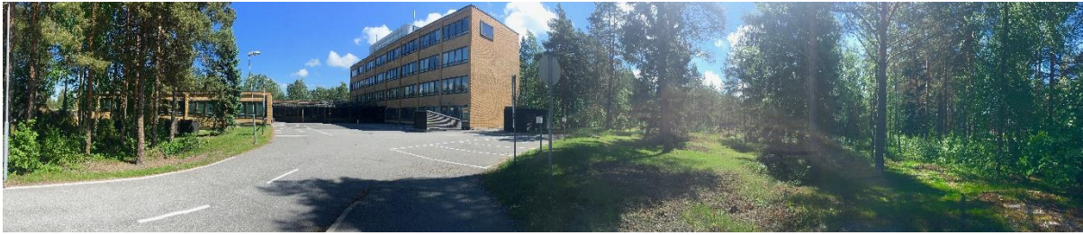
Kuva 8. SO-rakennuksen sijoittuminen keskelle sekametsää jatkaa Aallon ajatusta vapaasti maastoon sijoittuvista rakennuksista, vaikka se onkin rakennettu 1970-luvulla.
