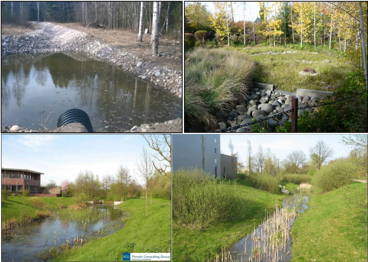
Kuva 13. Esimerkkejä viivytyksestä ja eroosiosuojauksesta. 13
