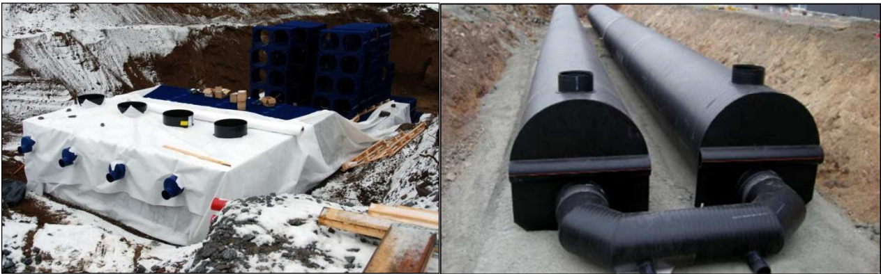
Kuva 6. Vasen kuva: Maanalaisen viivytystilavuudeltaan 300 m 3 kennoston rakentamista Tampereen Tykkitiekkadulla. 13 Oikea kuva: esimerkki vedenpitävästä säiliöstä. 14
