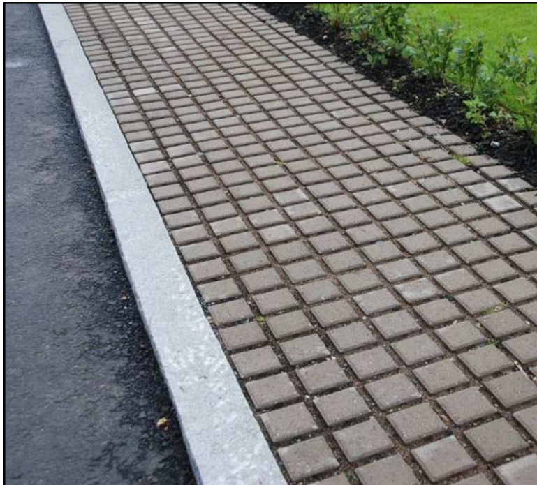
Bild 10. Exempel på användning av genomsläppliga beläggningar. 13
