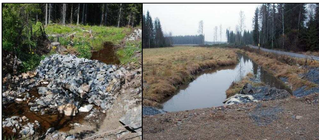
Bild 15. Exempel på dagvattenhantering under byggnadstiden. 13
