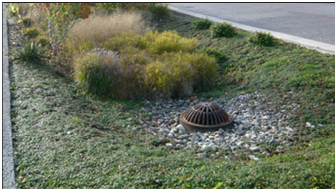
Bild 12. Exempel på en grönsänka i ett gatuområde i anslutning till vilken det finns ett överflödssystem som leder till dagvattenavloppsnätet (Seattle, USA). 13
