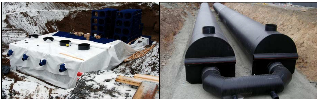
Bild 6. Bilden till vänster: Byggnad av ett underjordiskt modulsystem på 300 m 3 längs Tykkitiekatu i Tammerfors. 13 Bilden till höger: exempel på en vattentät tank. 14
