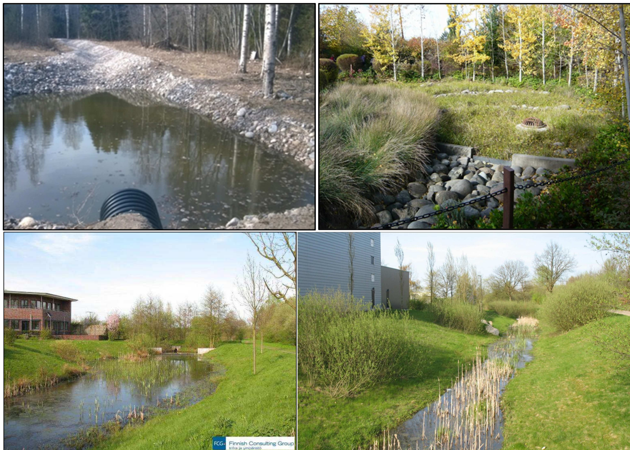
Bild 13. Exempel på fördröjning och erosionsskydd. 13
