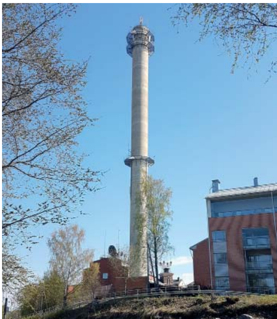
1982, Insinöörit.Pöysälä & Sandberg Oy Puhelinmastot Kuva: 2018 NAC Arkkitehdit Oy
