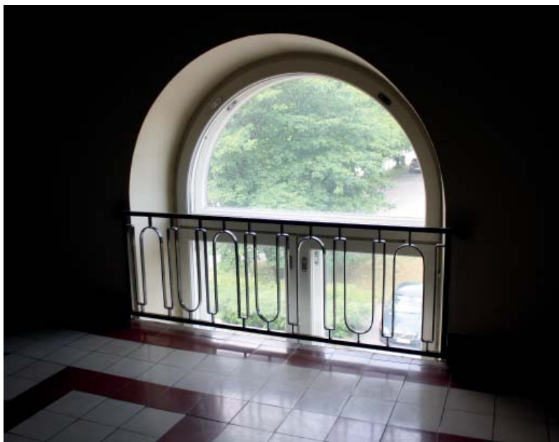
Porrashuone, rakennettu vuonna 1935, ikkunat uusittu myöhemmin vuosi epäselvä.
