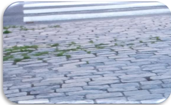
(Kuva 10. Keskisaarekkeiden mukulakivetyks vaikeuttaa pyörätuolilla liikkumista.)
