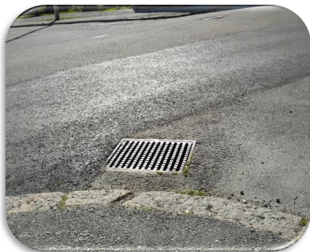
(Kuva 22. Suojatie puuttuu. Korkeat ja irronneet reunakivet esteenä.)
