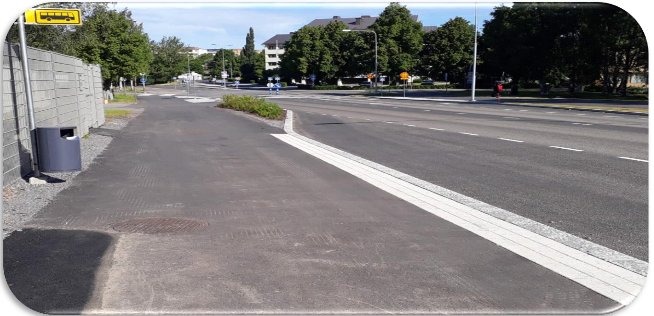
(Kuva 41. Elisa stadionin läheisessä bussipysäkissä huomioitu näkövammaiset huomiolaatalla. Vaasa.)
