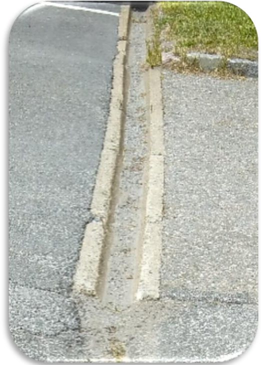
(Kuva 47. Ensimmäisessä kuvassa tasainen ja helposti ylitettävä sadevesikouru (Tukholma). Toisessa kuvassa syvä ja epätasainen sadevesikouru, jonka ylittäminen on esteellistä. (Vaasa).)
