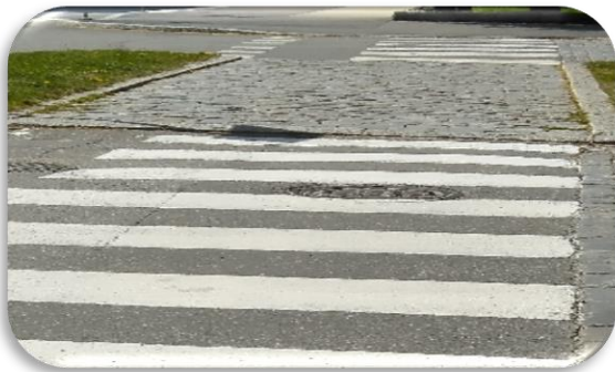
(Kuva 10. Keskisaarekkeiden mukulakivetyks vaikeuttaa pyörätuolilla liikkumista.)
