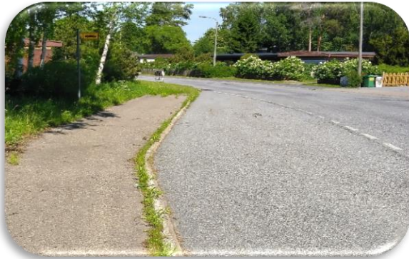
(Kuva 27. Ei suojatietä bussipysäkille. Liikennemerkki sijoitettu huonosti.)
