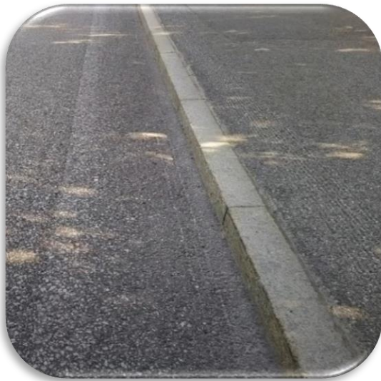
(Kuva 29. Lumivaarantiellä kevyenliikenteen väylälle liittyminen esteellistä korkeiden reunakivien ja suojaiteiden puuttumisen takia.)
