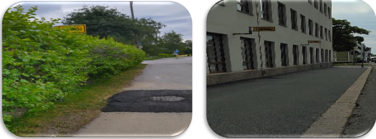
(Kuva 30. Vaikeasti hahmotettavia pysäkkialueita. Selkeä rajaus pysäkkialueista puuttuu ja merkkejä vaikea nähdä.)
