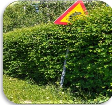
(Kuva 27. Ei suojatietä bussipysäkille. Liikennemerkki sijoitettu huonosti.)
