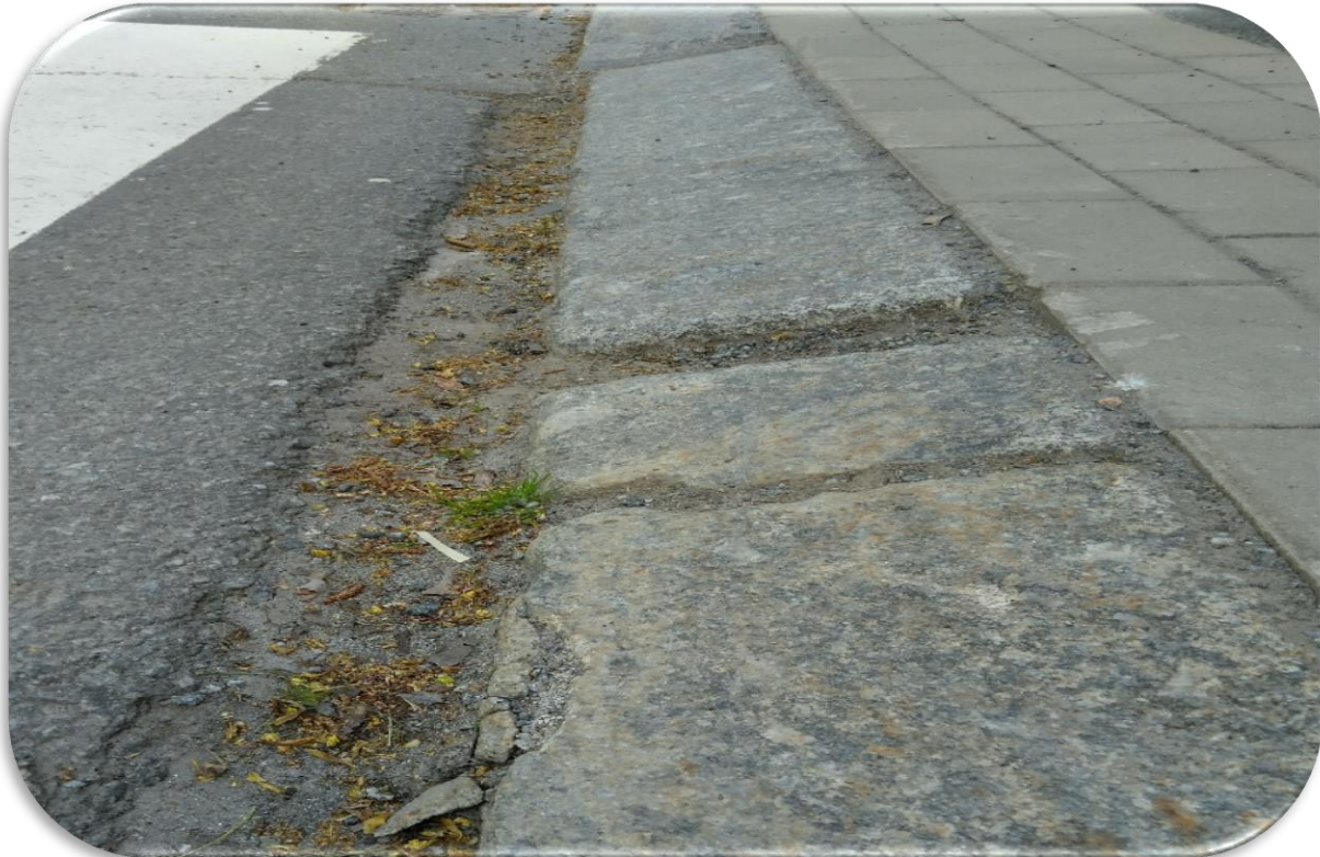
(Kuva 40. Suojatien alkuun on sijoitettu huomiolaatta, mutta suojatiestä ei löydy pystysuoraa reunatukea. Pyörällisellä apuvälineellä liikkuvaa ihmistä helpottava luiskareunatuki löytyy, mutta luiskan alle on jätetty syvä railo, joka vaikeuttaa suojatien ylittämistä. Kirkkopuistikko.)
