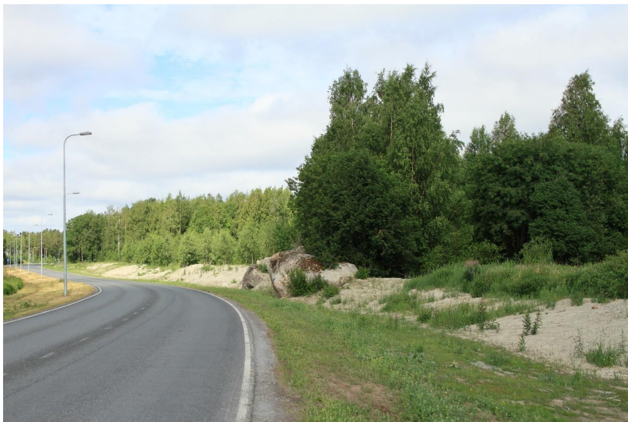
Kuva 3. Välttien varrella on rakennetut ojat hulevesien viivyttämistä ja johtamista varten.
