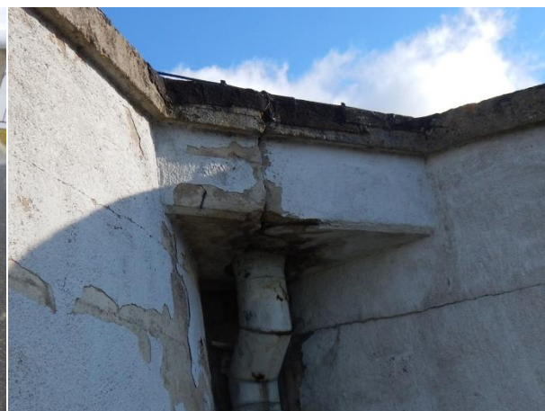
Kuva 4.13 Siilojen välinen räystääspalkki
