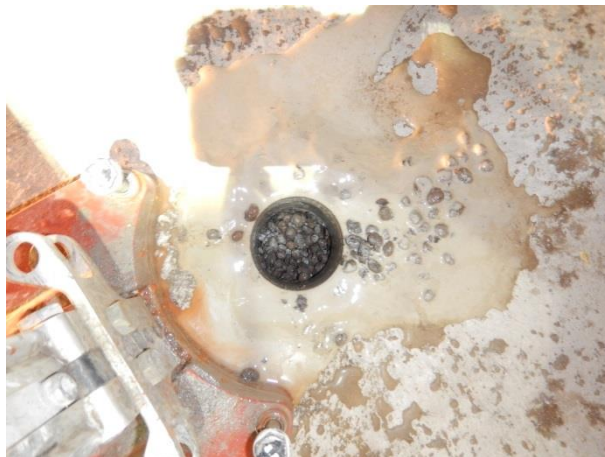
Kuva 4.22 Poraus vanhan osan kellarin lattiaan
