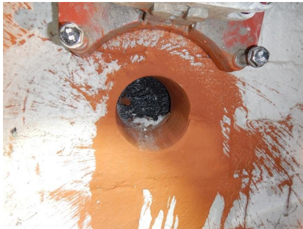
Kuva 4.23 Poraus vanhan osan kellarin seinään
