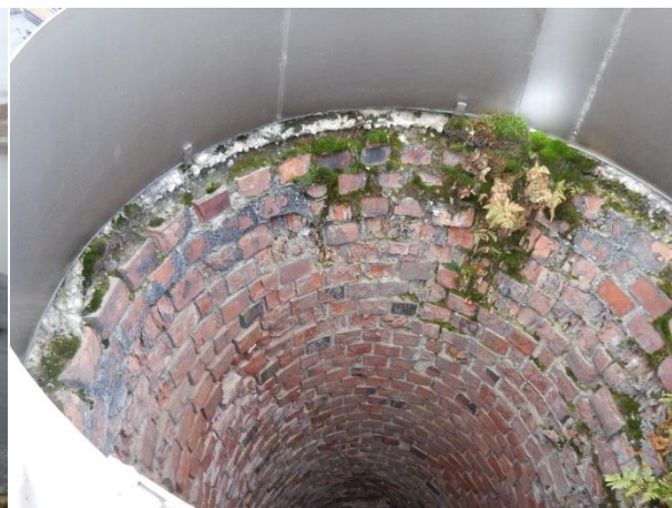
Kuva 4.10 Piipun sisäpuolinen tiilimuuraus
