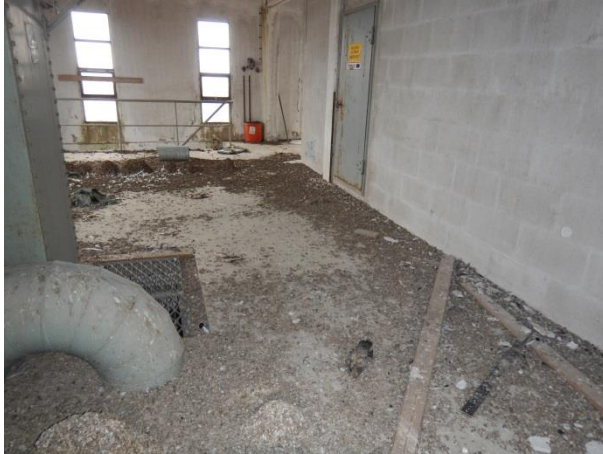
Kuva 4.16 Ullakkokerros korotusosan kohdalla
