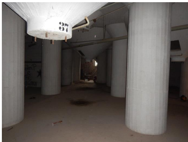
Kuva 4.14 Siilojen alapuolinen kellarikerros
