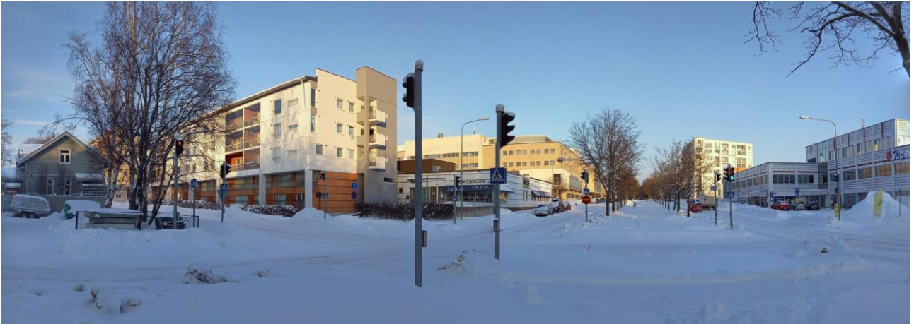
Byggnaderna på planeringsområdet från korsningen av Korsholmsesplanaden och Klemetsögatan.
