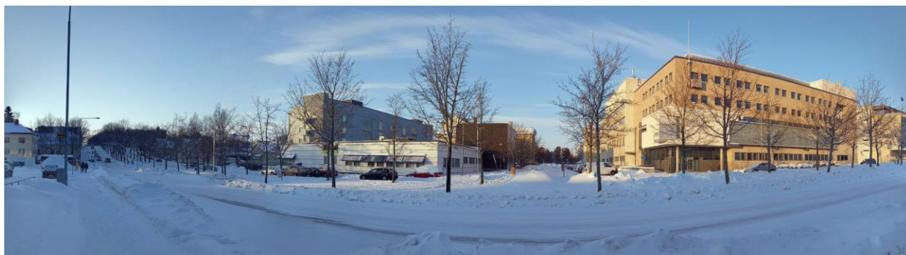
Suunnittelualueen ja sen lähialueen rakennuksia Korsholmanpuistikon suunnalta.
