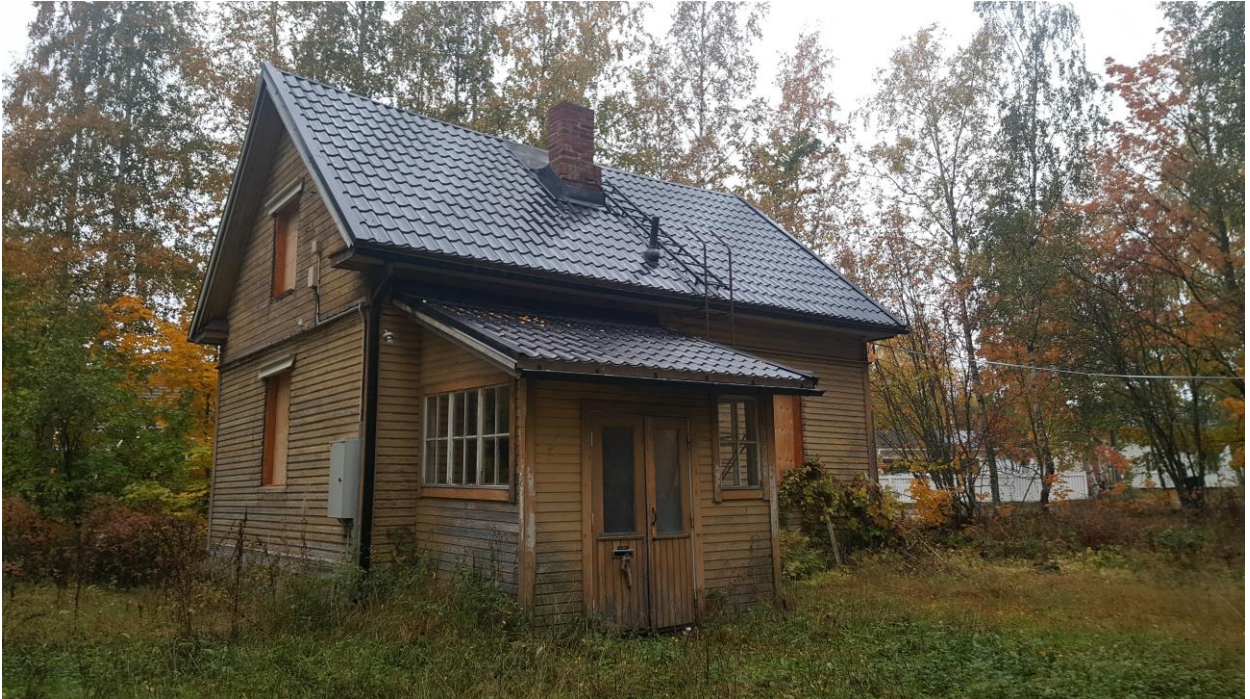
Kuva: Jouko Seppänen 2020. Purkukohde Kruunantie 26, Vetokan-
