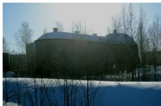
Kuva 8. Gulf Oilin betonisäiliö.
