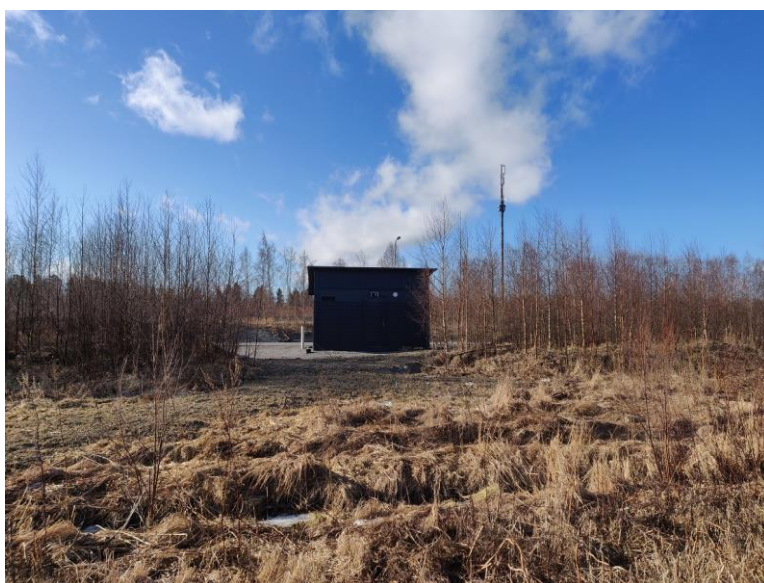
Bild: Pumpstationen för fjärrvärme invid Mellanvägen.
