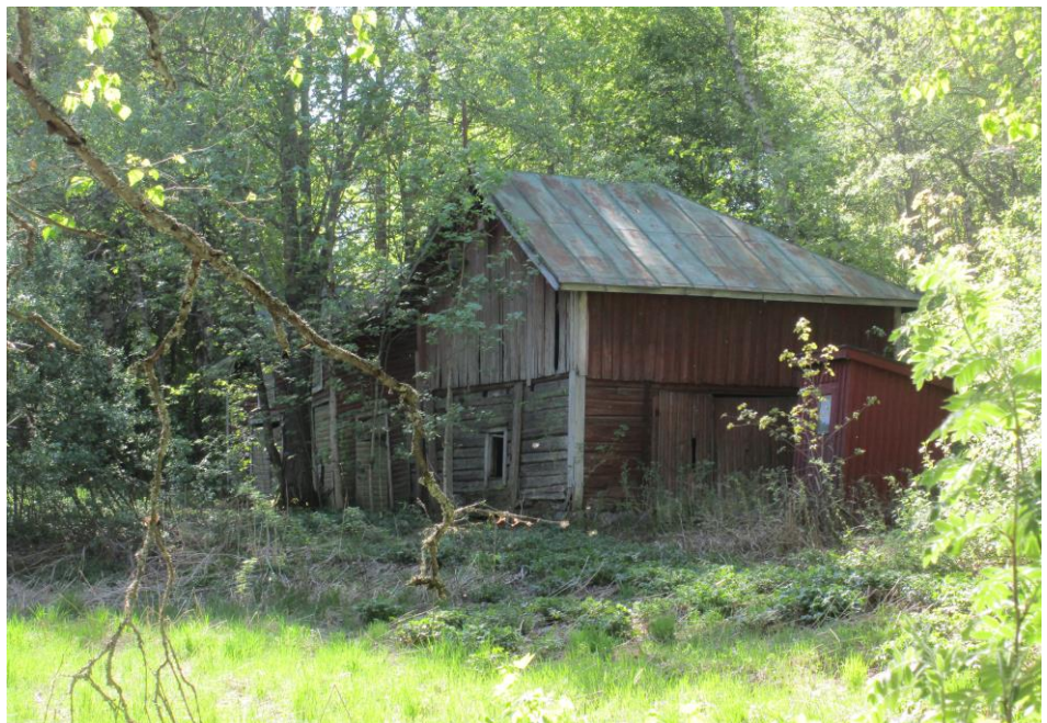
Bild 4. Gammalt byggnadsbestånd på området kring Roparnäsbacksvägen.
