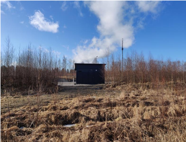
Kuva: Kaukolämmön pumppaamo Välitien varrella.
