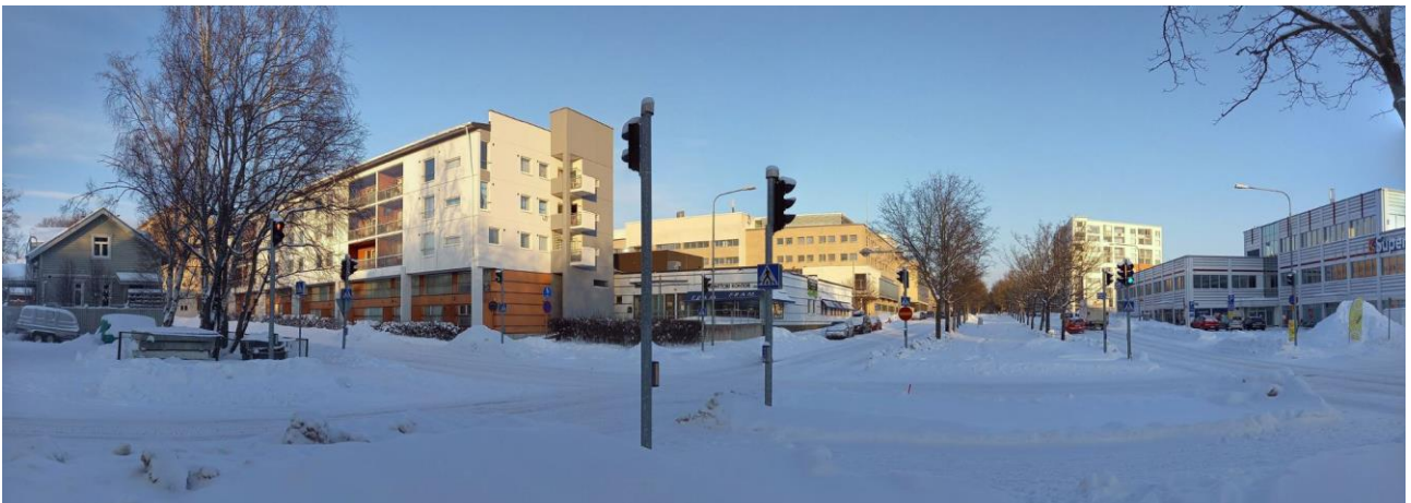
Suunnittelualueen rakennukset Korsholmanpuistikon ja Klemetinkadun risteyksen suunnalta.
