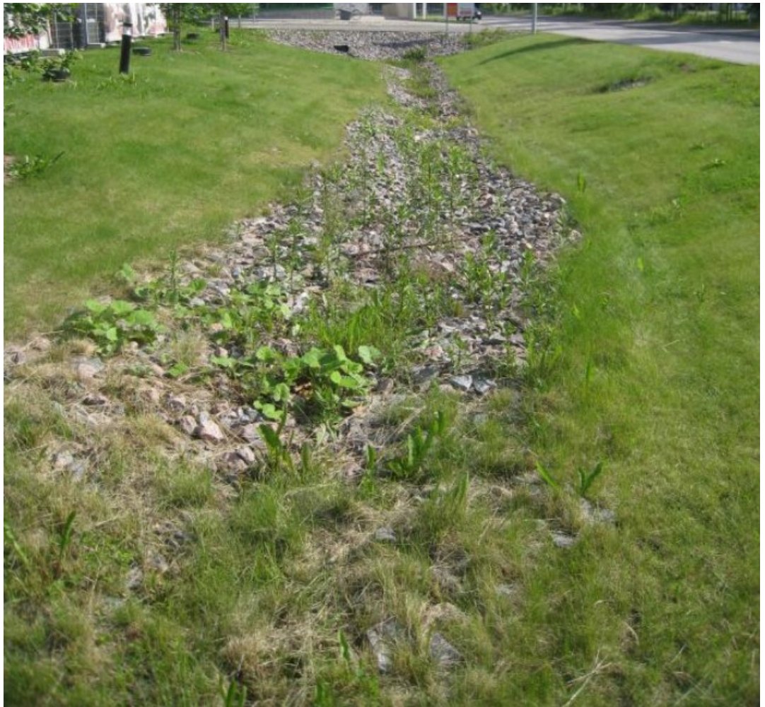
Bild 4: Exempel på sänka som fördröjer dagvatten.[4]
