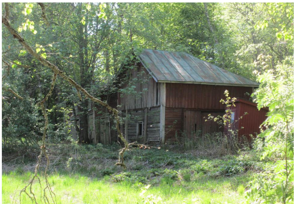
Bild 4. Gammalt byggnadsbestånd på området kring Roparnäsbacksvägen.
