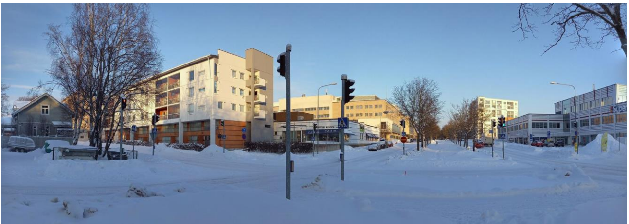
Byggnaderna på planeringsområdet från korsningen av Korsholmsplanaden och Klemetsögatan.
