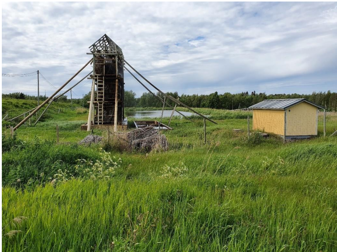
Kuva 22 Kaatopaikka-alueen suotovesien käsittelyjärjestelmän pajukerpputori (kuva 2021).
