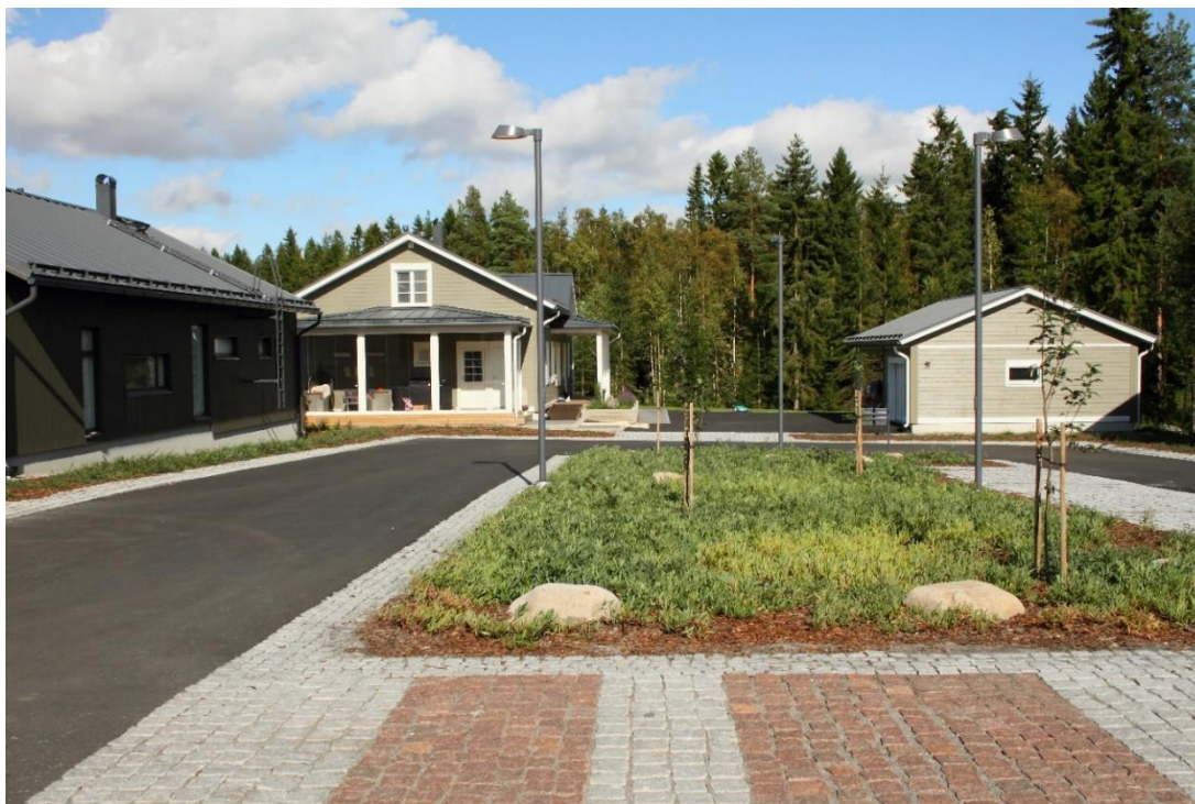
Kuva 11. Asemakaava-alueella hulevesiratkaisuja voidaan toteuttaa esimerkiksi kasvillisuusvyöhykkeiden tai osittain vettä läpäisevien pintojen avulla.
