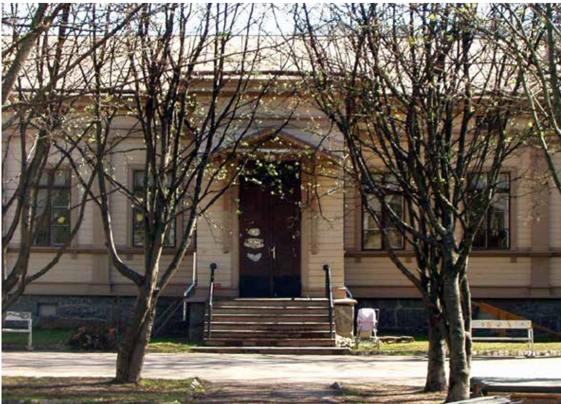
KUVA: Kasarmialue on suojeltu sekä rakennussuojelulailla että asemakaavassa
