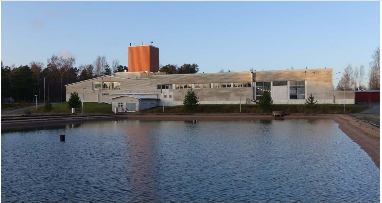
Vesilaitos etelästä, lähinnä vedenkäsittelylaitos ja hidassuodatusaltaita.
