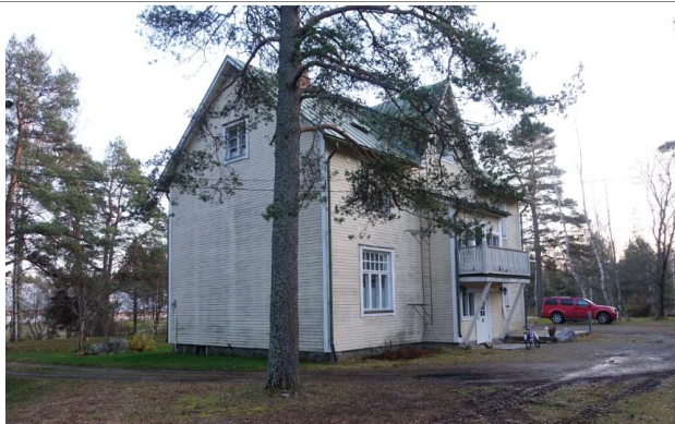
Julkisivu, koillispääty ja luoteissivu.
