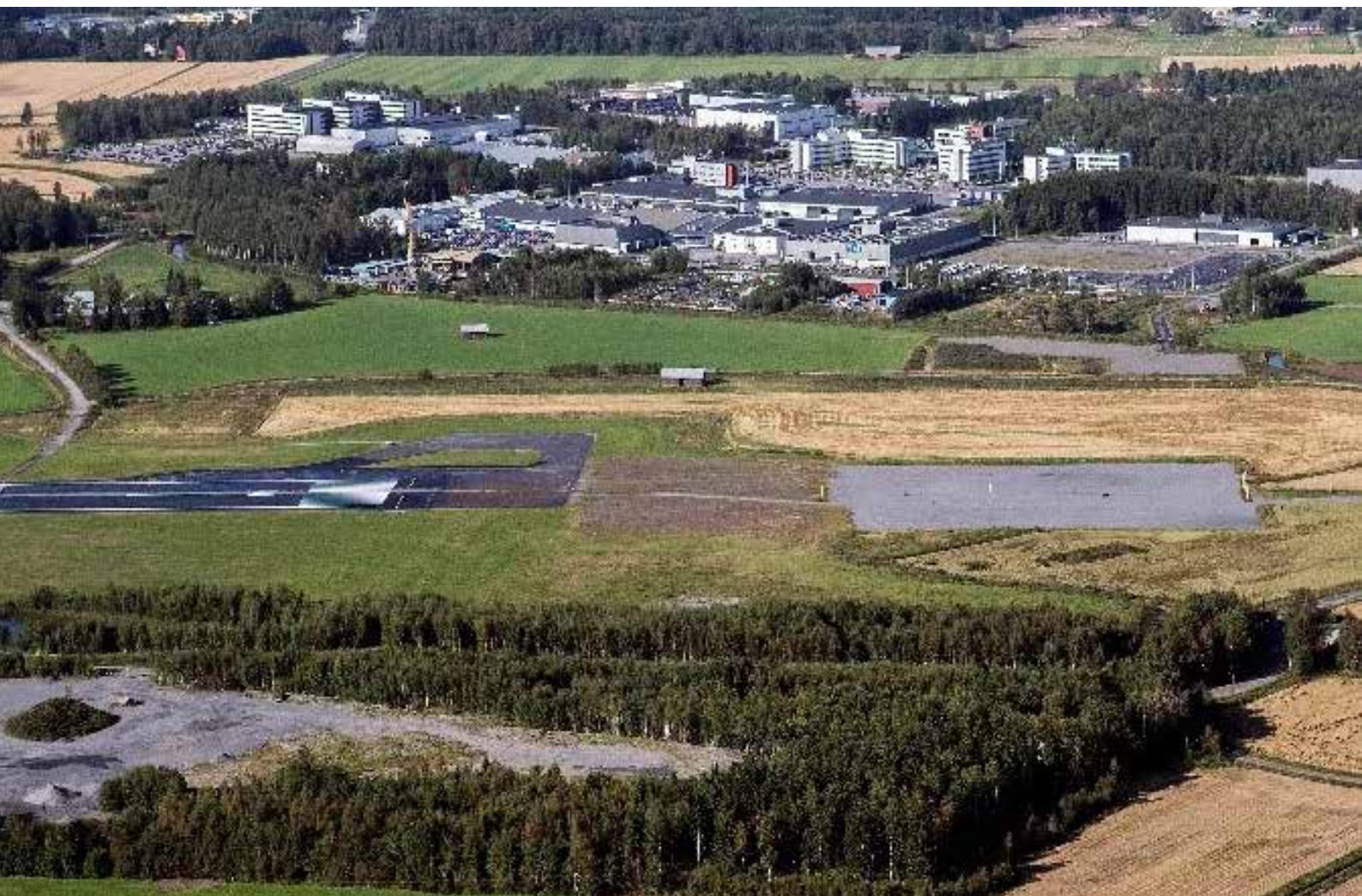
BILD: Flygfältet och Runsor företagsområde (Planläggningen)
