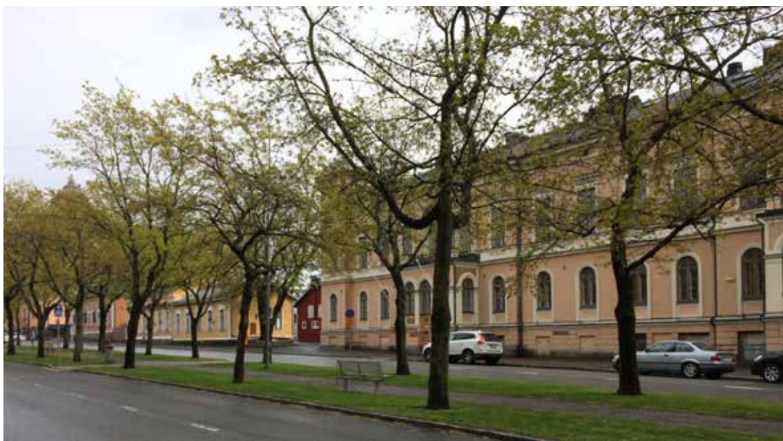
BILD: Utredningen om Styrelsegårdens byggnadshistoria var ett viktigt dokument när den grundliga renoveringen planerades
