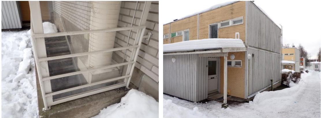
Kuva 4. Kellarillisesta perustuksesta johtuen VOAS1 D-rakennuksen päätyjen ulkoseinien puurakenteiset osat ovat korkeammalla suhteessa maanpintaan, kuin muissa rakennuksissa.
