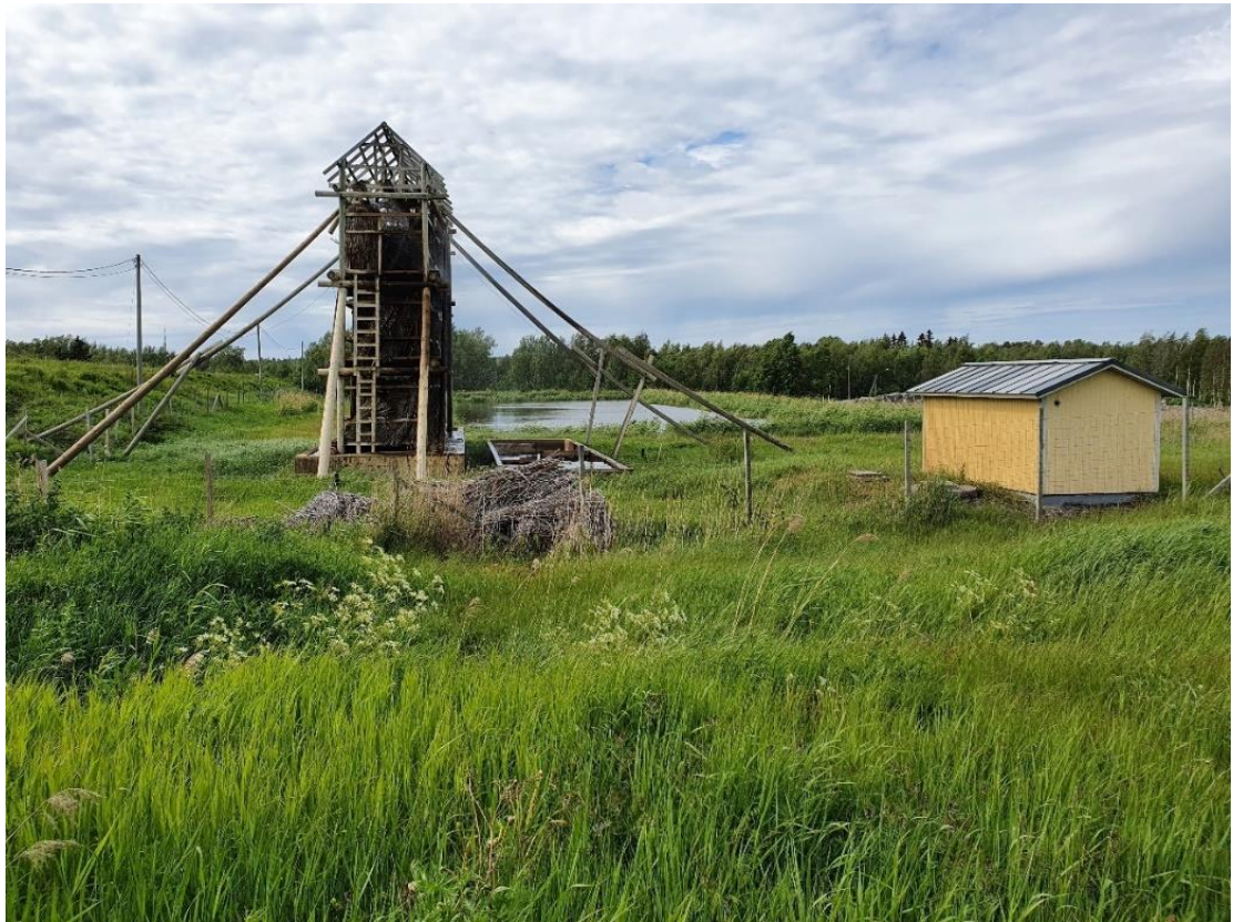
Kuva 22 Kaatopaikka-alueen suotovesien käsittelyjärjestelmän pajukerpputori (kuva 2021).
