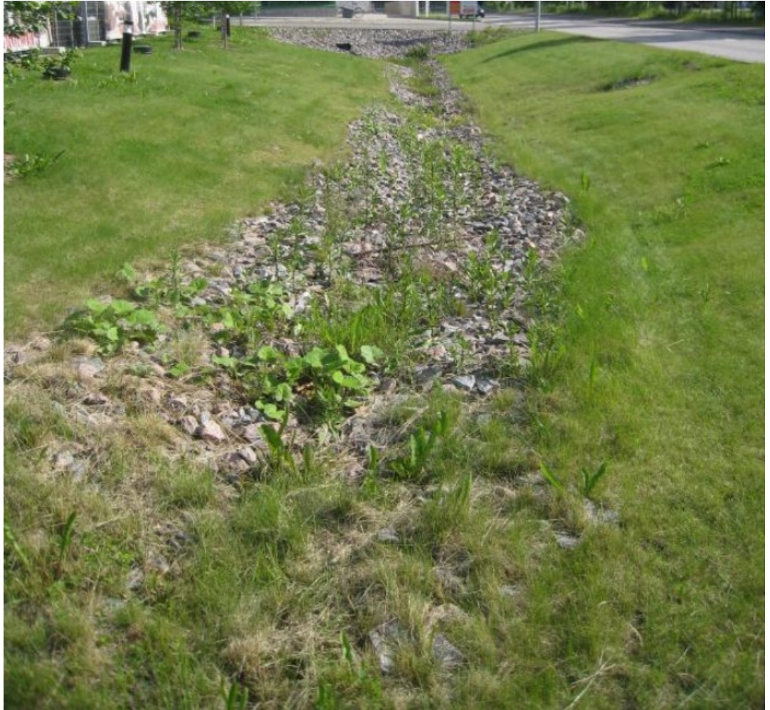
Kuva 4: Esimerkki hulevesiä viivyttävästä painanteesta.[4]
