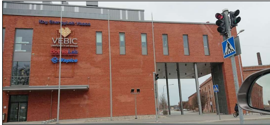
Kuva 7. EnergyLabin pääsisäänkäynti Palosaaren päädyssä. Näkymä sillalta. Rakennuksen lävitse näkyy vanhaa Finlaysonin aluetta.
