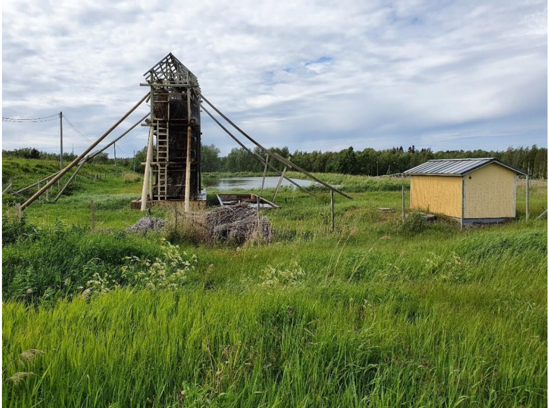
Bild 22 Videtornet i behandlingssystemet för lakvatten från området för avstjälningsplatsen (bild 2021).
