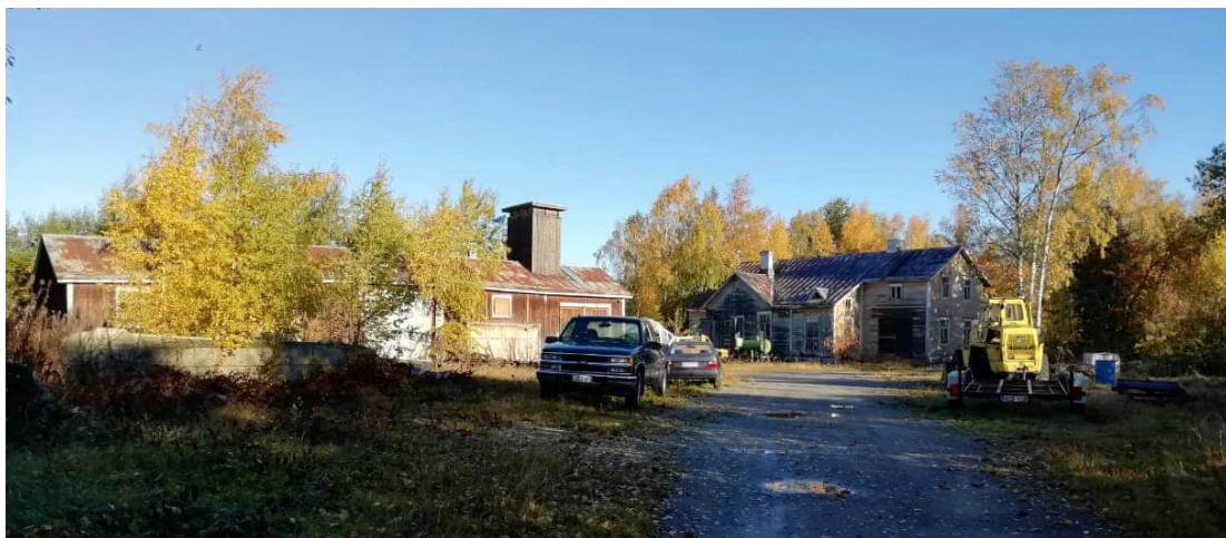
Vanhan kansakoulun pihapiiri vuonna 2018. Kuva on otettu palaneen kansakoulurakennuksen paikalta.
