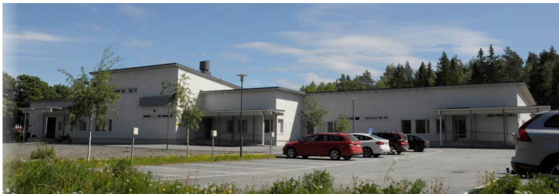
Päiväkotirakennus Sundomintien suunnasta kuvattuna
