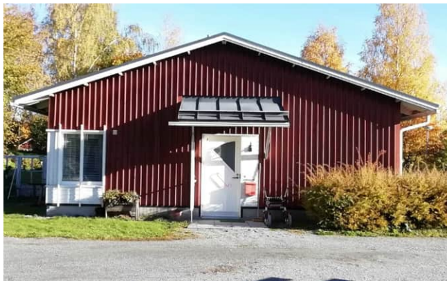
Rakennus nro 27, valmistumisvuosi 1995
