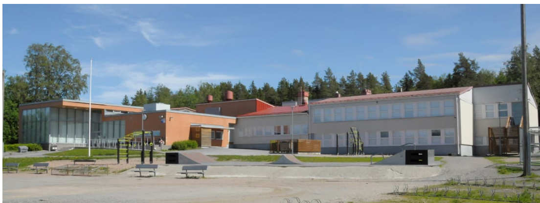
Sundom skola. Den ljusare byggnadsdelen till höger är den ursprungliga skolbyggnaden från år 1959. Delen i rött tegel med platt tak är utvidgningen från år 2008.
