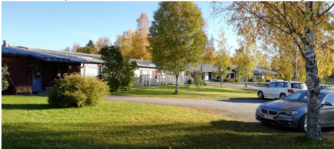
Radhuset från 1970-talet och parkeringsplatsen framför det anger platsens framtoning.
