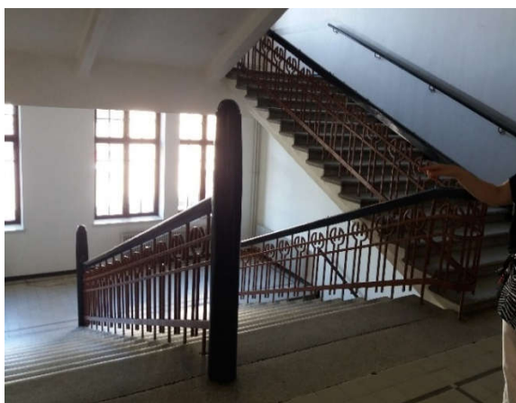
Pääporras Kauppapuistikko 22:ssa
