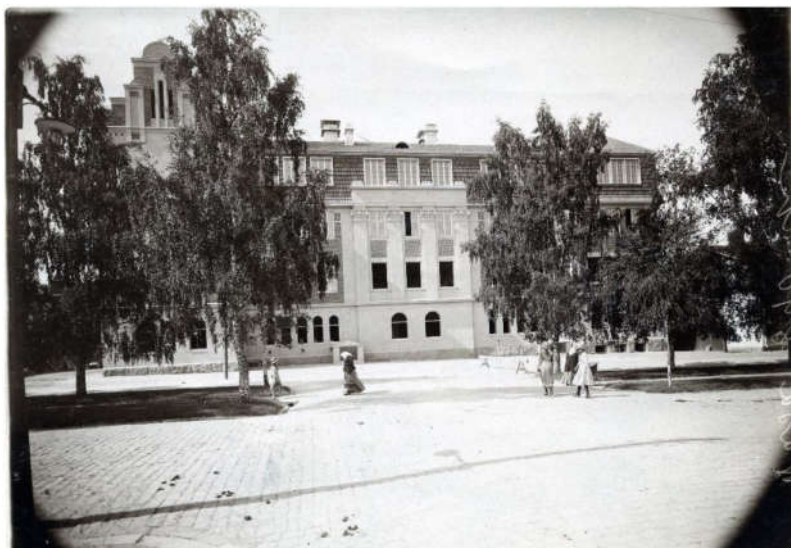
Kauppapuistikko 22 rakennusvaiheessa kun ikkunoita asennetaan. Kuva Pohjanmaan museon arkisto
