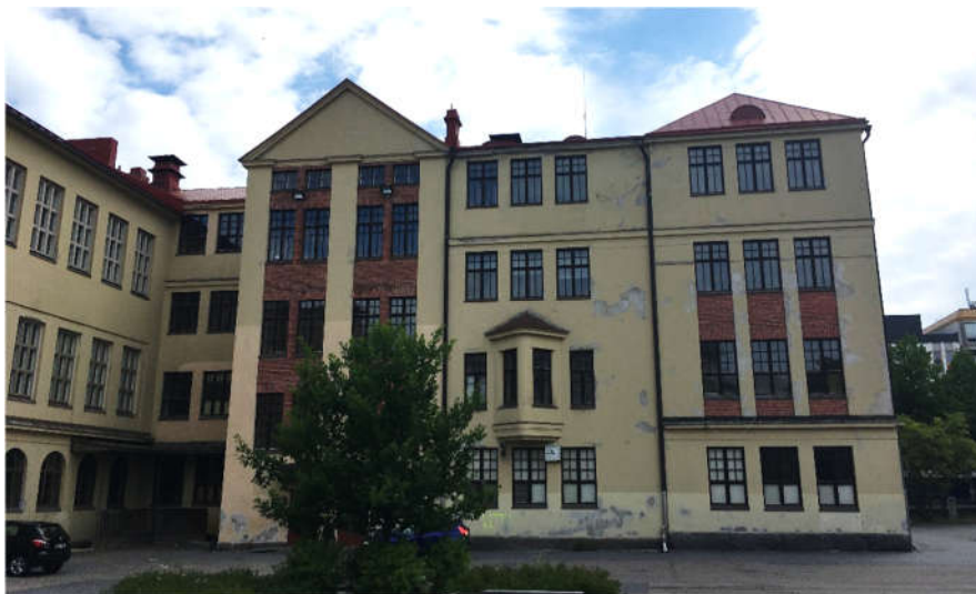
Kauppapuistikko 22:en julkisivu sisäpihalle päin
