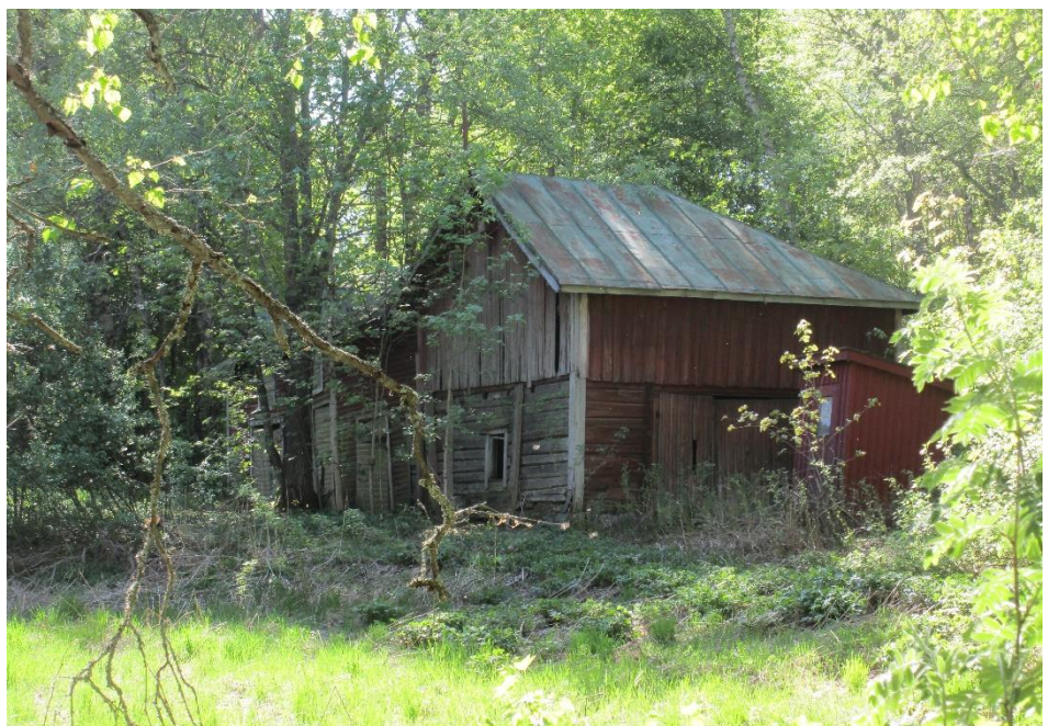
Bild 4. Gammalt byggnadsbestånd på området kring Roparnäsbacksvägen.
