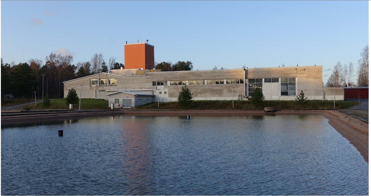
Vesilaitos etelästä, lähinnä vedenkäsittelylaitos ja hidassuodatusaltaita.
