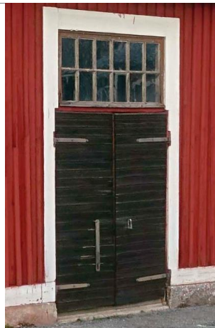
Oven ja ikkunan yksityiskohta.
