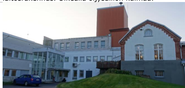
Näkymä idästä. Sisäänkäynti, toimisto-osa vasemmalla laajennusosaa, oikealla vanhassa rakennuksessa puhtasvesialtaat.
