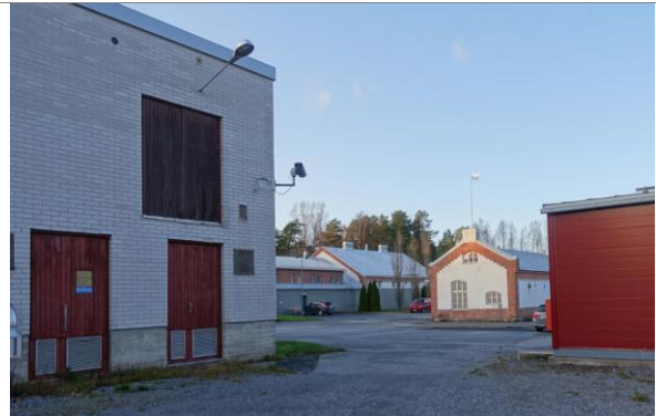
Vedenkäsittelylaitoksen sivua itään. Taustalla pohjoisosan puhtasvesialtaat ja keskellä vanha vesilaitosrakennus. Oikealla öljysäiliön kulmaa.
