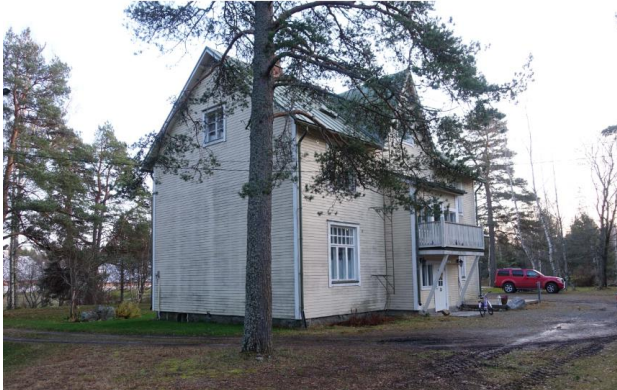
Julkisivu, koillispääty ja luoteissivu.
