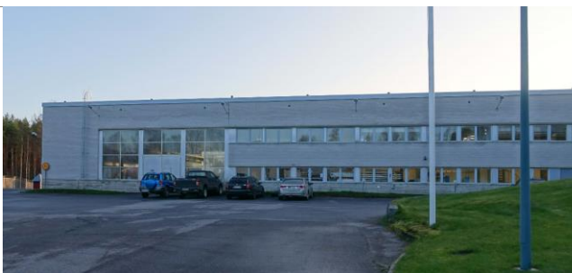
Laajennusosa pihan puolelta pohjoisesta.
