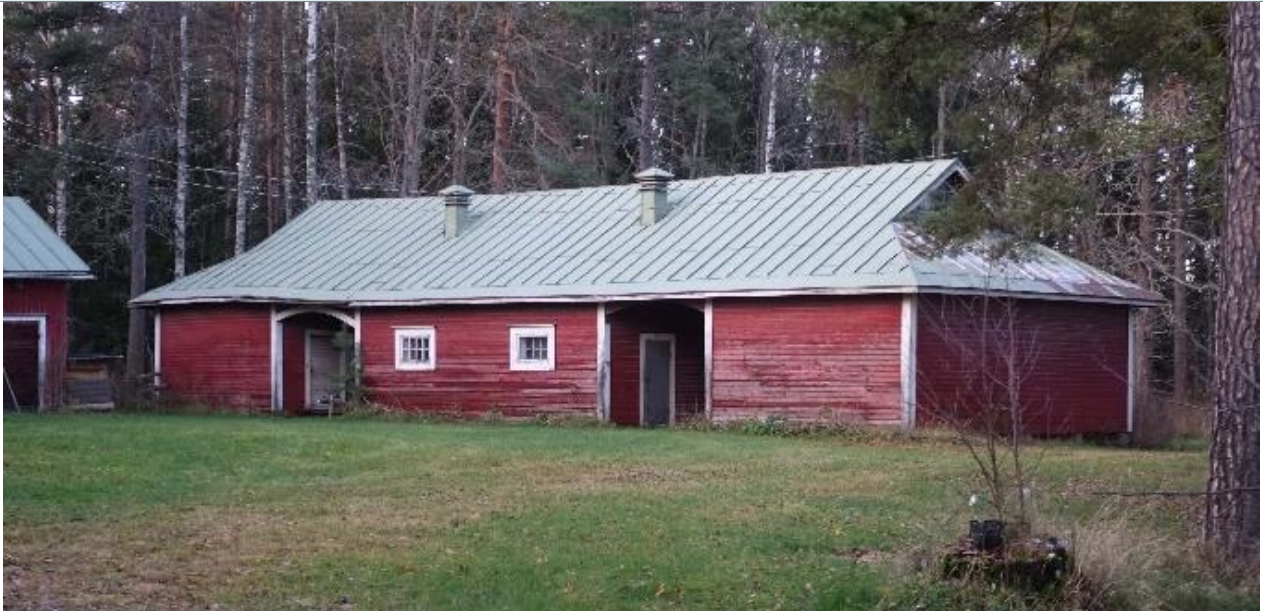
Pihan puolen julkisivu.
