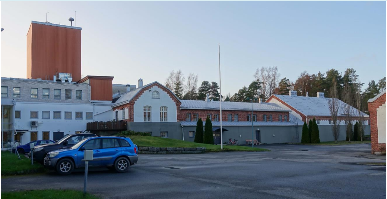
Näkymä idästä. Keskellä vanhinta osaa oleva suodatinlaitos ja oikealla puhdasvesialtaita. Korkeimpana oranssina massana näkyvät pystyselkeyttimet.
