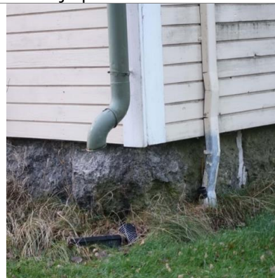
Syöksytorvi ja sokkeli.
