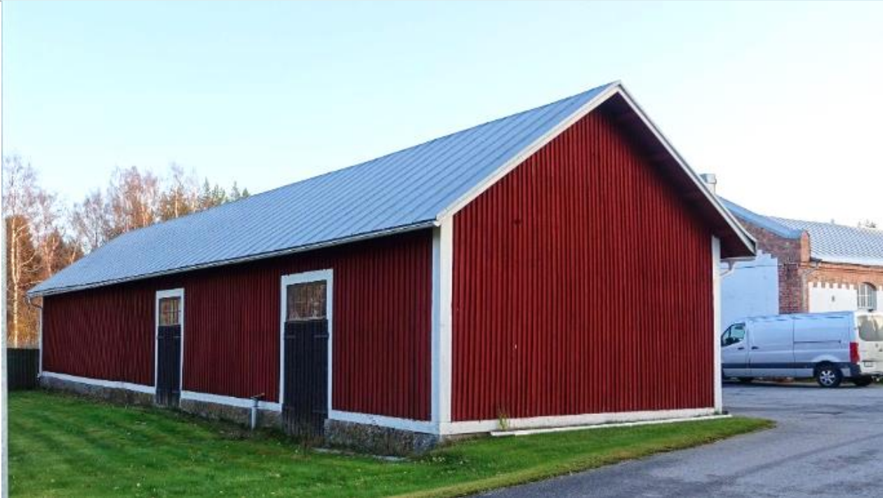
Pääty länteen ja sivu pohjoiseen.
