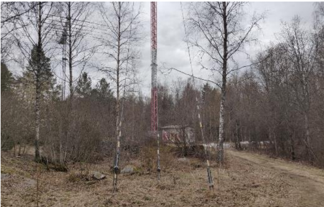
Bild 12 Vy mot mobilbasstationen från Radiovägen.
