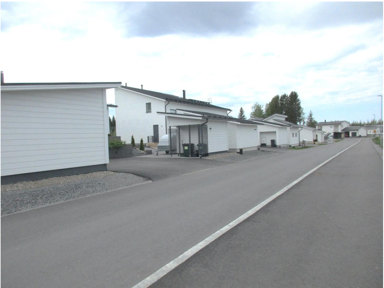
Bild 2. Byggnadsbeståndet på södra sidan av Kolbäddsgränden.
