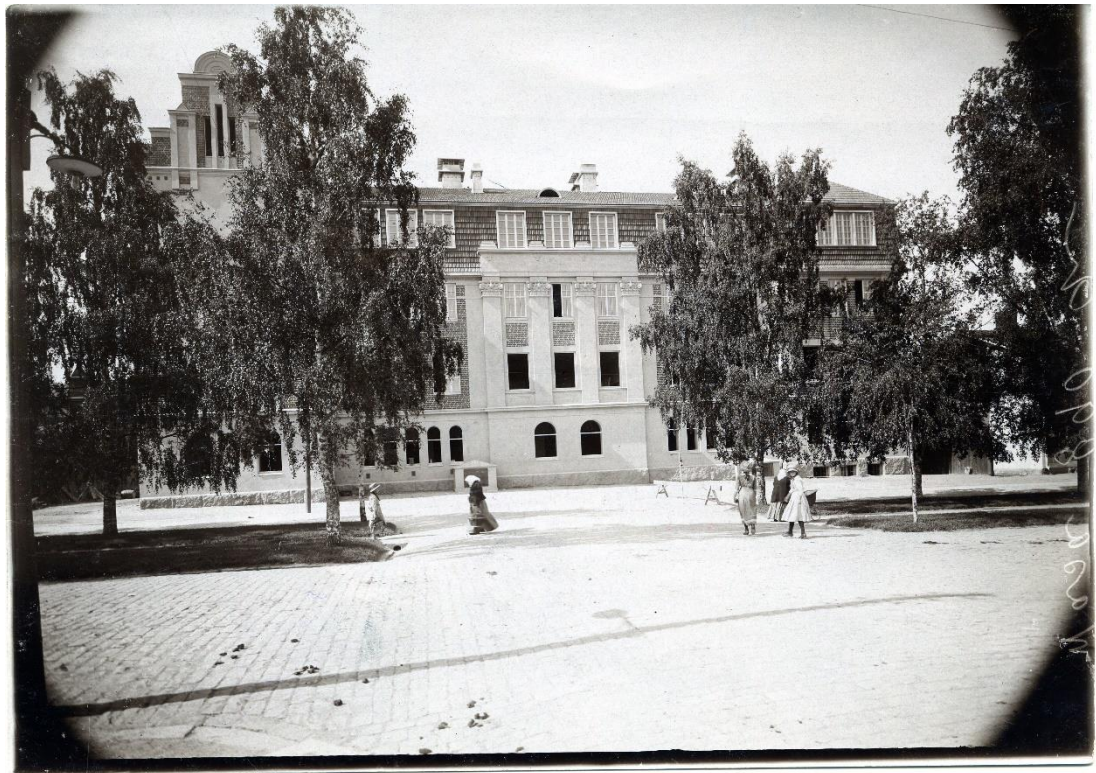
Kuva 28. Kauppapuistikko 22 rakennusvaiheessa, kun ikkunoita asennetaan. Kuva Pohjanmaan museon arkisto, kuvaaja Knackstedt & Co, Hamburg.
