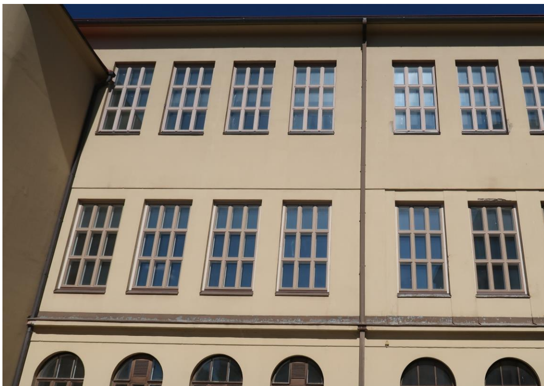
Kuva 67. Siipiosan pihajulkisivu ja juhla- ja liikuntasalin uusitut ikkunat vuonna 2021.
