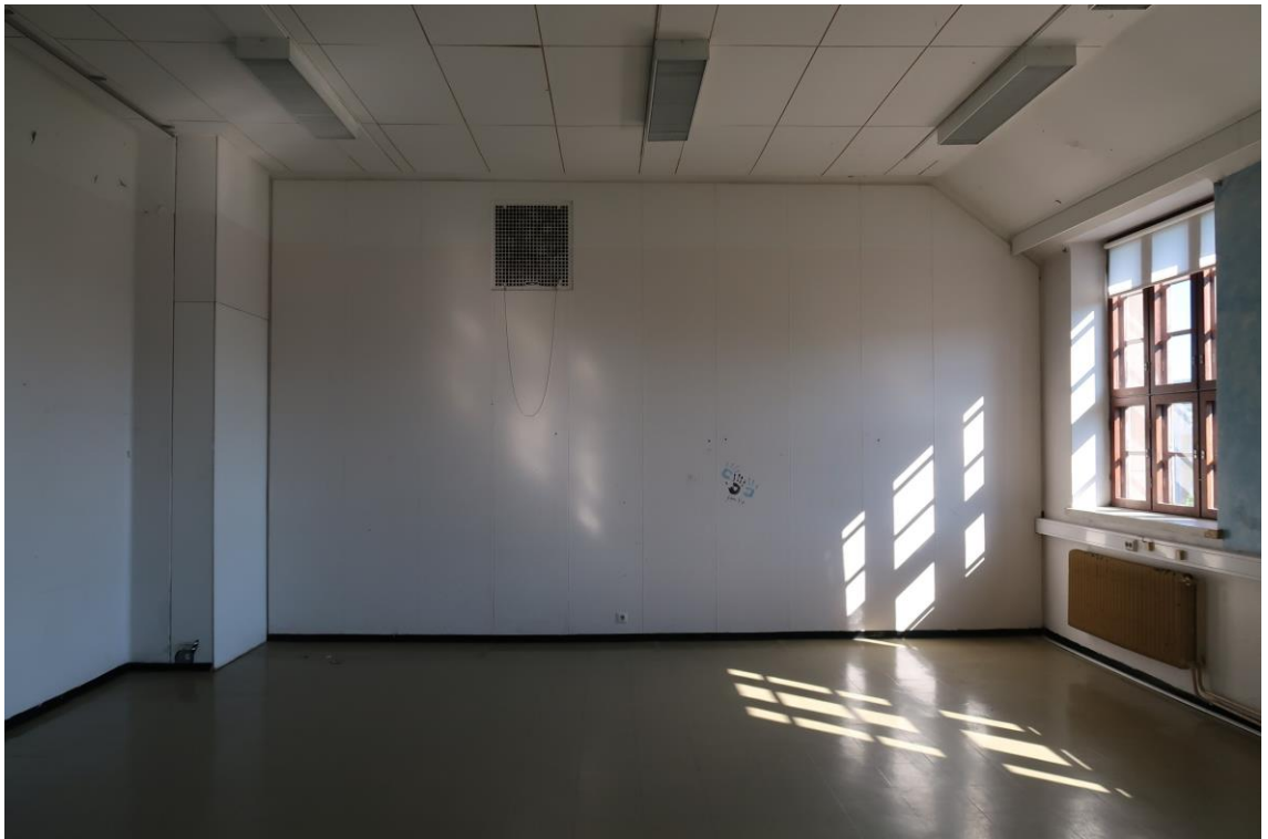
Kuva 75. Luokissa mittasuhteet ovat säilyneet, kun alakattoja ei ole rakennettu missään vaiheessa. Ylimmän kerroksen luokkien katon ja seinän liittymän viisteet (kuvassa) ja kaaret ovat näkyvissä. Kuva 2021.
