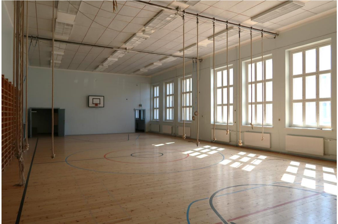
Kuva 82. Liikuntasalin kolme taimmaista ikkunaa kuvassa kuuluvat vuoden 1913 rakennusvaiheeseen. Tila on säilyttänyt 1950-luvun mittasuhteet, mutta sen varusteita on todennäköisesti muutettu.
