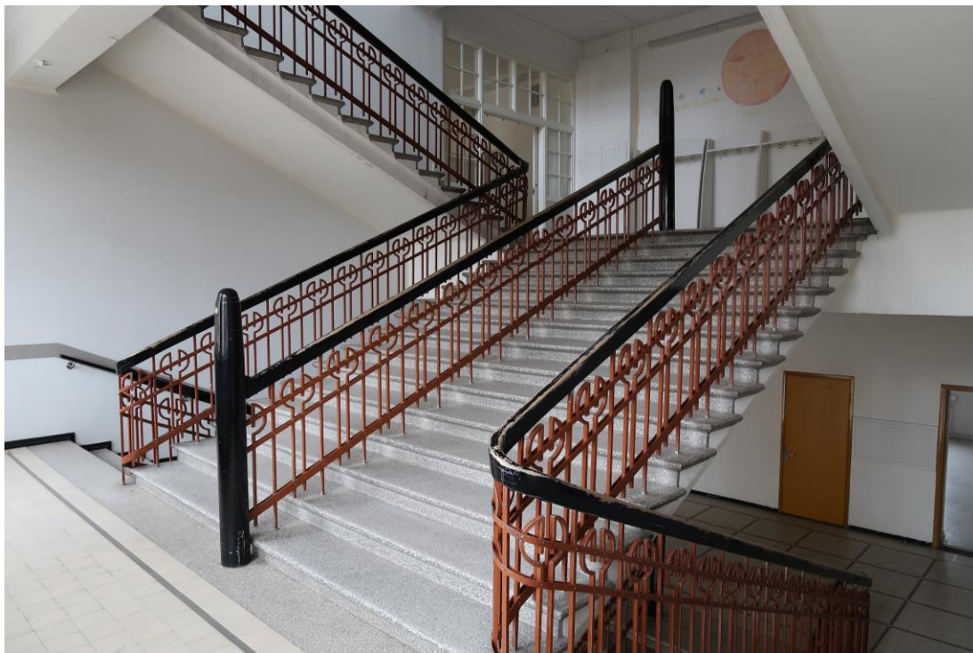
Kuva 72. Pääportaikko vuonna 2021. Se on säilyttänyt piirteensä hyvin ja kuluneet mosaiikki-betoniaskelmat kertovat kovasta käytöstä. Askelmien kuluneisuus lisääntyy alemmissa kerroksissa, mikä on luonnollista, koska ne ovat olleet kovimmalla kulutuksella.
