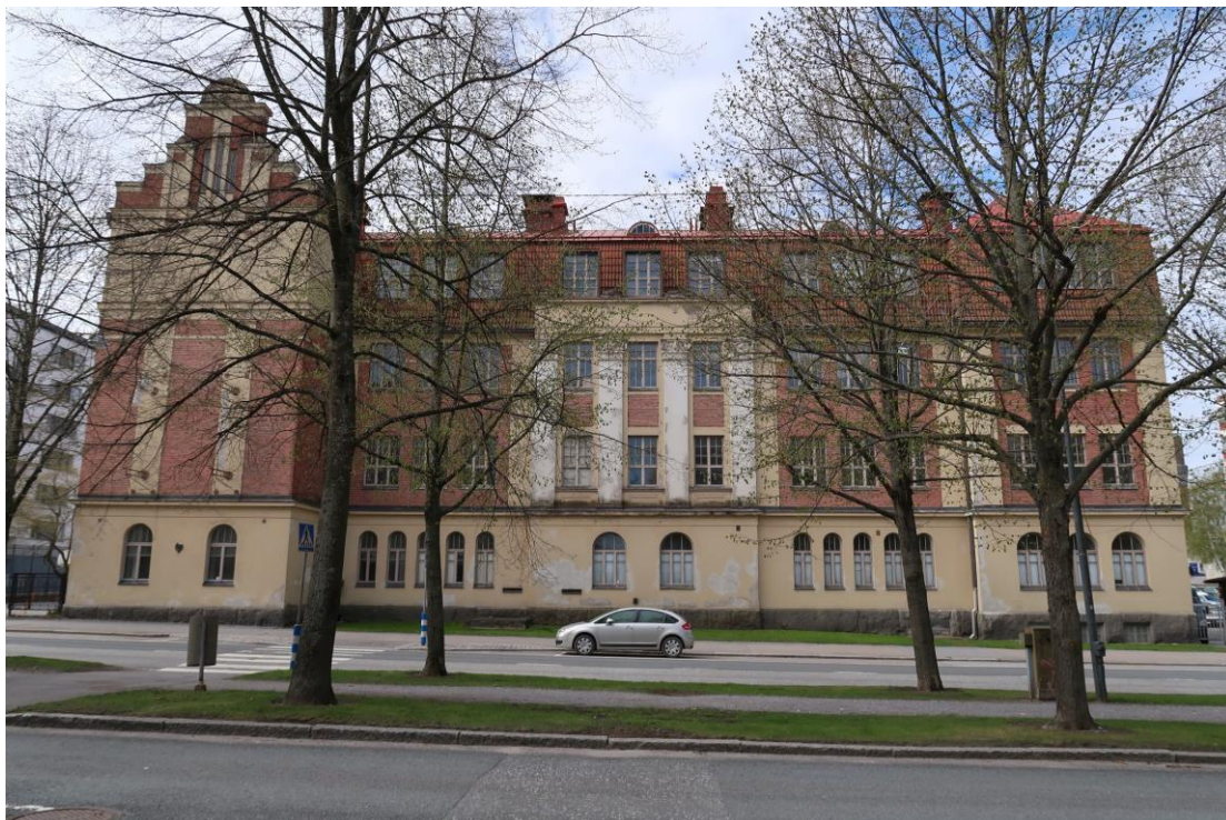
Kuva 70. Katujulkisivu vuonna 2021. Ikkunat on 2., 3. ja 4. kerroksessa ryhmitelty kolmen ryhmiin, alin kerros on poikkeava niin ikkunoiden muodon kuin ryhmittelyn osalta.
