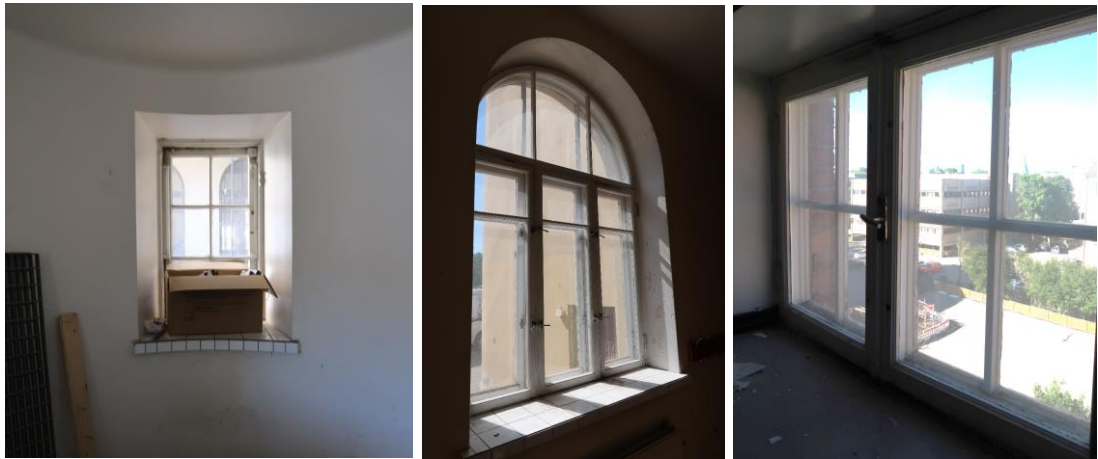
Kuva 76. Alkuperäisiä ikkunoita; tuulikaapissa, teknisen työn luokassa ja porrashuoneen ylimmät ikkunat.
