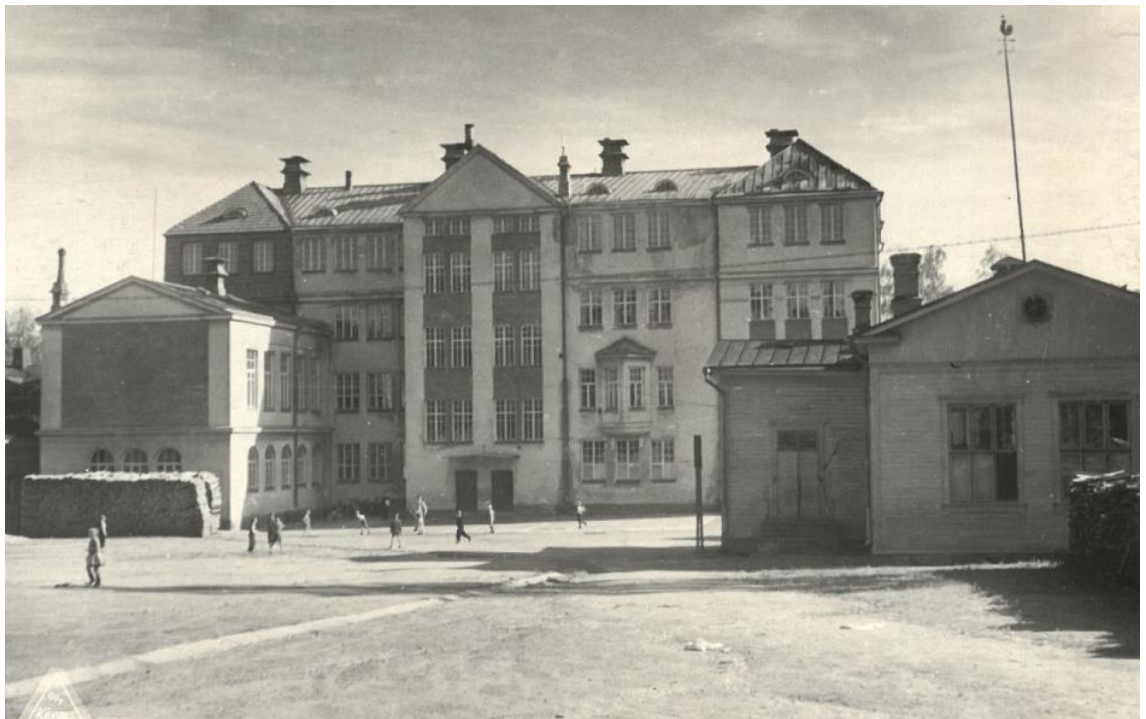
Kuva 43. Kuva vuodelta 1948 juuri ennen laajennusta. Julkisivujen rappaus- ja maalauspinnat ovat huonokuntoiset. Pihassa on vielä jäljellä vanha puurakennus. Kuva Vaasan kaupungin arkisto, Handelsesplanadens folkskola, kansio Vasa stads svenskspråkiga folkskolor Handelsesplanadens folkskola Fotografier 1908–1969.
