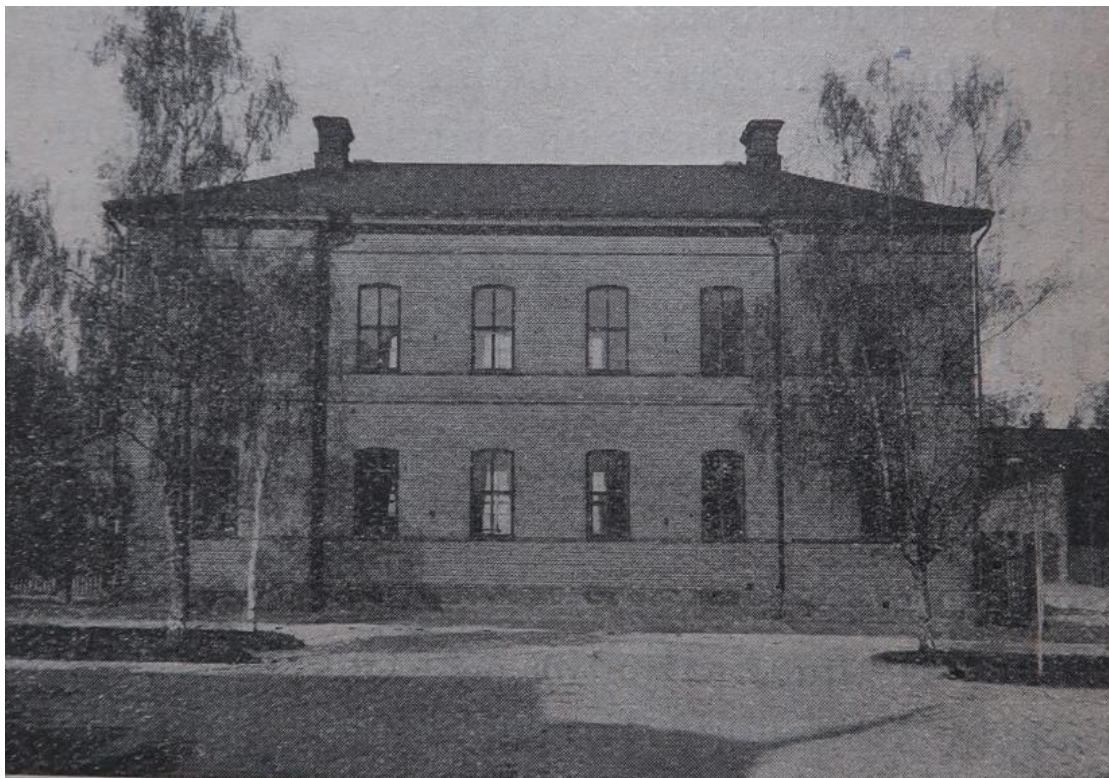
Kuva 3. Kivikoulun valokuva julkaisusta Vaasan kansakoulut 1869–1919. Rakennus oli hyvin yksinkertainen, julkisivut puhtaaksi muurattua tiiltä. Tontilla näkyy puita. (Svanljung s.188)
