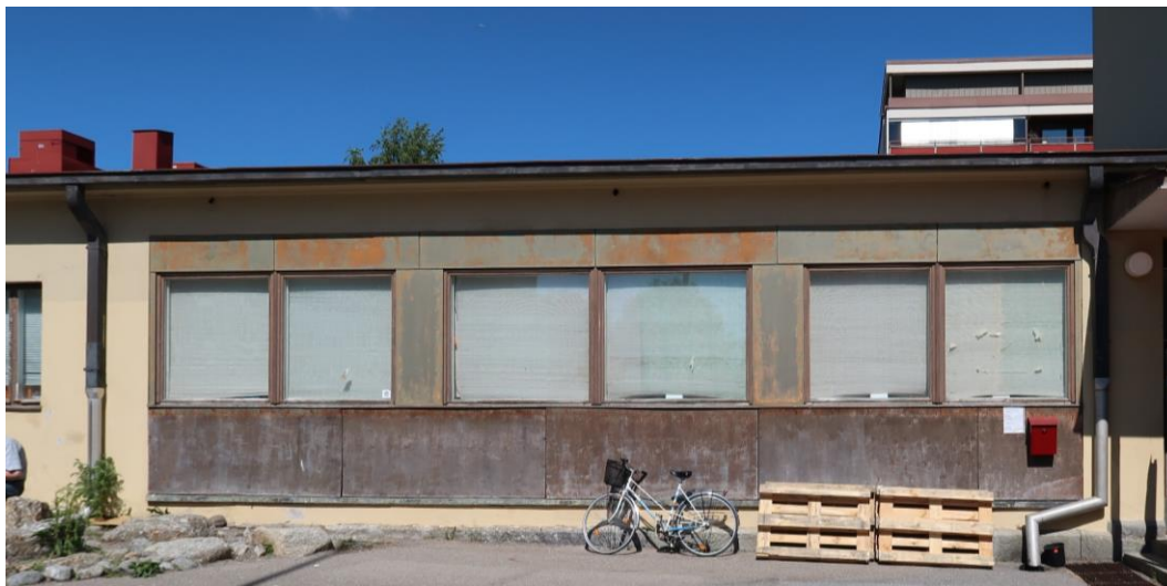
Kuva 78. Ruokalan lasitiiliseinä on muutettu osittain vaneripintaiseksi umpiseinäksi ja osittain tavallisiksi ikkunoiksi. Kuva 2021.
