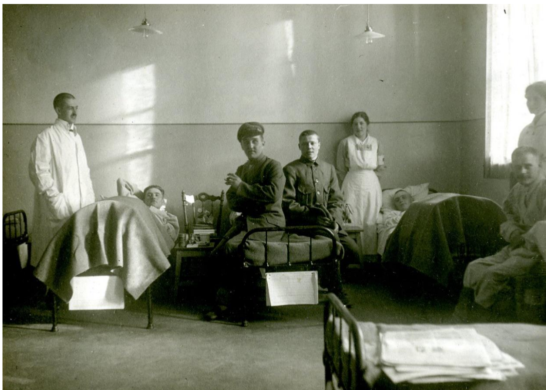
Kuva 20. Luokkatila 1918, kun rakennus toimi varasairaala n:o 1:nä. Seinän alaosa on tummempi ja yläosa vaaleampi. Välissä on ohut viiva. Kuva Pohjanmaan museon arkisto.
