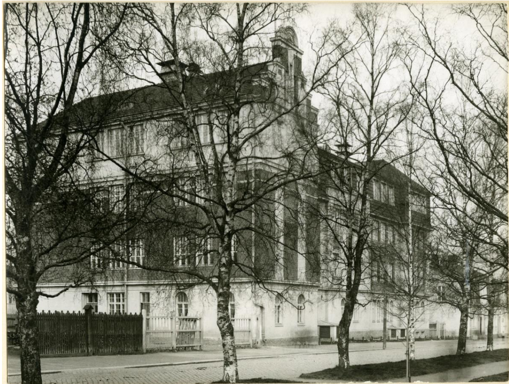
Kuva 39. Koulurakennus vuonna 1924. Ensimmäisen kerroksen rappaus on hieman vaaleampi kuin ylimmän kerroksen. Tuloilmakammioihin johtavat säleiköt ovat paikoillaan Kauppapuistikons varrella. Kuva Pohjanmaan museon arkisto.
