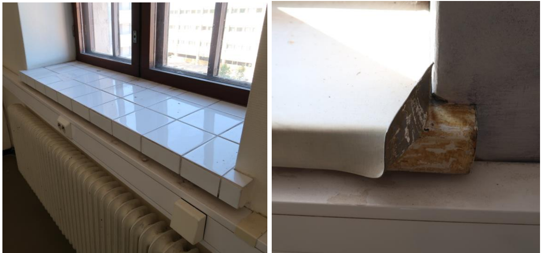
Kuva 68. Ikkunapenkit ovat joko laatoitettuja tai muovipinnoitettuja. Kuvat 2021.
