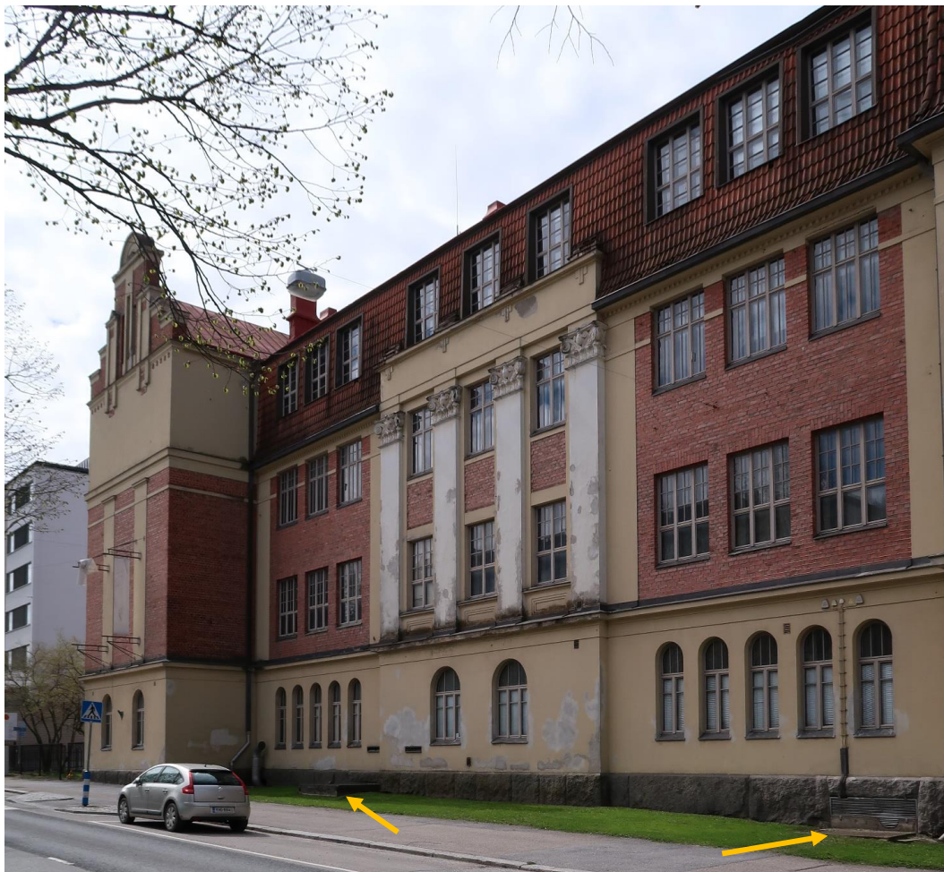
Kuva 77. Julkisivut ovat pääosin säilyttäneet piirteensä. Ilmanvaihtojärjestelmän raittiin ilman sisäänottoaukot näkyvät edelleen julkisivussa (nuolet). Kuva 2021.
