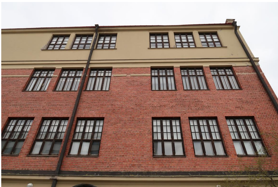
Kuva 71. Ikkunoissa on uusimisen yhteydessä säilytetty niiden puitejaon vaihtelu kerroksittain ja ikkunoittain. Kuva 2021.
