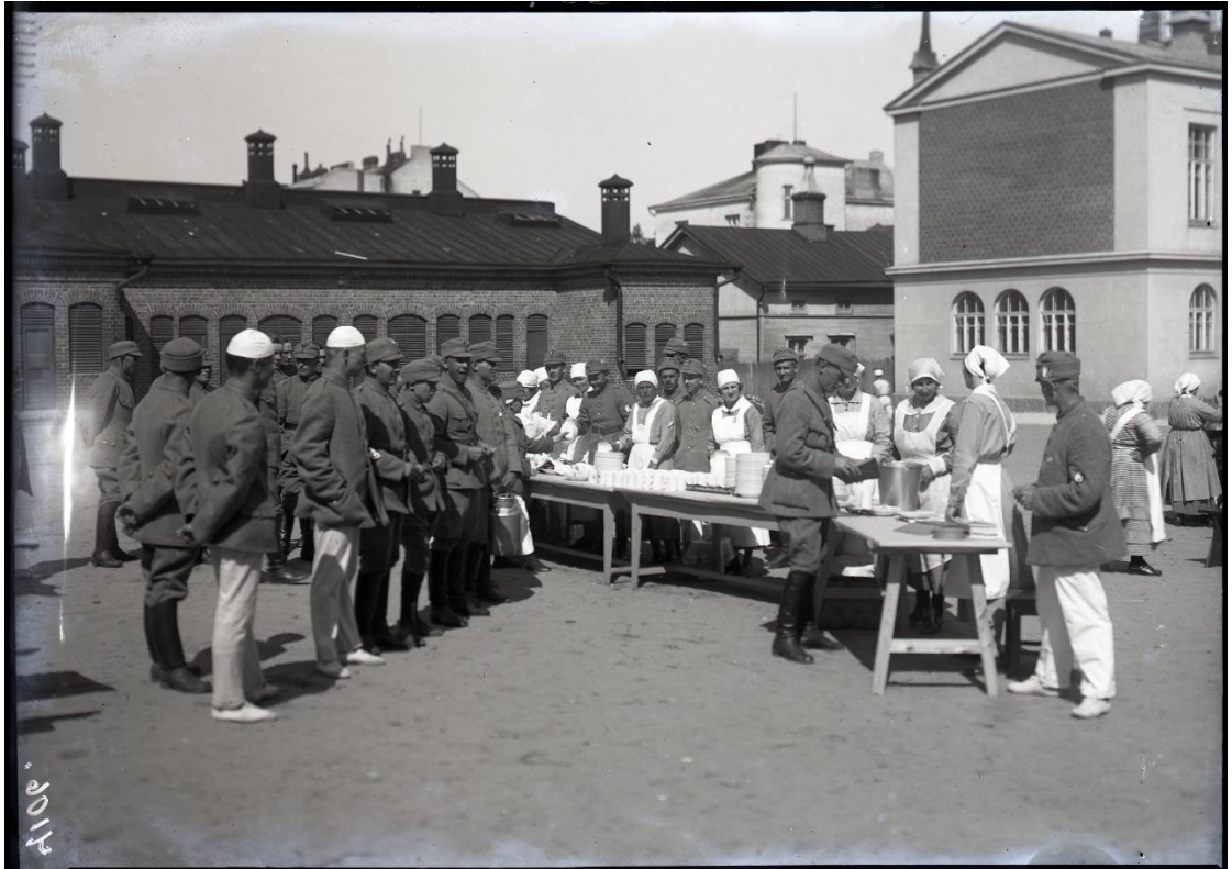
Kuva 49. Taustalla matala, tiilirakenteinen ulkokuone vuodelta 1903. Sen rakenteita hyödynnettiin ruokalan rakentamisessa. Kuva Pohjanmaan museo, valokuvaaja Uno Finnilä.
