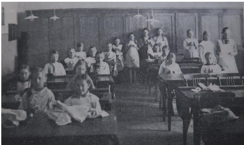
Kuva 23. Kuva tyttöjen käsityöluokasta kirjasta Vaasan kansakoulut 1869–1919 (Svaljung s.191). Kuvassa näkyy seinän alaosan tumma sävy ja maalattu raita sen yläosassa. Lisäksi kaapin vieressä seinässä on tuloilmasäleikkö lähellä lattiaa ja ylempänä seinässä poistoilmasäleikkö.
