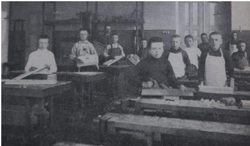
Kuva 22. Kuva veistosalista kirjasta Vaasan kansakoulut 1869–1919 (Svaljung s.190). Kuvassa näkyvät peiliovet, joka on maalattu kaksivärisiksi. Samoin seinän jako tummaan alaosaan ja vaaleaan yläosaan näkyy hyvin.
