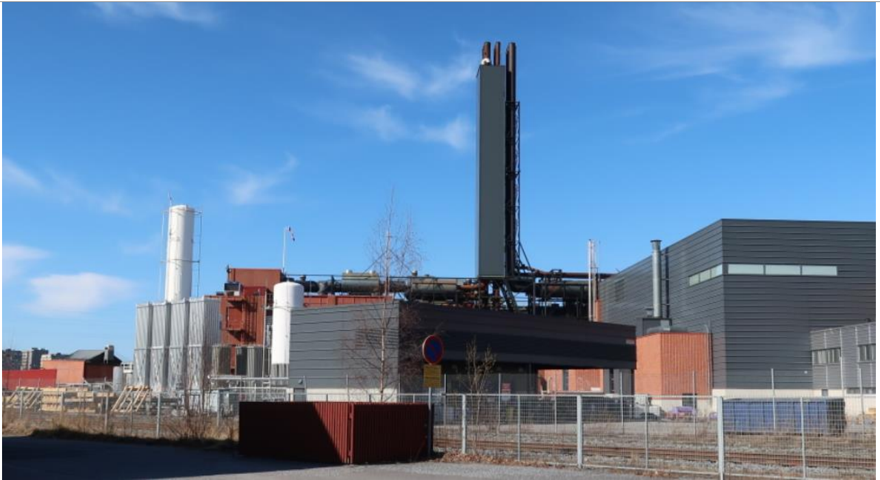
Näkymä radan eteläpuolelta. Varastorakennus etualalla, taustalla tehdasrakennukset
