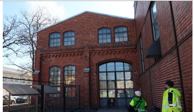
Vanhan rakennuksen pääty ja laajennusosa pohjoisen puolelle.
