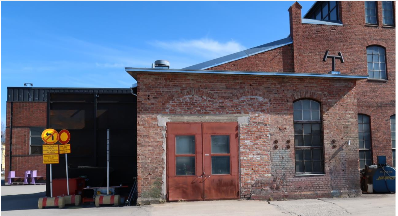
Laajennuksia vasemmalta 1980-luvulta, 2000-luvulta ja 1900-luvun alkuvuosikymmeniltä.
