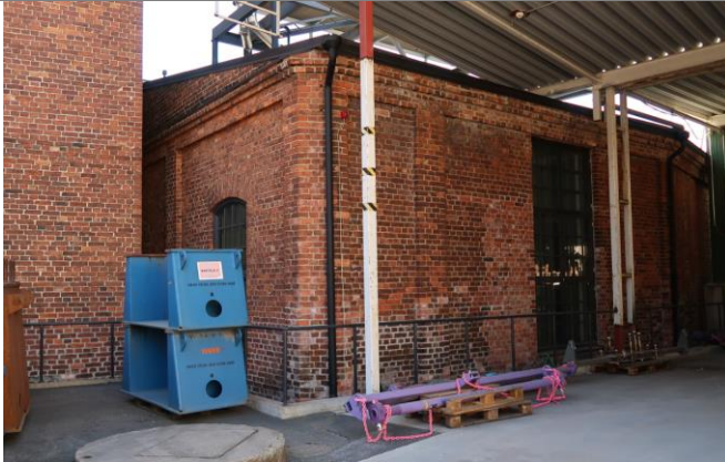
Vesitornin viereinen laajennusosa.
