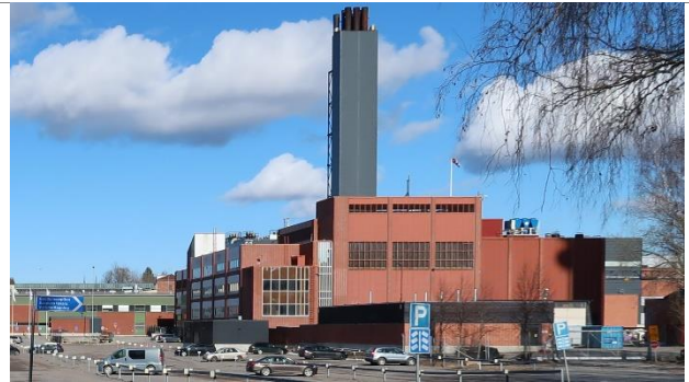
Julkisivu lännestä (Diesel-laboratorio).
