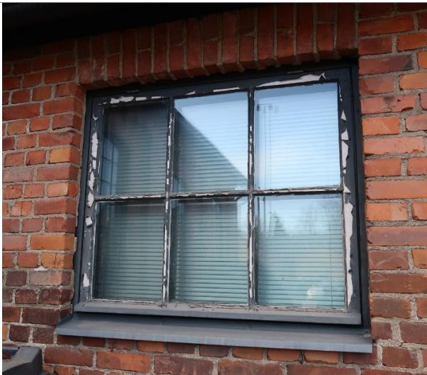
Laajennusosan matala ikkuna.
