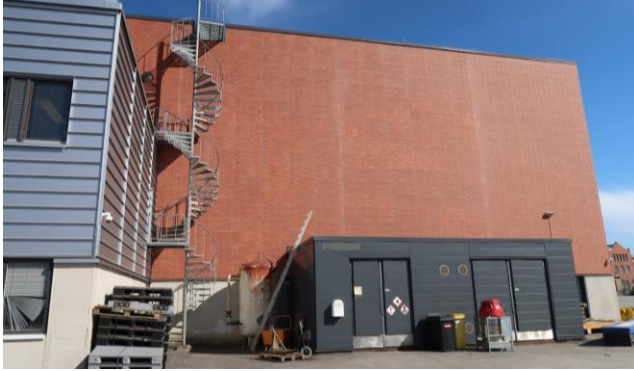
Julkisivu länteen. W-20-tehdas.
