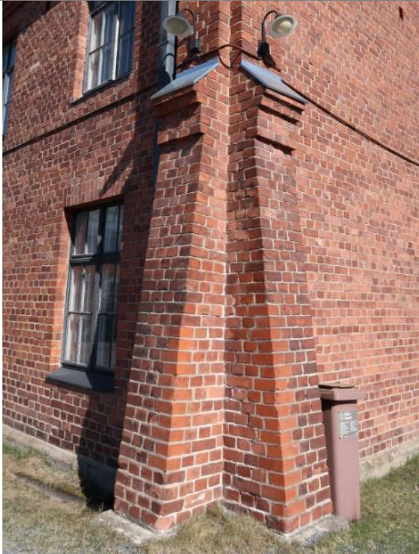
Julkisivun rakenteellinen pilarivahvistus.
