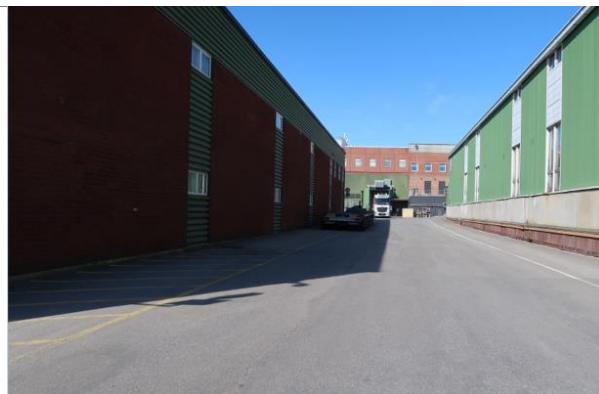
Julkisivua itään vieressä lähetystermiini.
