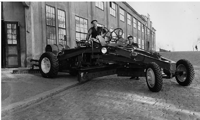
Tiekarhu Pitkädulla, 1930-luvulla. Sisäänkäynti vasemmassa reunassa. (Wärtsilä Finland Oy, 2008)
