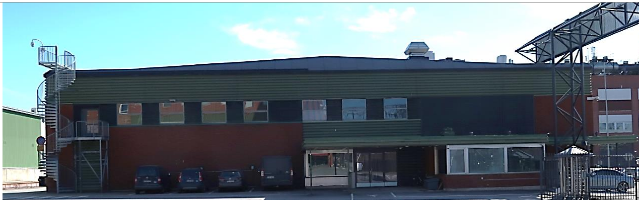
Julkisivu Kalastajan kadun suuntaan (sisäpiha).
