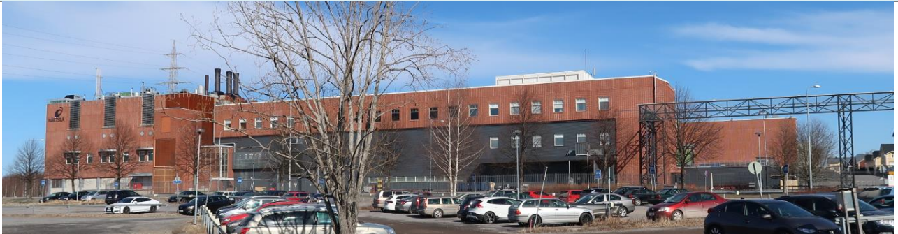
Julkisivu länteen Järvikadun suuntaan. Vasemmalla 1997 laajennus, keskellä 1982 laajennus, oikealla 1999 laajennus.
