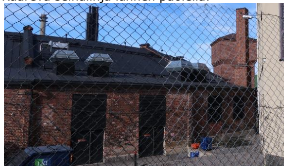
Julkisivua Pitkätien suunnasta.
