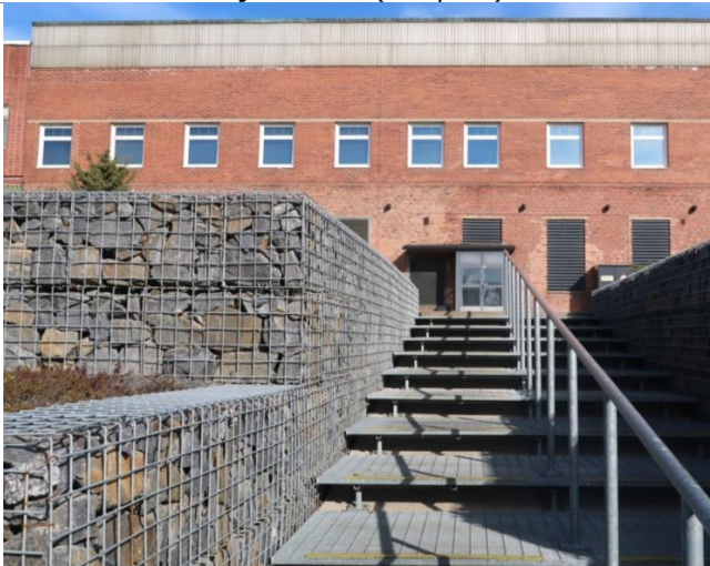
1.kerroksen vanhaa tiilijulkisivua.
