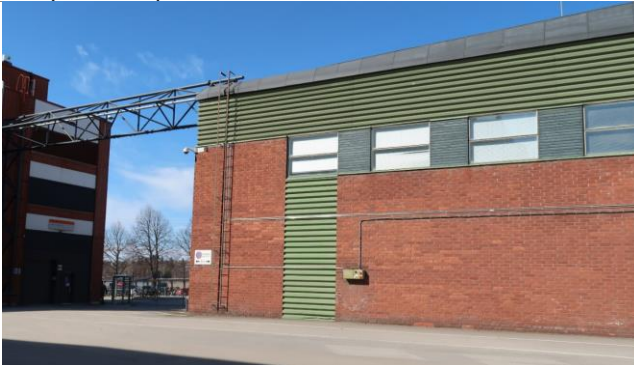
Julkisivua sisäpihalle (etelään).
