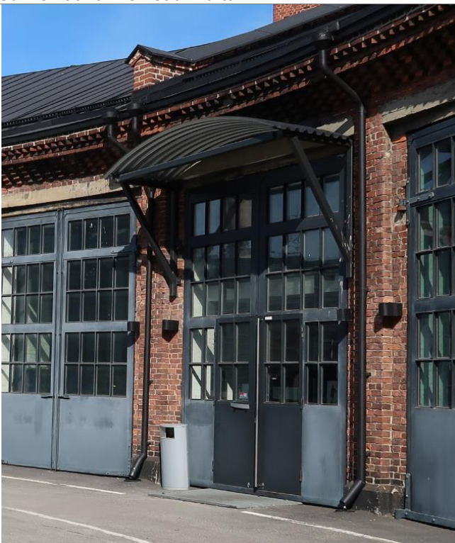
Lännen puoleinen sisäänkäynti.
