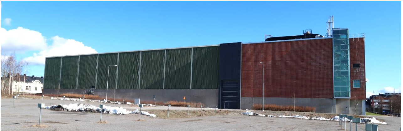
Julkisivu pohjoiseen Onkilahden suuntaan. Vasemmalla 1967 laajennus, oikealla 1997 laajennus.
