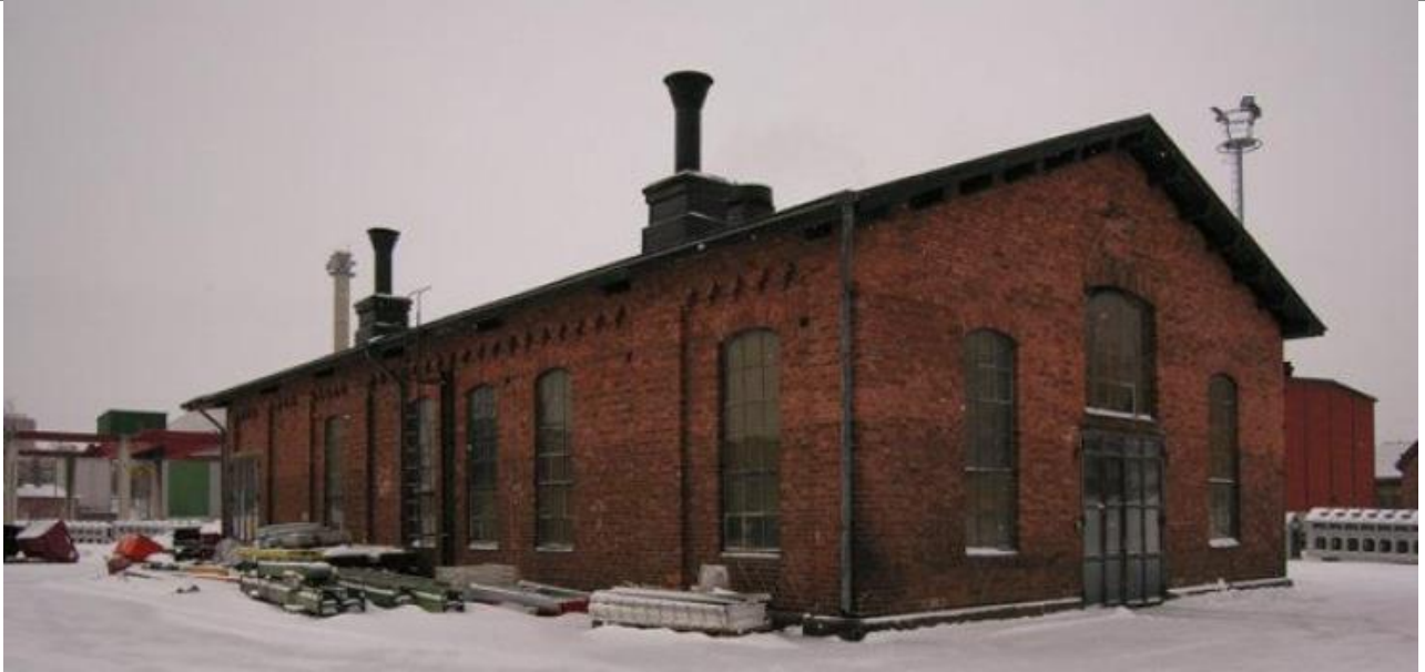
Rakennus ennen vuoden 2007 muutosta. (Wärtsilä Finland Oy, 2008)
