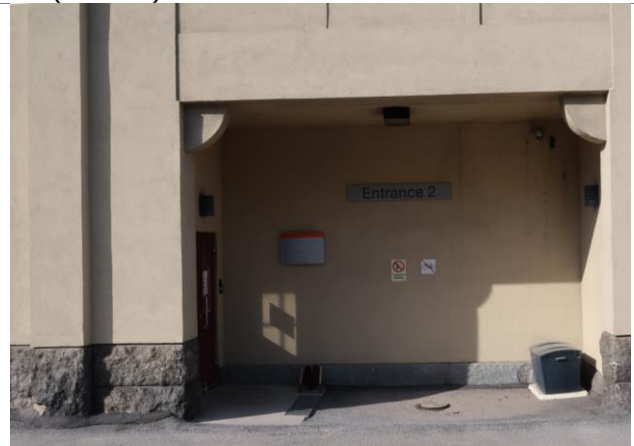
Pohjoisempi Pitkäkadun sisäänkäynti.
