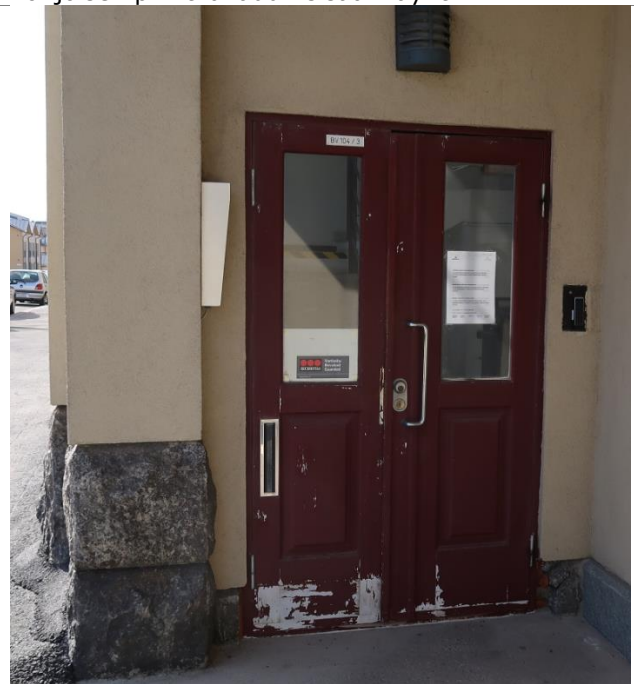
Pohjoisempi Pitkäkadun sisäänkäynti.
