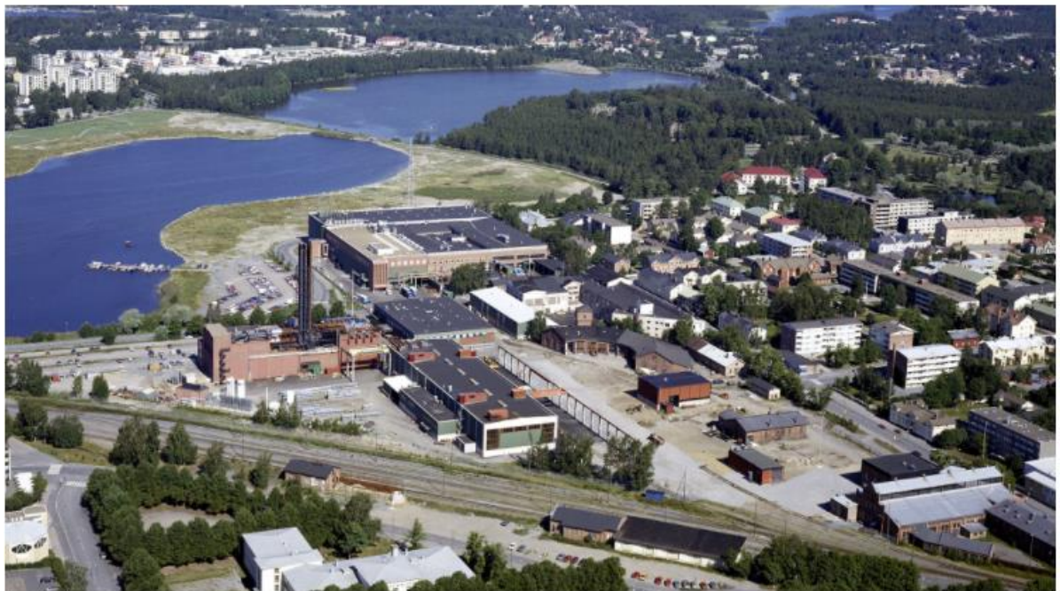
Kuva 4-10. Viistoilmakuva Wärtsilän Vaasan tehdasalueelta ennen 2000-luvulla tehtyjä uudisrakennuksia. Kuvalähde: Wärtsilä (Wärtsilä.com, viitattu 6.5.2021).
