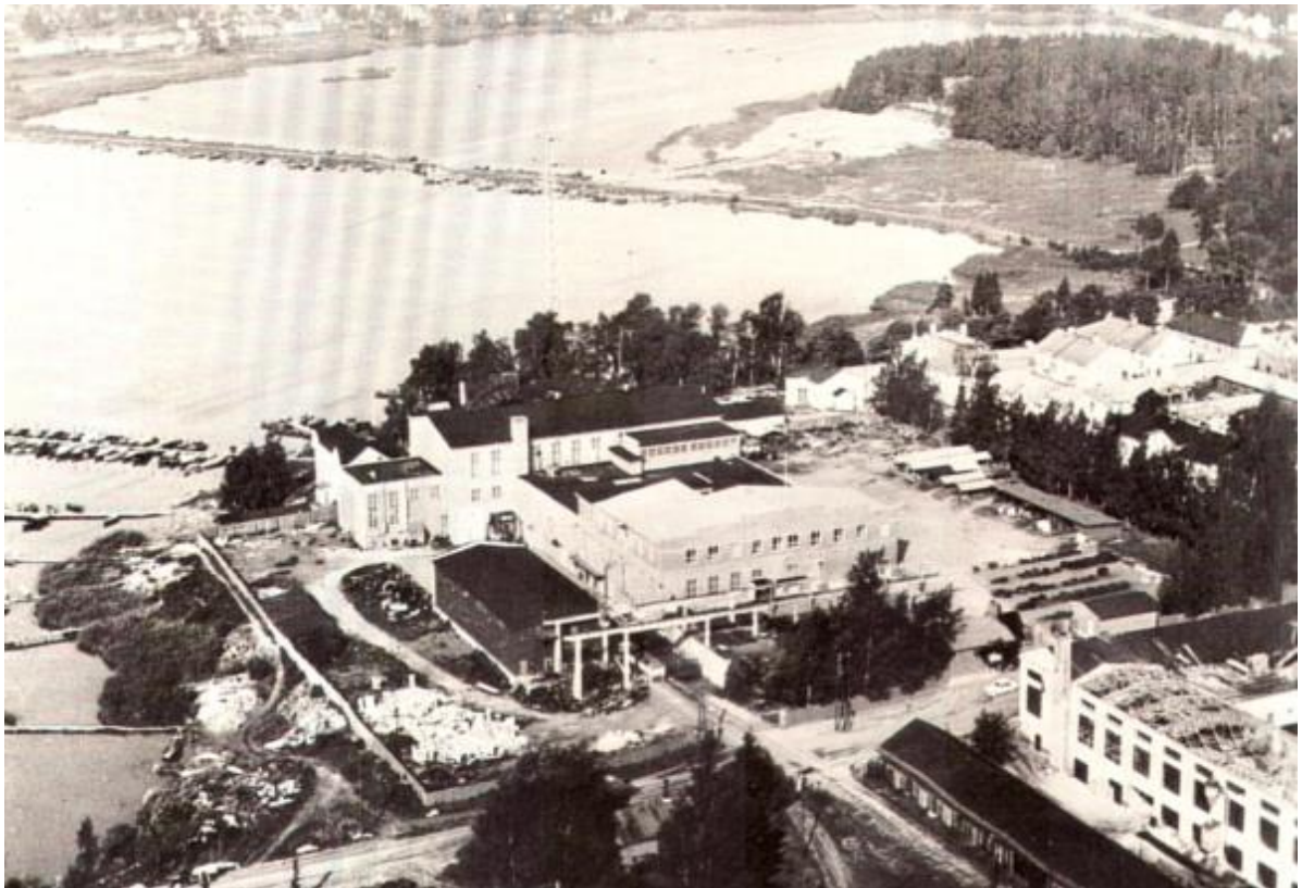
Kuva 4-8. Vaasan konepaja v.1960 ennen dieselmootorituotantoon erikoistumista varten suoritettuja laajennuksia. Kuvalähde: Arkkitehtitoimisto Nurminen Antila & Co Oy 2008.
