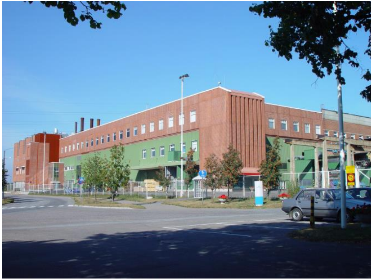
Kuva 4-9. Dieseltehtaan laajennus vuodelta 1982. Kuvalähde: Arkkitehtitoimisto Nurminen Antila & Co Oy 2008.
