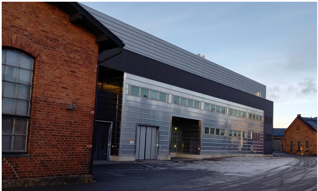
Monteringshallen har byggts ihop med den gamla smedjebyggnaden och delvis kring den så att det har varit möjligt att bevara den skyddade byggnaden.
