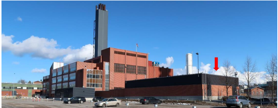
Diesellaboratoriet fotograferat från parkeringsplatsen i väster.
