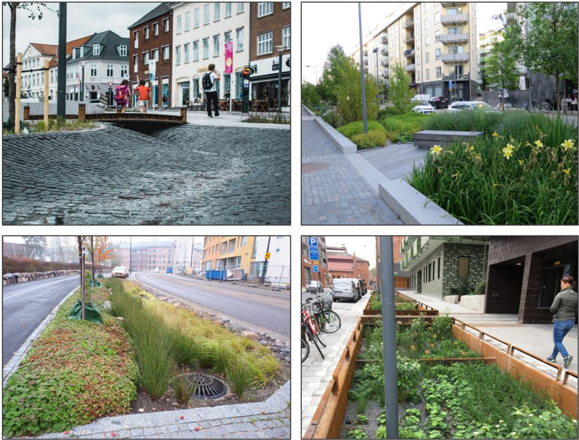
Kuva 5. Esimerkkejä hulevesirakenteiden yhdistämisestä bulevardityyppiseen kävelykatuun. Kuvat: Ramboll.
