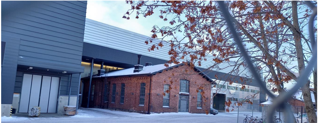
Punatiilinen rakennus on takomo, harmaa rakennus kokoonpanohalli
