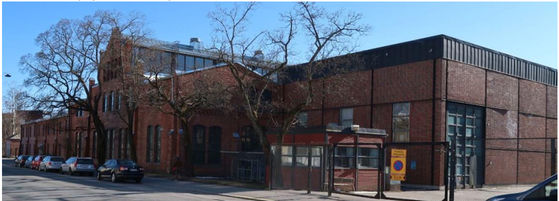
Kiertokankitehdas vuonna 2021. Kuva: Ramboll
