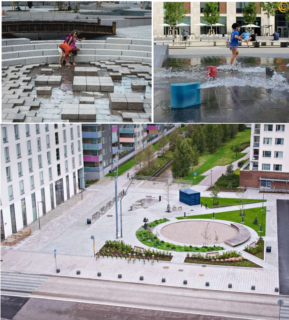
Kuva 15 Hulevesiaukiolla voidaan vettä hyödyntää elementtinä esimerkiksi leikissä. Aukion pyöreää muotoa hyödynnetään. Alempi kuva on Espoon Lukutorilta, jossa tehtiin paikallista hallintaa. Lisäksi kuvassa näkyy, kuinka purouoma kulkee aukion ali (tässä viitaten hulevesipuiston uomaan, joka myös osittain menee aukion ali). Kuvat Ramboll.
