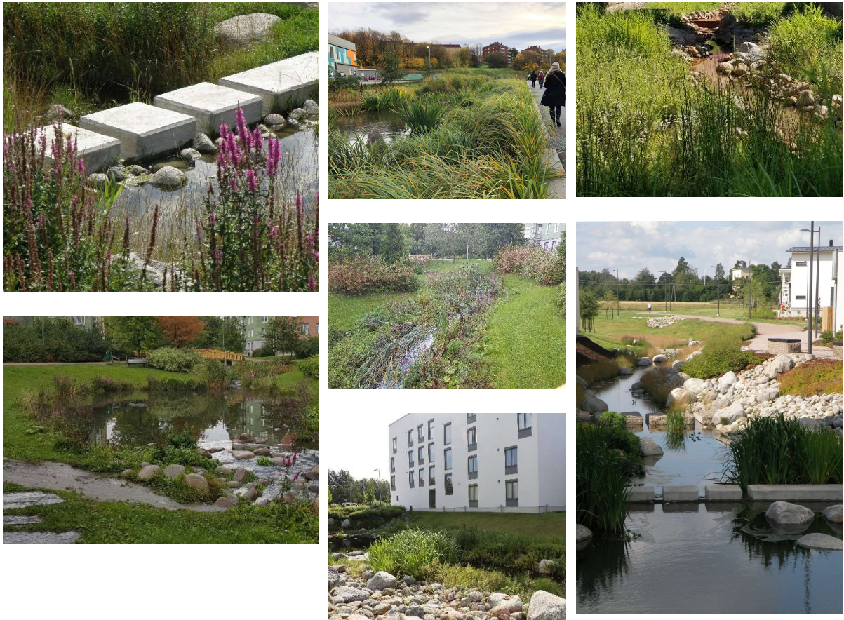
Kuva 16 Vesien johtaminen hulevesipuiston avouomaan. Runsas kasvillisuus viivyyttää vesiä ja pidättää kiintoainesta ja ravinteita.
