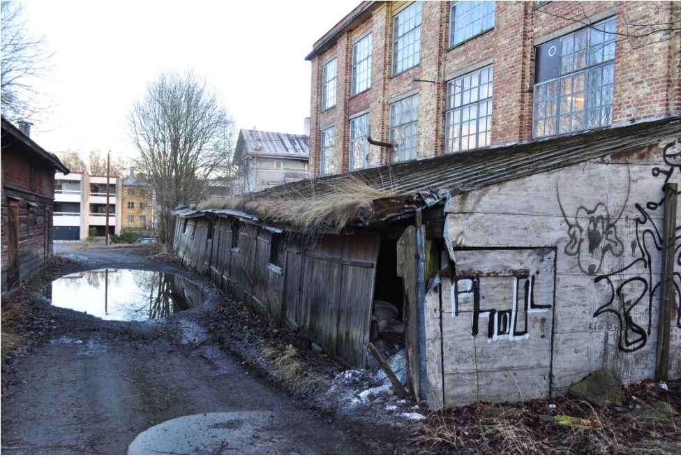
Kuvat 10 ja 11. Vanha saippuan tehdasrakennus vuonna 2015.
