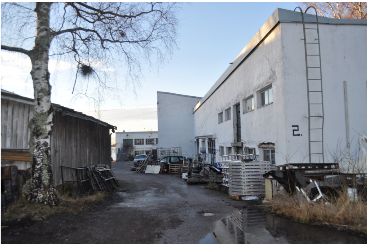
Kuvat 6,7 ja 8. Tontin luoteissivulla sijaitseva tehdasrakennus muodostuu eri-ikäisistä osista. Kuvassa 7 oieva osa on jäljelle jäänyt osa vuonna 1890 rakennetusta sianteurastamon rakennuksesta.
