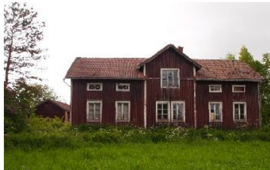
Asuinrakennus (A) idästä kuvattuna. Vasemmalla ulkorakennus (C).
