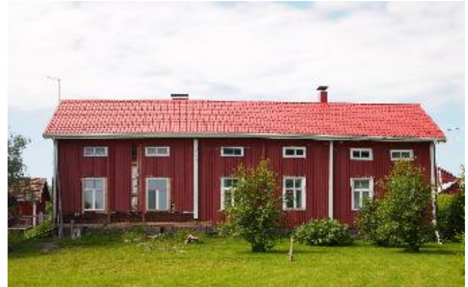
Asuinrakennus (A) idästä kuvattuna. Vasemmalla pilkottaa aitta (B).
