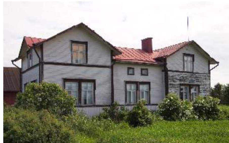
Asuinrakennuksen (A) julkisivu tielle.
