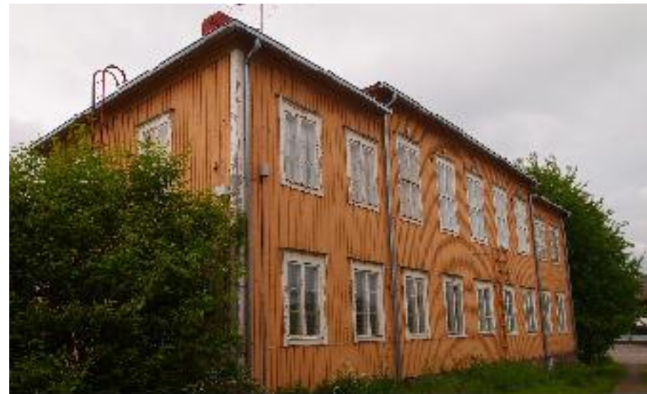
1920-luvulla entinen puolitoistakerroksinen talonpoikaistalo korotettiin vastaamaan kunnantalon toimitilar tarpeita. Lounaasta kuvattuna.
