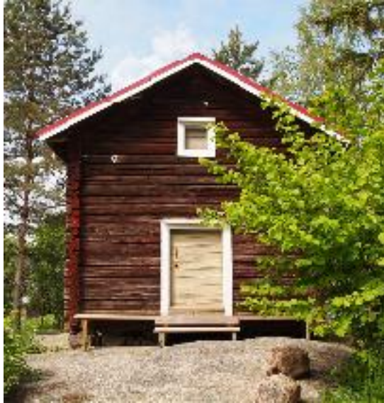
Aitta (E) kaakosta kuvattuna.
