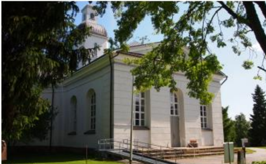
Kirkko (A) lounaasta kuvattuna. Esteettömyysramppi ja asfaltoinnit ovat ristiriidassa ympäristön arvokkuuden kanssa.
