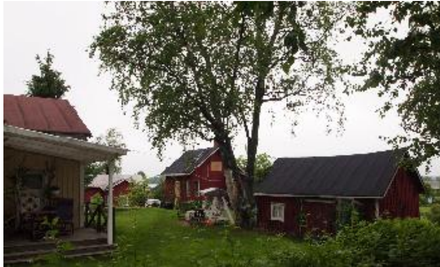
Oikealla ulkorakennus (B), keskellä uudempi sauna. Taustalla pilkottaa erillinen asuinrakennus (C).
