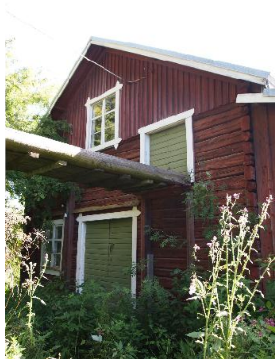
Vesimyllyn (C) pääjulkisivu luoteeseen. Toiseen kerrokseen johtavaa myllysiltaa pitkin viljasäkit kuljetettiin kiskoja pitkin myllyyn.
