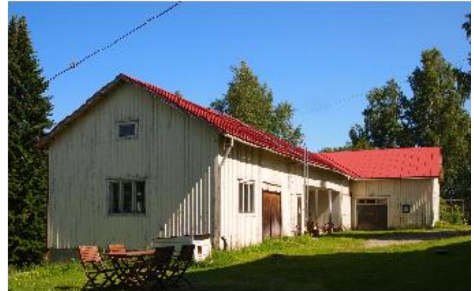
1950-luvun piharakennus (B)länneästä kuvattuna.
