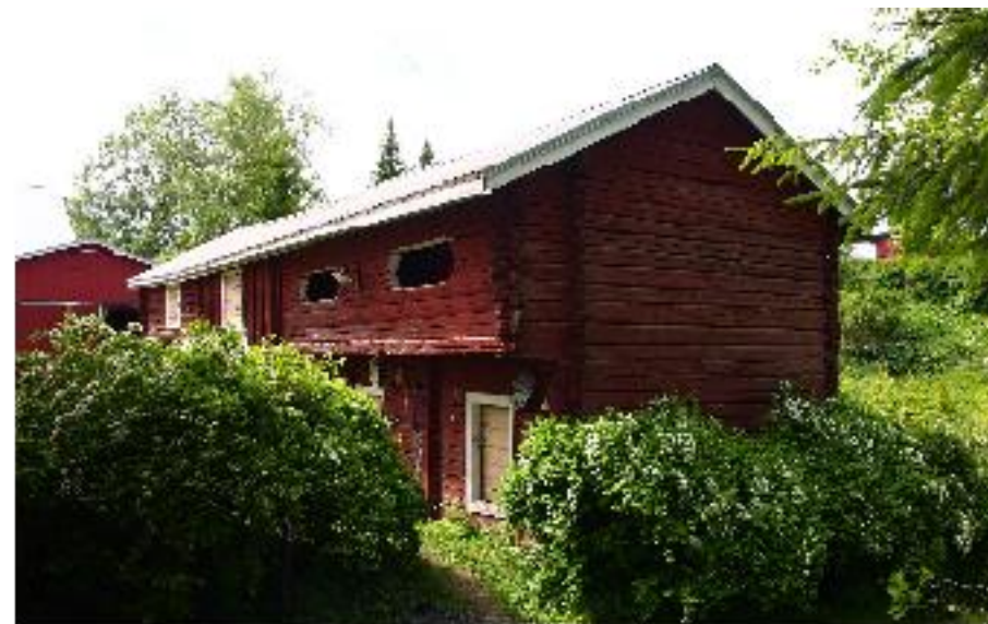
Ulkorakennuksen (A) luttirivi pohjoisesta kuvattuna.
