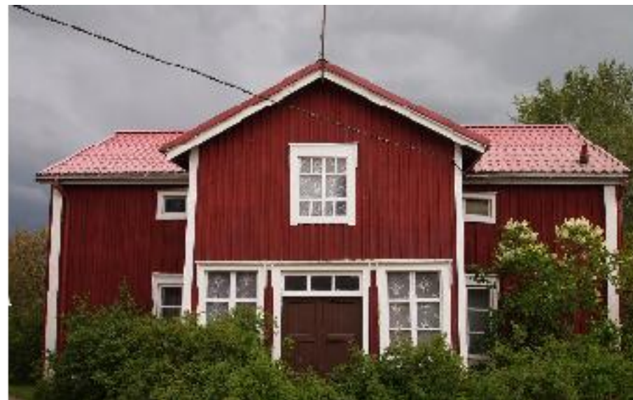
Asuinrakennus (C), pihasta kuvattuna.
