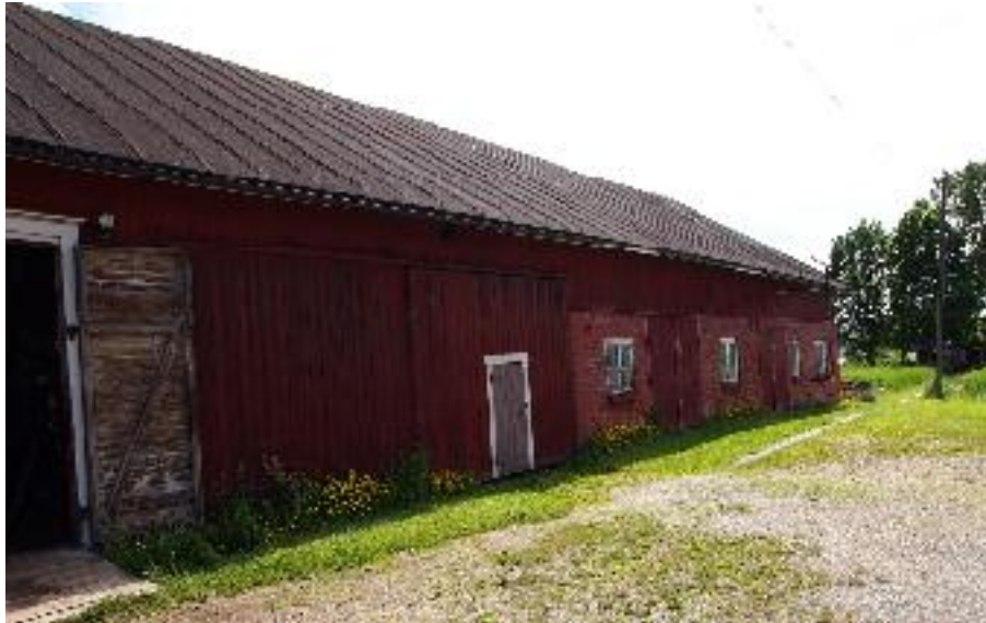
Ulkorakennus (B) rajaa pihapiiriä Kyrönjoen suuntaan. Luoteesta kuvattuna.
