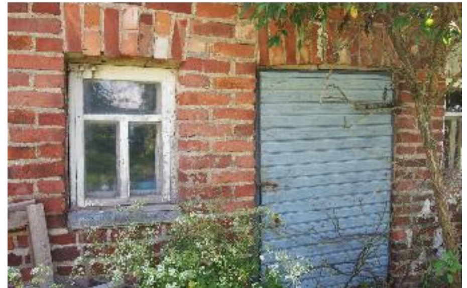
Ulkorakennuksen pihanpuoleisen julkisivun yksityiskohtia.
