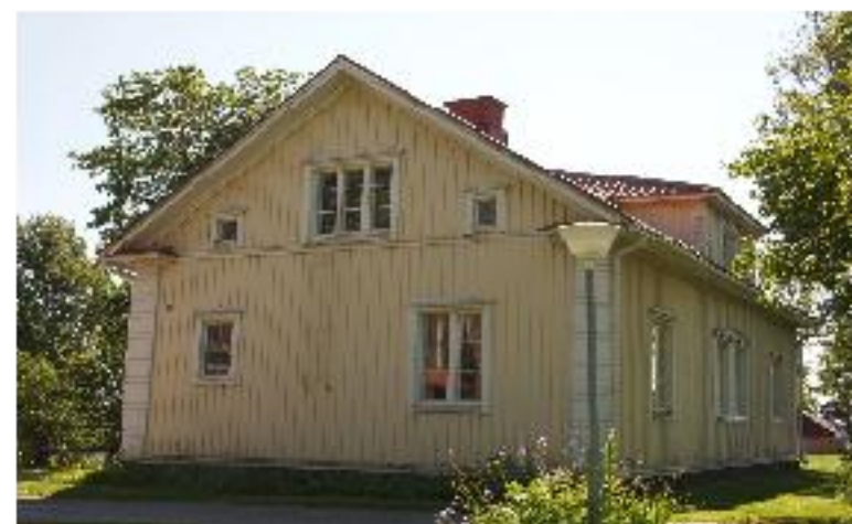
Pohjoispääty ja vähänkyröntienpuoleista julkisivua.
