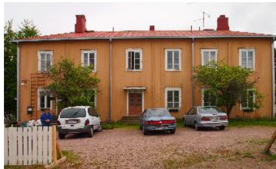
Entisen kunnantalon pohjoiseen viettävässä pääjulkisivussa on tyypillinen 1920-luvun sisäänkäynti.
