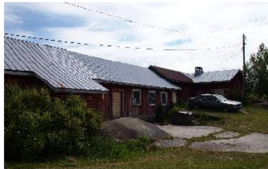
Ulkorakennus (C) luoteesta kuvattuna.
