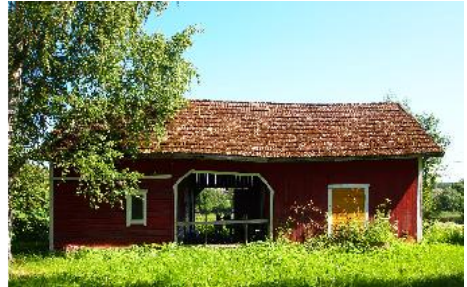
Asuinrakennuksen (A) julkisivu joen suuntaan.
