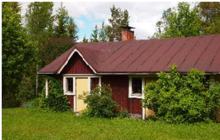
Piharakennus (C) pihanpuolelta, etelästä kuvattuna.
