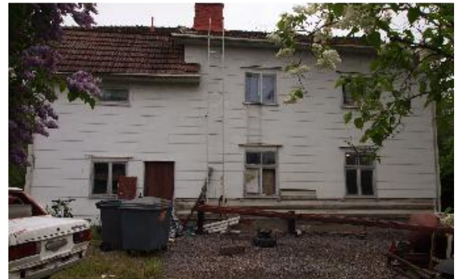
Vaiheittain laajennetun asuinrakennuksen kaakonpuoleinen julkisivu.
