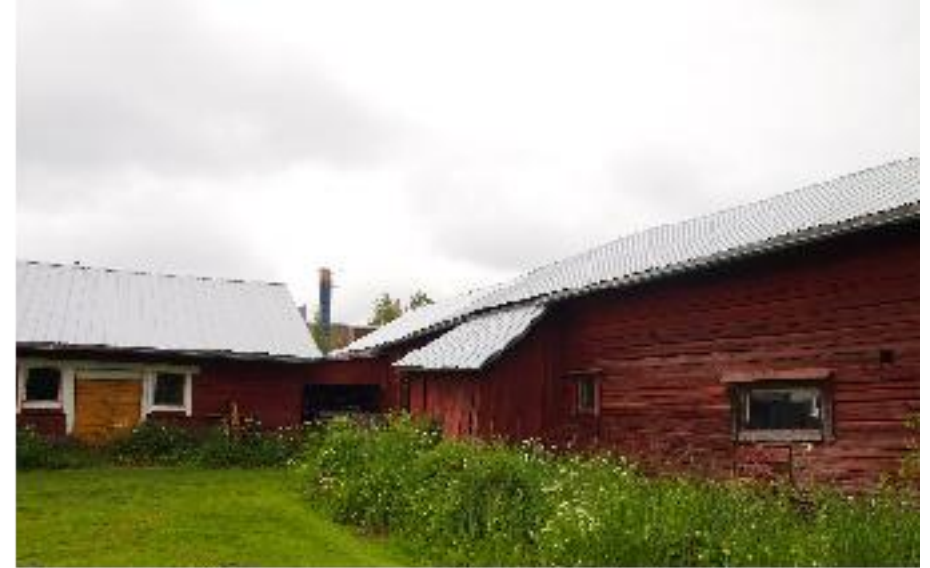
Ulkorakennus (C) vasemmalla ja (D) oikealla etelästä kuvattuna.
