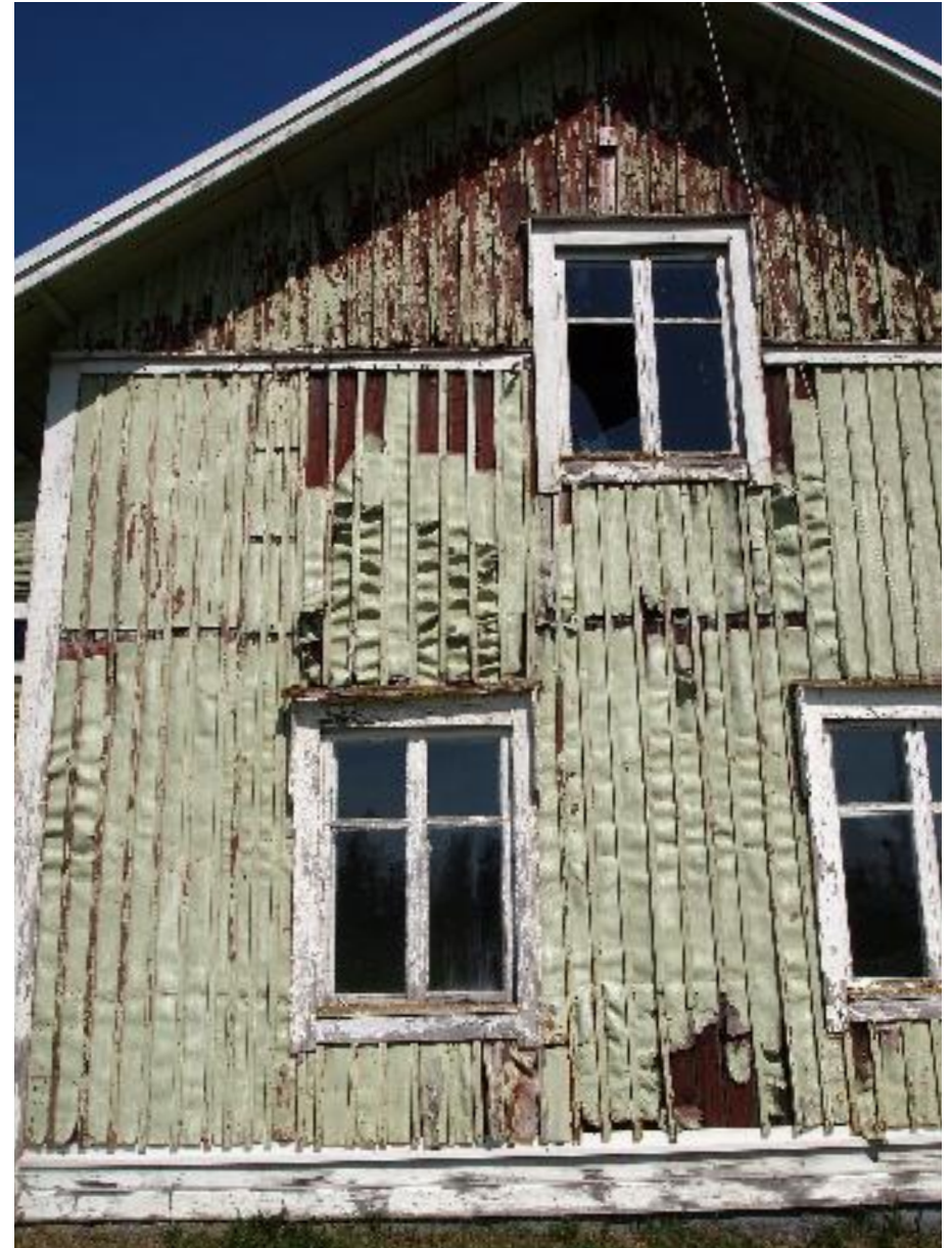
Alkuperäinen rimalaudoitus on tallella huonokuntoisen kovalevyn alla. Eteläpuoleinen pääty.
