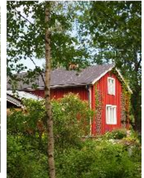
Rakennuksen asuttopääty etelään.
