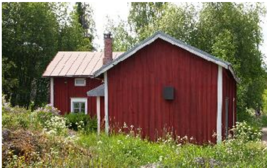
Piharakennus (B) koillisesta kuvattuna.
