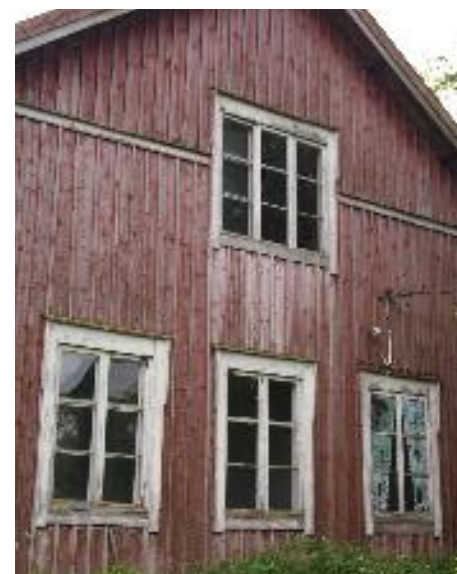
Asuinrakennuksen (A) pääty pohjoiseen.
