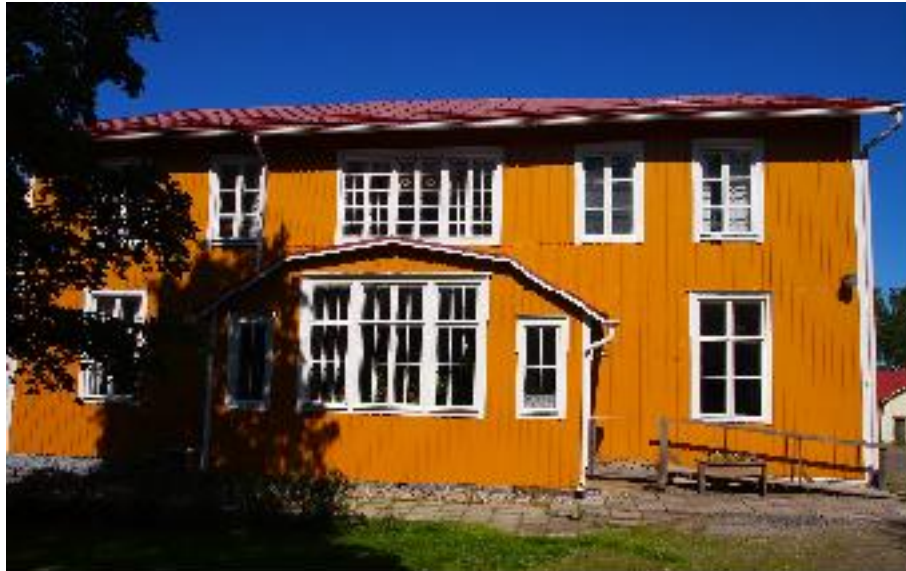
Päärakennus (A) etelästä kuvattuna, taustalla oikealla häämöttää piharakennus (B).
