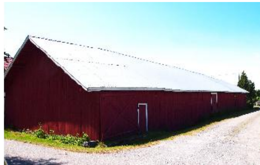
Kookas, tien varteen työntyvä ulkorakennus (C) on kyläkuvallisesti merkittävä.
