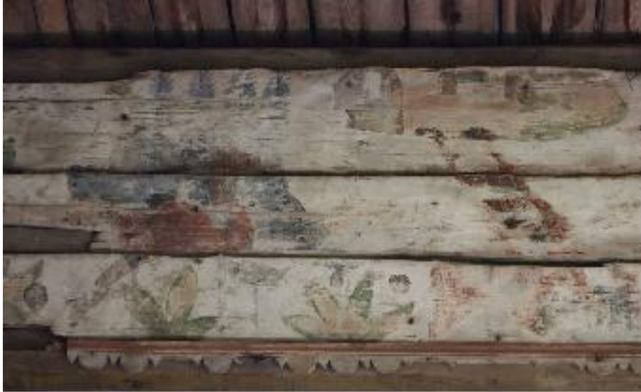
Uukongin rakennusaineena on uusiokäytetty vuonna 1641 rakennetun kirkon koriste-maalattuja sisäseinälankkuja. Sisäpuolelta kuvattuna.
