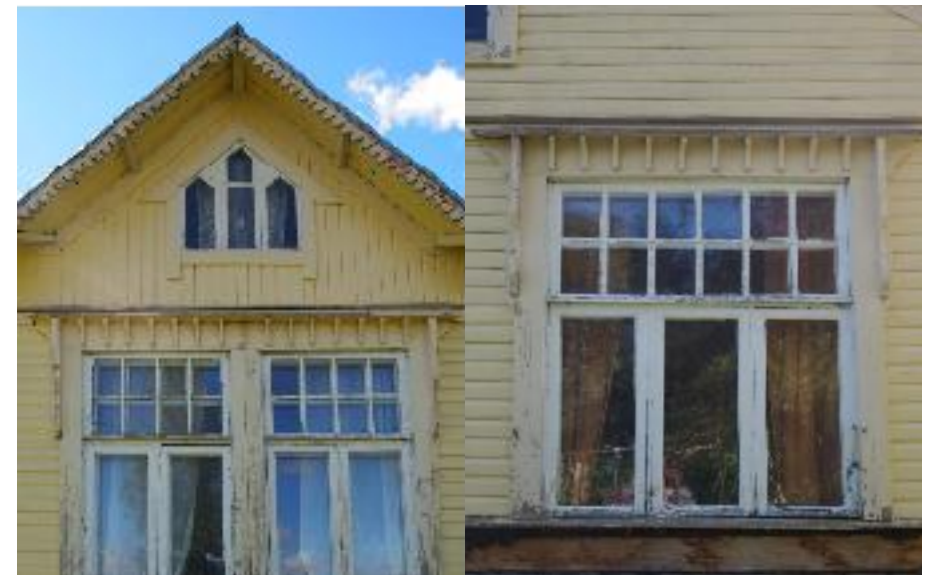
Rakennuksen alkuperäisiä yläosiltaan pieniruutuisia ikkunoita.
