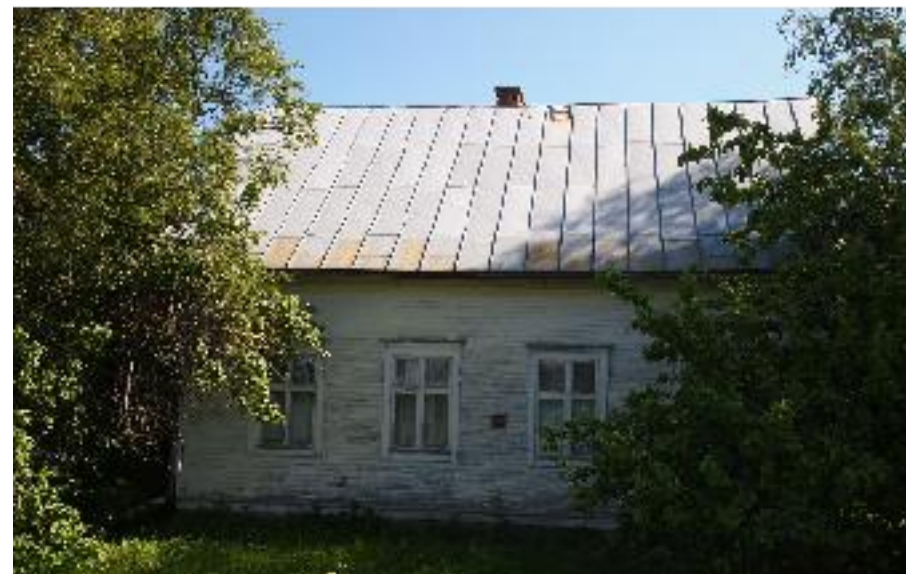
Asuinrakennuksen julkisivu Vähänkyröntielle länteen.
