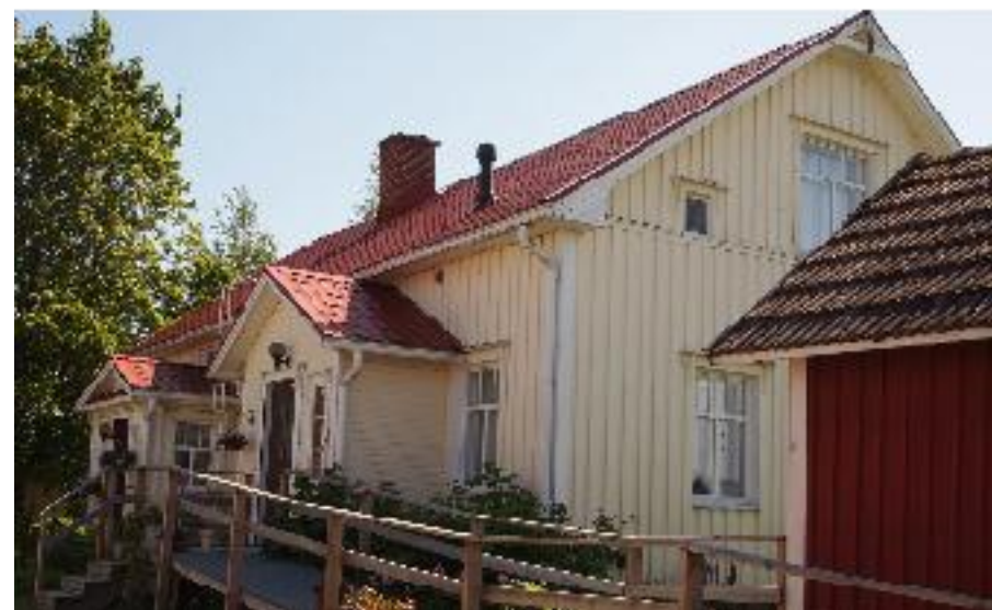
Asuinrakennuksen pihanpuoleista julkisivua kaksine kuisteineen. Oikealla näkyy piharakennuksen (B) nurkkaa.
