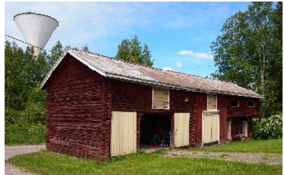
Ulkorakennus (A) kaakosta kuvattuna.
