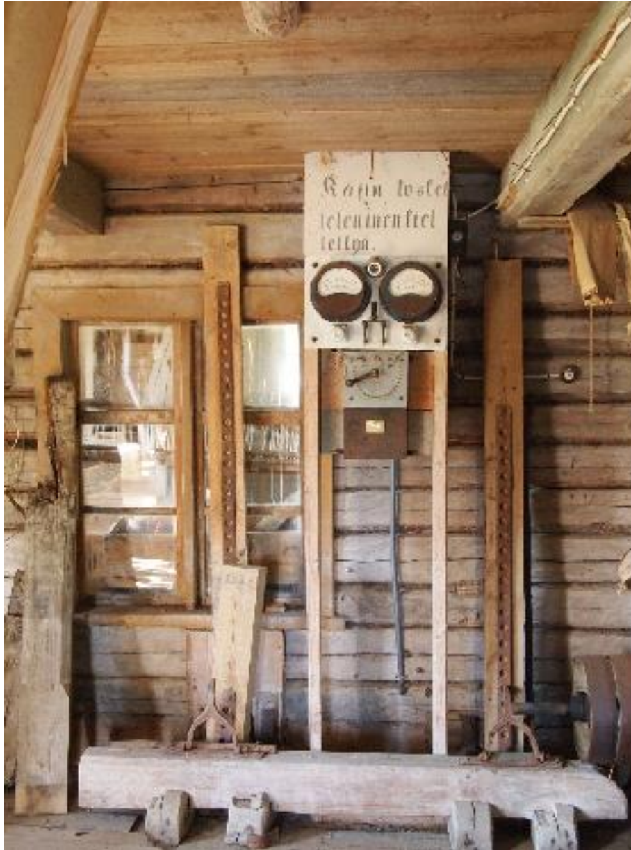
Vesimylly tuotti päiväsähkön viiteen rekiläläiseen talouteen. Iltakymmeneltä sähkögeneraattori sammutettiin yöksi.
