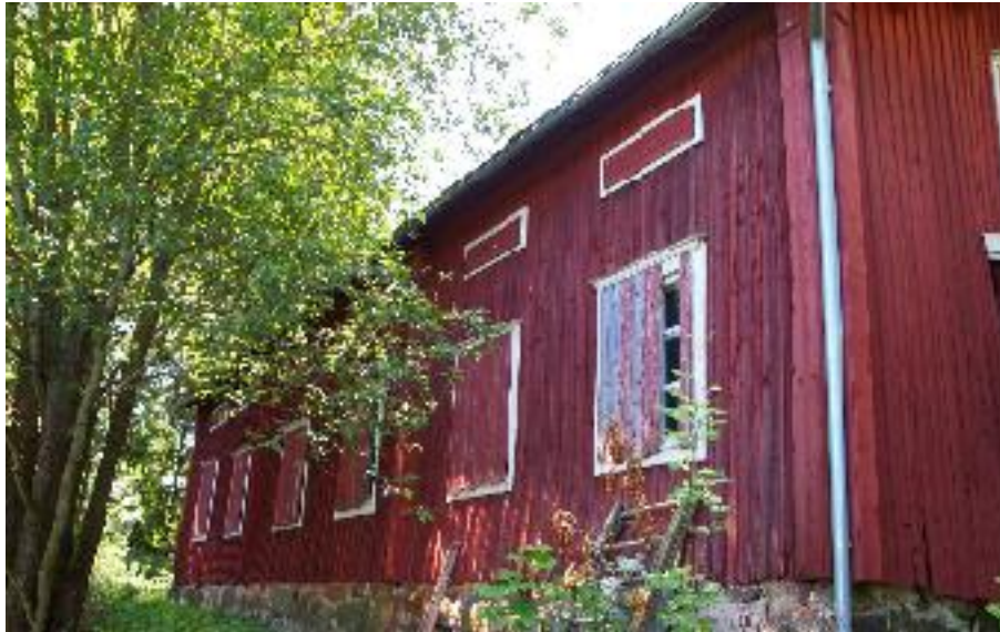
Asuinrakennuksen (A) julkisivu joen suuntaan.
