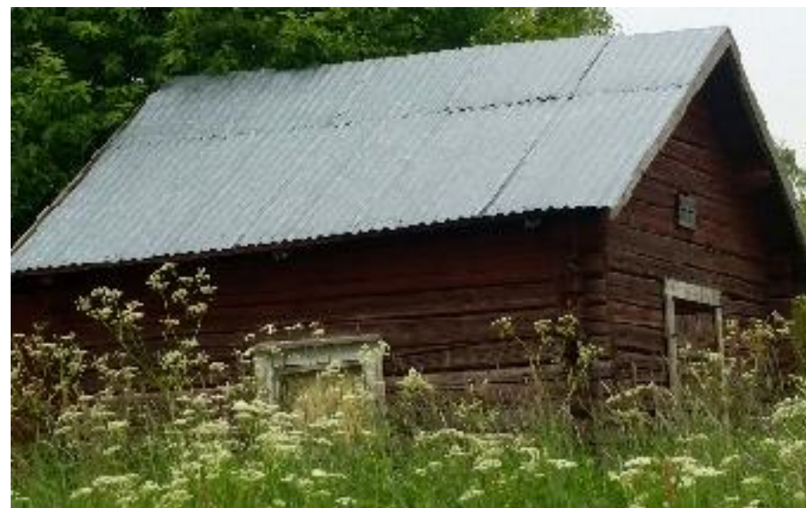
Ulkorakennus (B) kaakosta kuvattuna.
