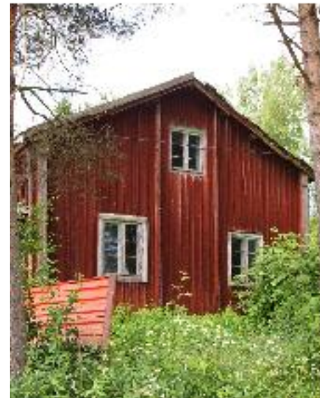
Rakennuksen idänpuoleista päätyä.
