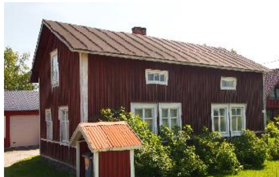
Asuinrakennuksen (A) tienpuoleinen julkisivu luoteesta kuvattuna.
