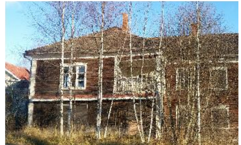
1930-luvun laajennuksen sisäänvedetty parveke lounaassa.
