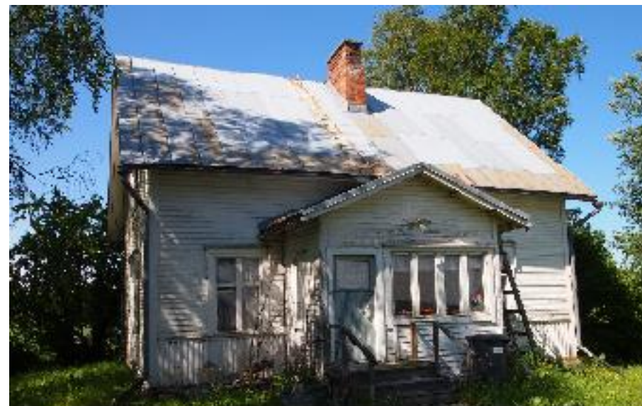
Pihan puolen julkisivua, idästä kuvattuna.
