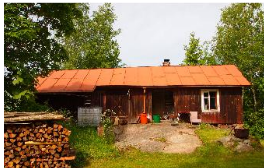
Piharakennus (B) kaakosta kuvattuna.
