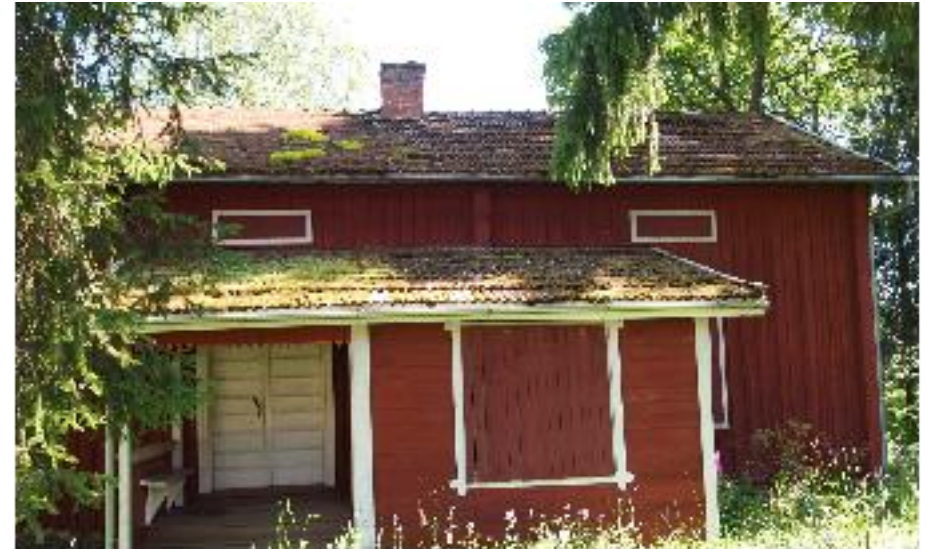
Kanttorin asuintalon (A) vaikeasti kuvattavaa julkisivua Savilahtitalon suuntaan. Länne- stä kuvattuna.
