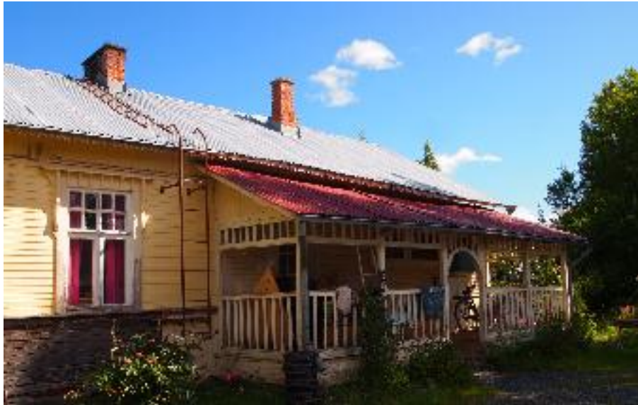
Rakennus on säilynyt alkuperäisasussaan. Luoteesta kuvattu.
