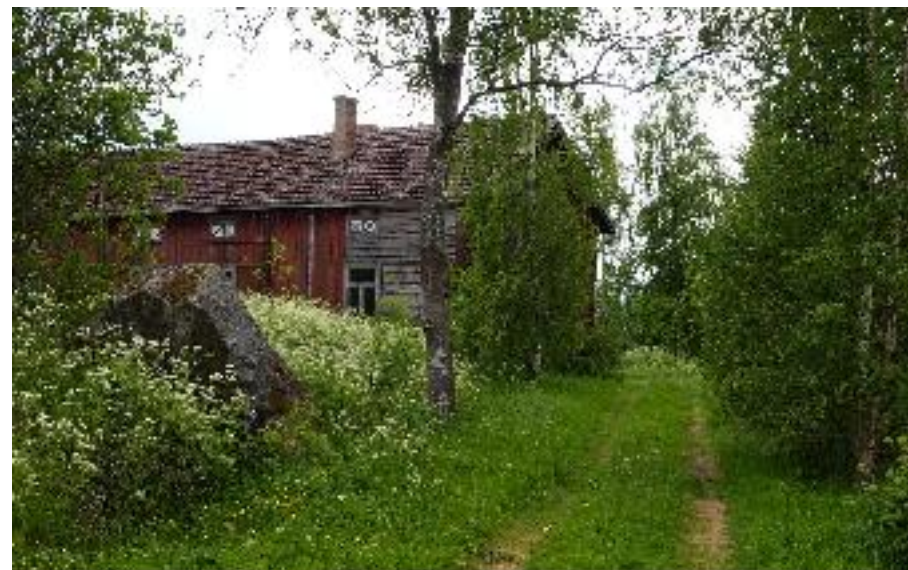
Kohdetta lähestytään perinteistä koivukujaa pitkin. Asuinrakennus (A) luoteesta kuvattuna.
