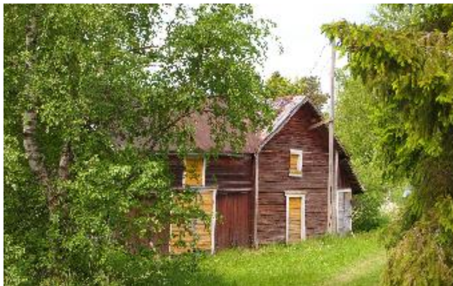
Ulkorakennus (D) rajaa pihaan vievää tietä. Pihan suunnasta kuvattu.
