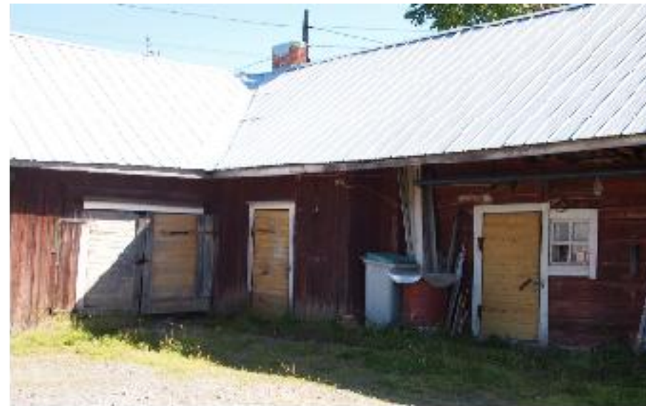
Ulkorakennus (B) on takaosiltaan alkuperäisasussa. Luoteesta kuvattuna.
