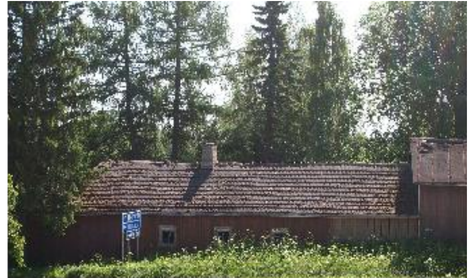
Ulkorakennuksella (B) on positiivinen vaikutus tietilaan. Pohjoisesta, kirkon paikoitus-alueelta kuvattuna.
