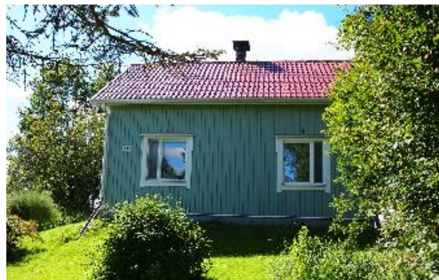
Asuinrakennuksella (A) tien suunnasta, koillisesta kuvattuna.
