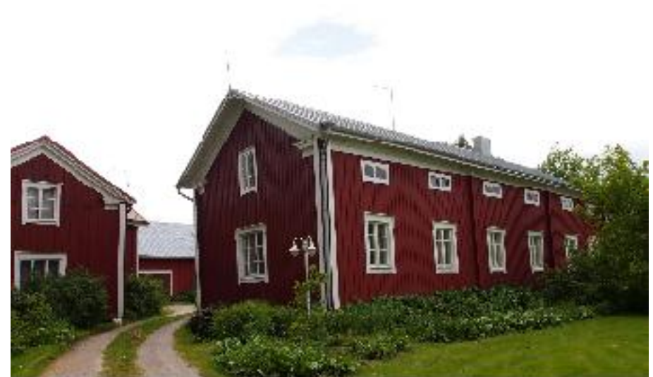
Kohteen asuinrakennukset rajaavat suojaisan sisäpihan, jolle kuljetaan rakennusten välistä. Vasemmalla asuinrakennus (C), oikealla (A).
