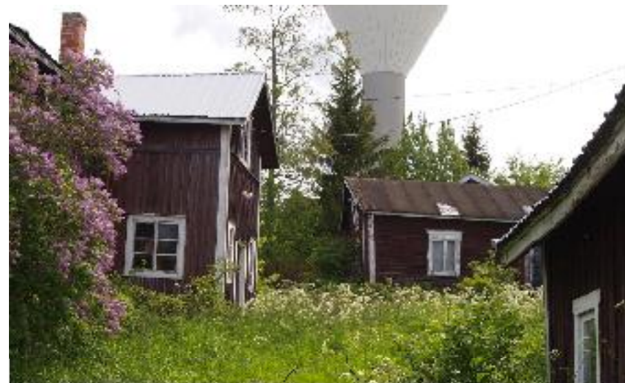
Näkymä luoteesta pihapiiriin astuttaessa. Vasemmalla asuinrakennus (A), oikealla sauna (C) ja taustalla vähätupa (D)
