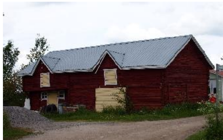
Luttirakennuksella (A) on merkittävä maisemallinen arvo tien viereisen sijaintinsa johdosta.
