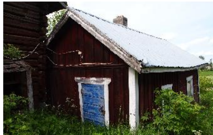
Sauna (C) on rakennettu lähes kiinni ulkorakennukseen. Kuva kaakosta kuvattuna.
