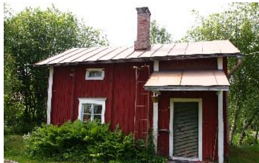
Asuinrakennus (A) koillisesta kuvattuna.
