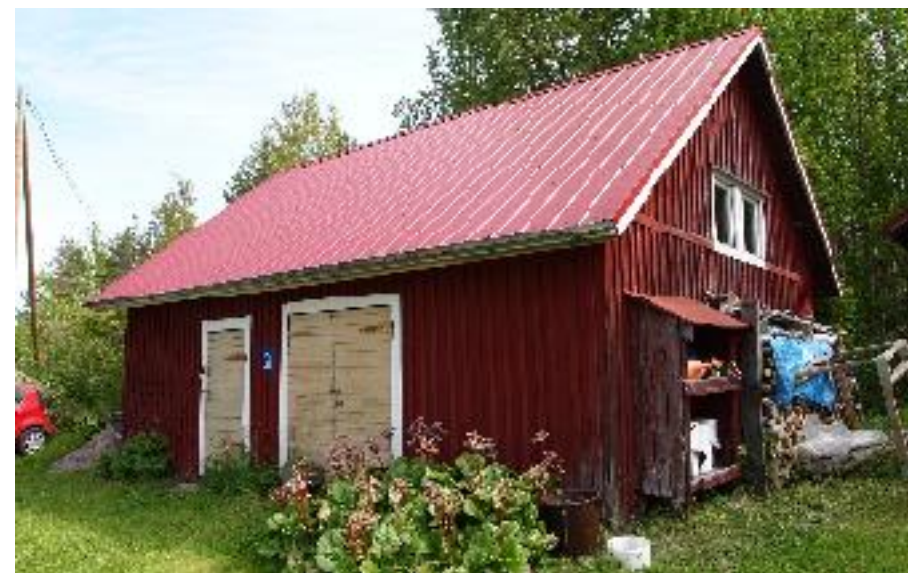
Asuinrakennus (A) koillisesta kuvattuna.
