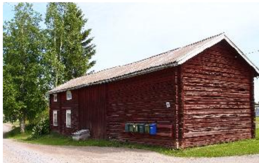
Ulkorakennus (A) Trontilantien varressa.
