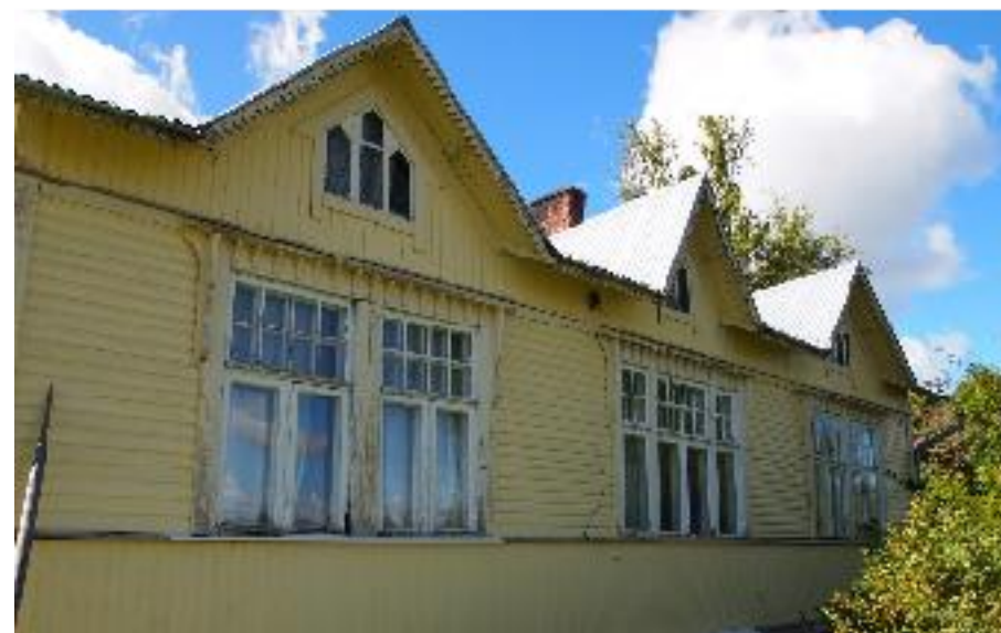
Asuinrakennuksen tienpuoleista julkisivua lännestä kuvattuna.
