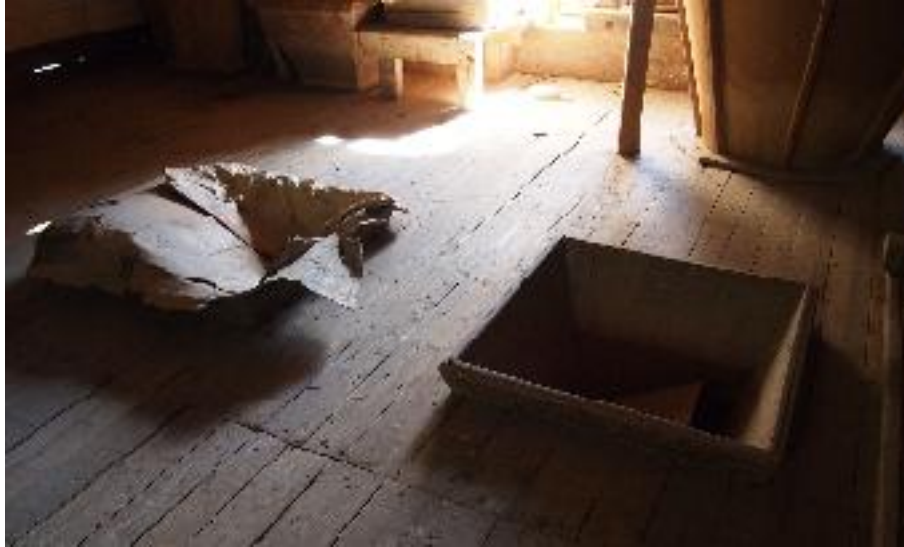
Jauhettavat jyvät kaadettiin yläkerroksen lattiassa oleviin laareihin, joista ne valuivat alas kivimyllyyn.
