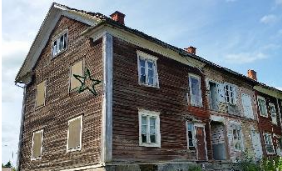
Soinin vanhan tilan päärakennuksen pihanpuolelta on purettu porrashuone. Idästä kuvattuna.
