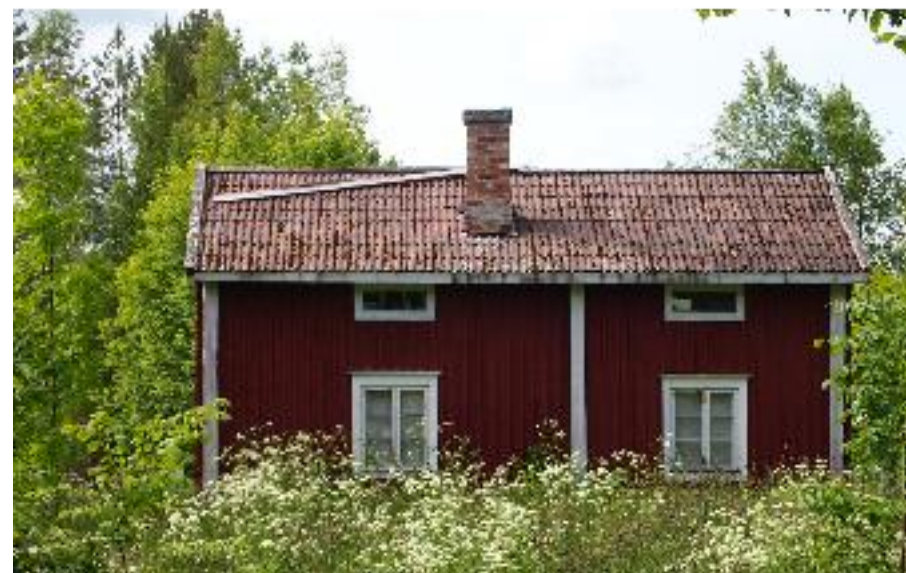
Asuinrakennus (A) koillisesta kuvattuna.
