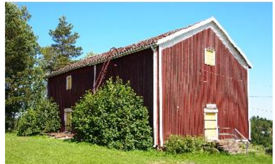
Lainajyvämakasiini (A) rakennettiin vuonna 1824 kirkon yhteyteen. Lounaasta kuvattuna.
