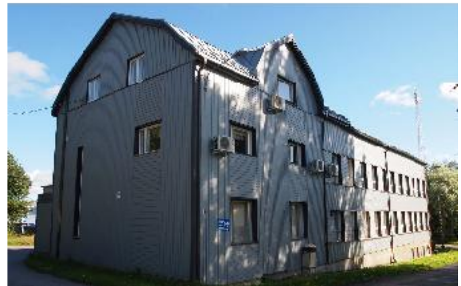
Vaiheittain laajennetun asuinrakennuksen kaakonpuoleinen julkisivu.
