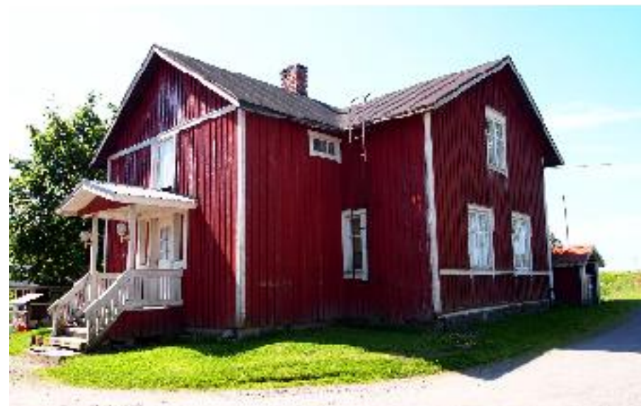
Asuinrakennus (A) pihan puolelta, koillisesta kuvattuna.
