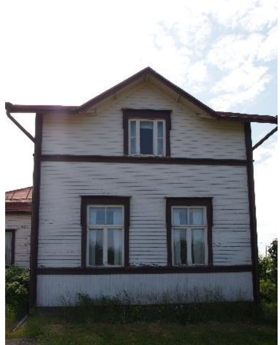
Asuinrakennuksen (A) luonteenomainen pääty pohjoiseen.
