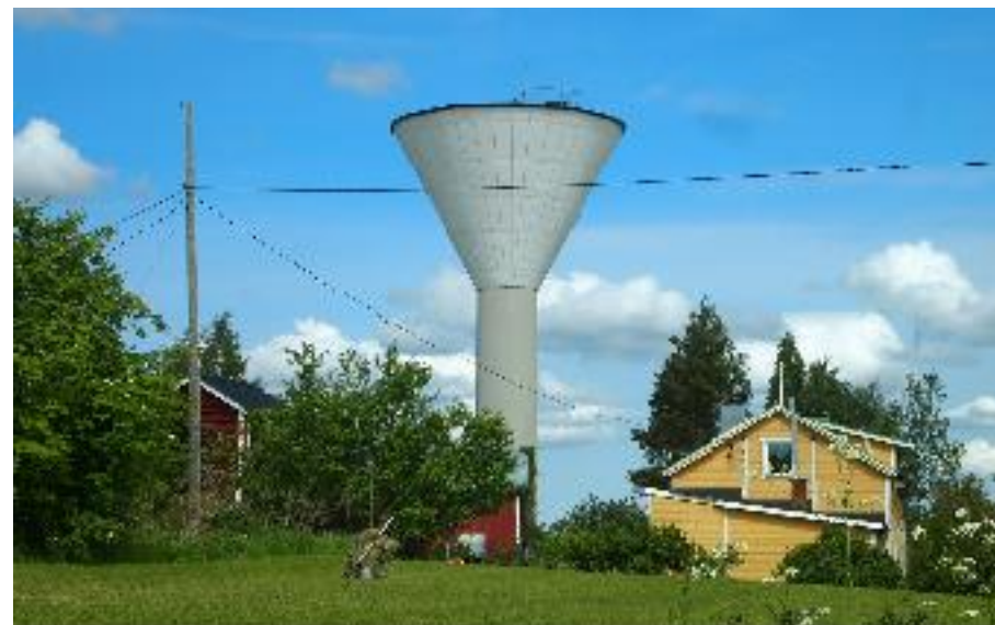
Kohde etelästä kuvattuna. Oikealla asuinrakennus (A).
