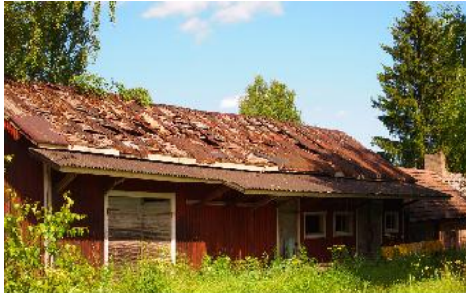
Ulkorakennus (B) on välttävässä kunnossa. Etelästä, pihanpuolelta kuvattuna.
