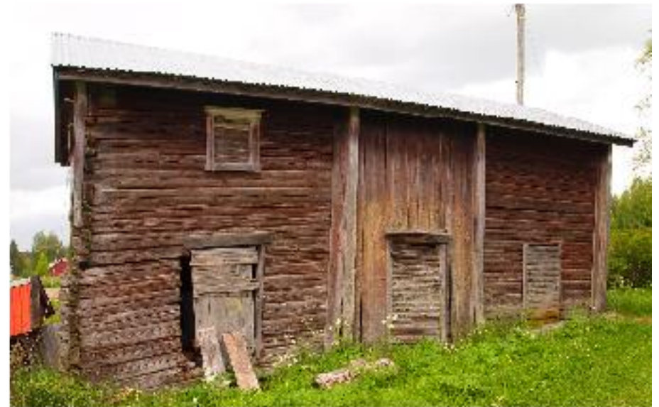
Ulkorakennus (B) pihan puolelta kuvattuna.
