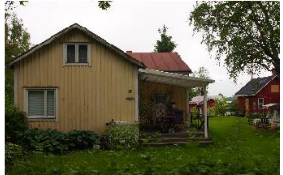
Asuinrakennuksen (A) pääty itään.
