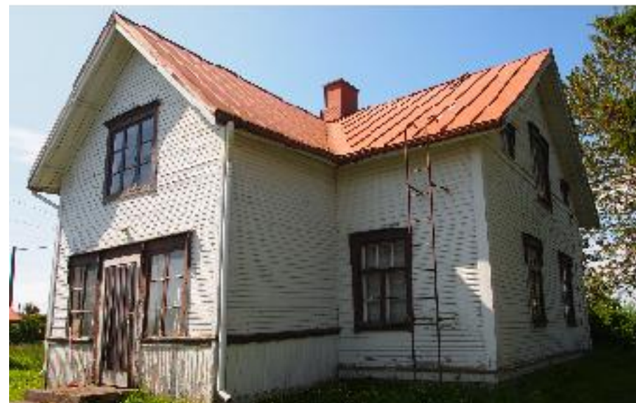
Asuinrakennus (A) pihasta päin kuvattuna.
