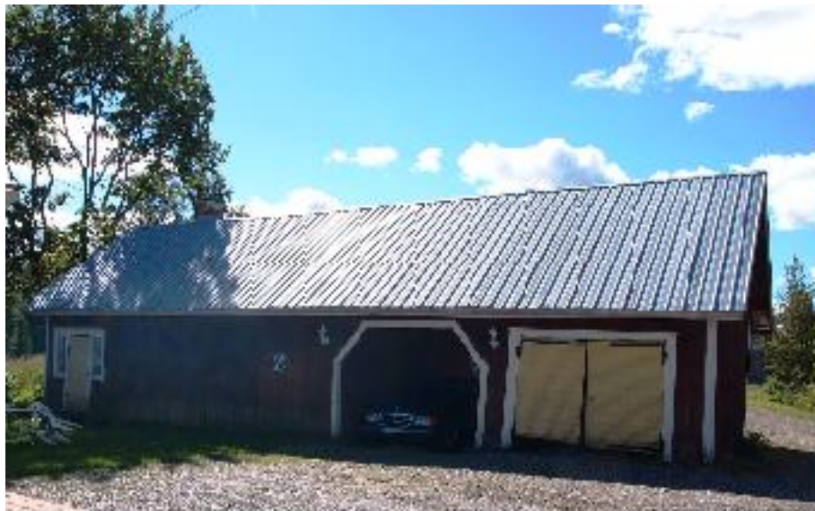
Ulkorakennuksen (B) julkisivu pihaan päin, koillisesta kuvattuna.
