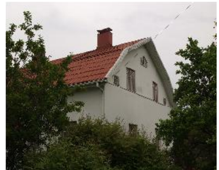
Rakennuksen vehreyden lomasta pilkottava eteläpääty.
