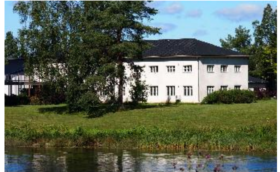
Tahdasrakennus (A) Kyrönjoen vastarannalta lounaasta kuvattuna.
