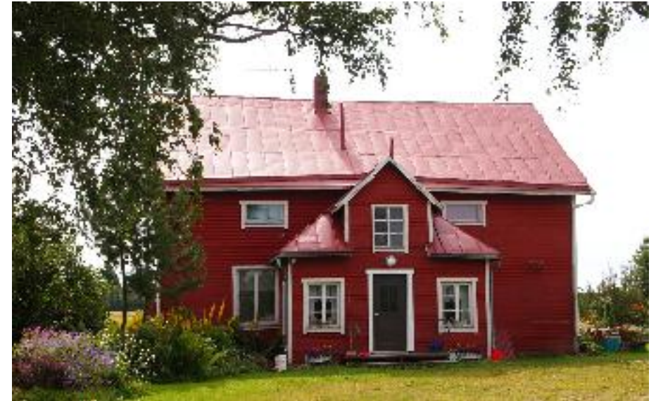
Asuinrakennuksen (A) tienpuoleista julkisivua, koillisesta kuvattuna.
