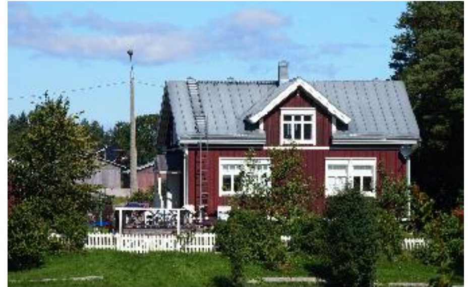
Asuinrakennuksen (A) joenpuoleinen julkisivu.
