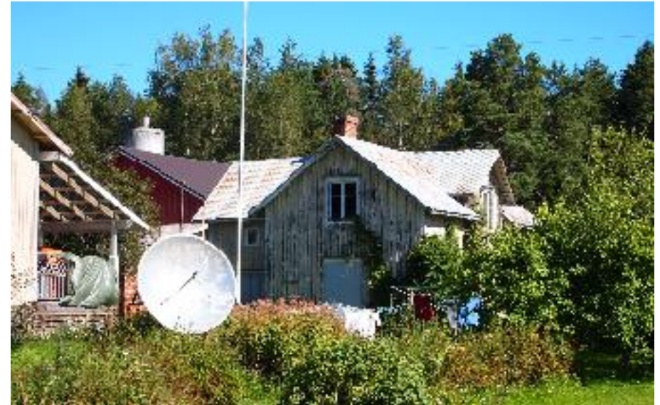
Asuinrakennus (A) Mullolantieltä, lounaasta kuvattuna.
