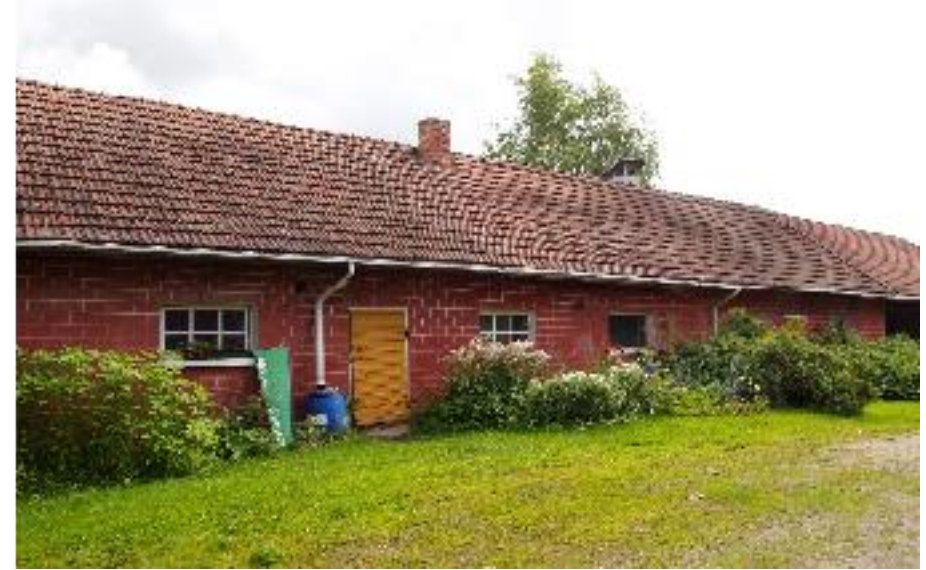
Ulkorakennuksen (C) maalattua tiilijulkisivua pihanpuolelle. Lännestä kuvattuna.
