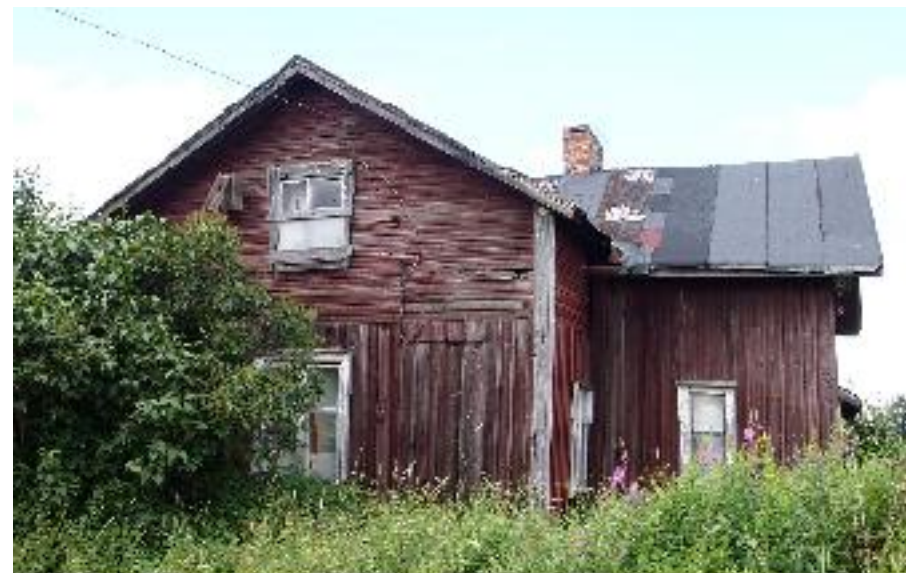
Asuinrakennus (A) Haaronkujalta idästä kuvattuna.
