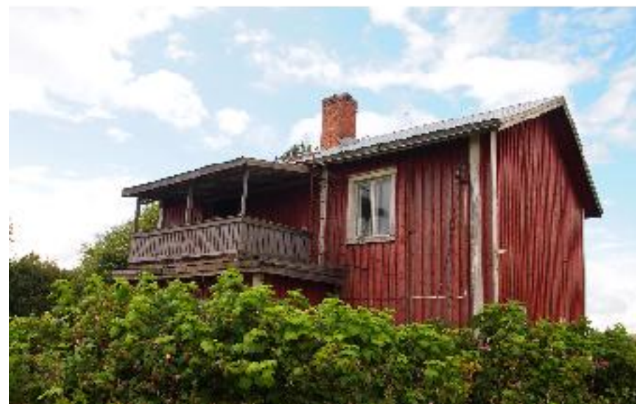
Asuinrakennuksen pihanpuoleista julkisivua koillisesta kuvattuna.
