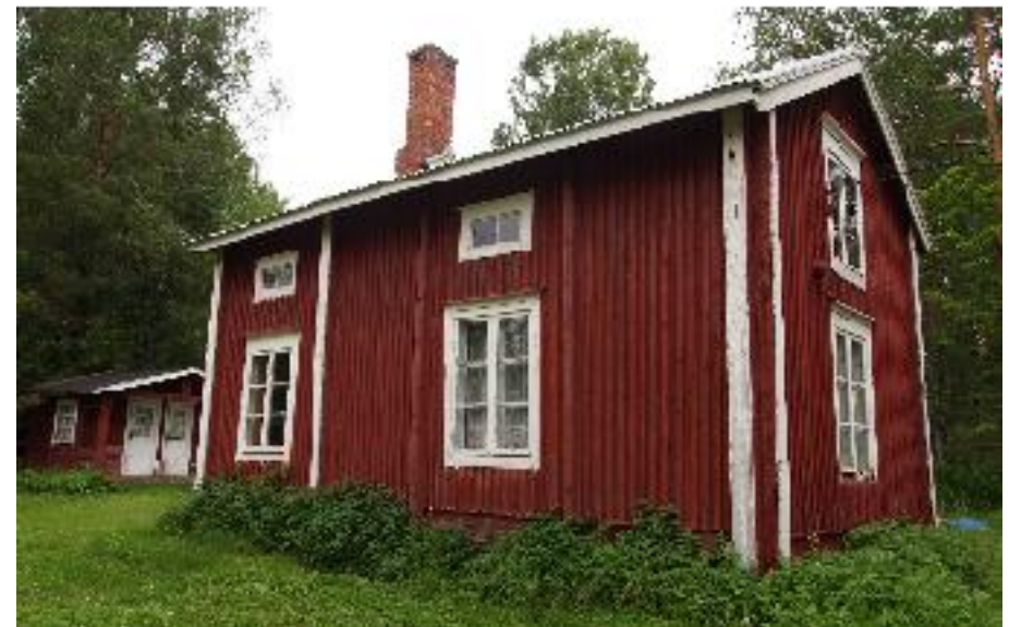
Asuinrakennus (A) lounaasta kuvattuna.
