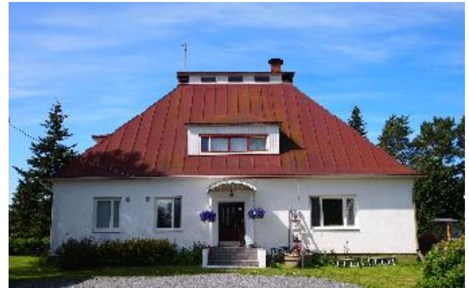
Asuinrakennuksen (A) pääjulkisivu itään, Hiiripellontien suuntaan.
