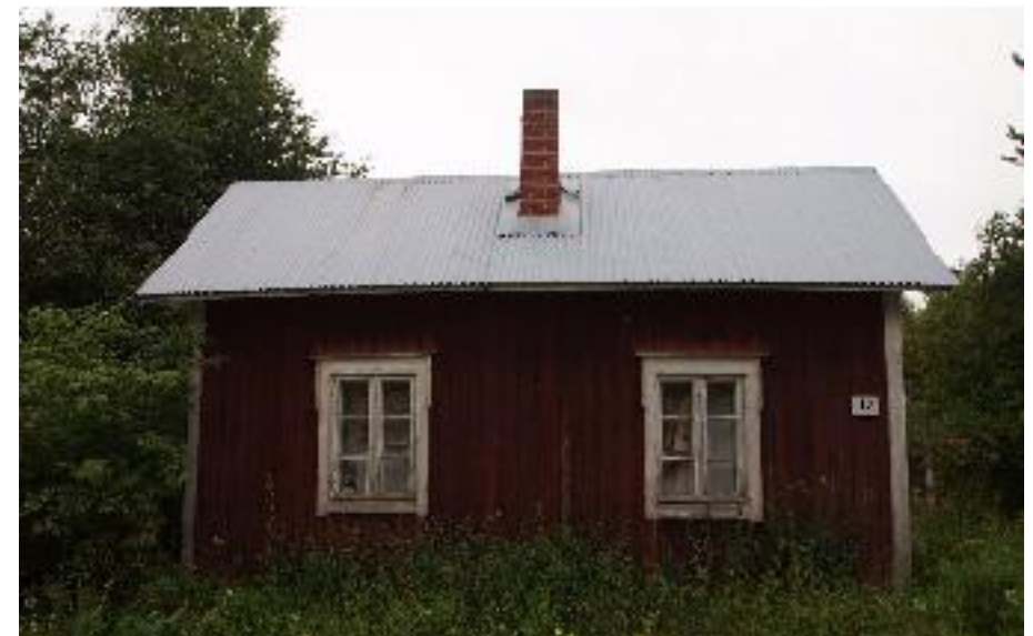
Asuinrakennuksen (A) julkisivu itään.
