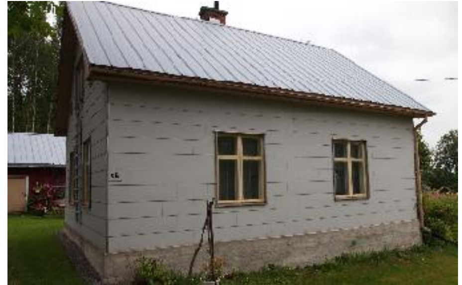
Asuinrakennuksen (A) tienpuoleista julkisivua, lounaasta kuvattuna.
