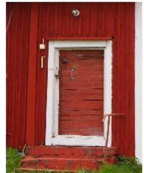
Hyvin huollettu sisäänkäynti.
