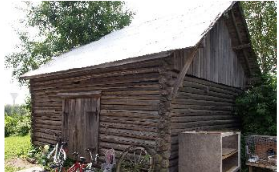
Heinälato (A) koillisesta kuvattuna.
