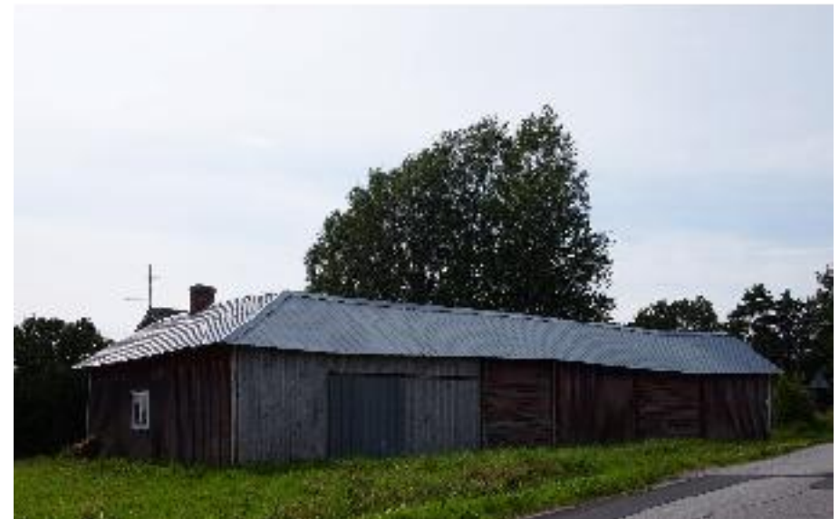
Ulkorakennuksella (B) on merkitystä tietilan ja -maiseman kannalta. Koillisesta kuvattuna
