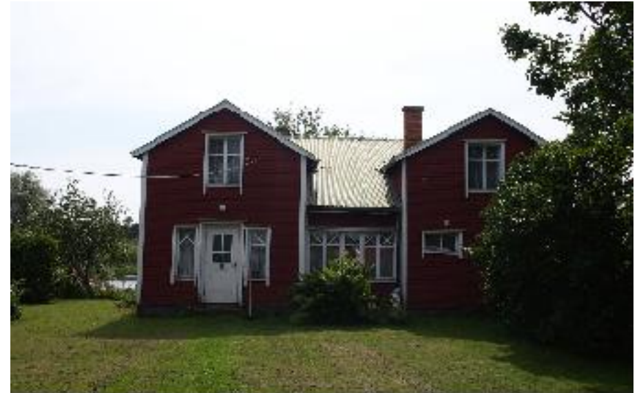
Asuinrakennuksen julkisivu pihaan päin, pohjoisesta kuvattuna.
