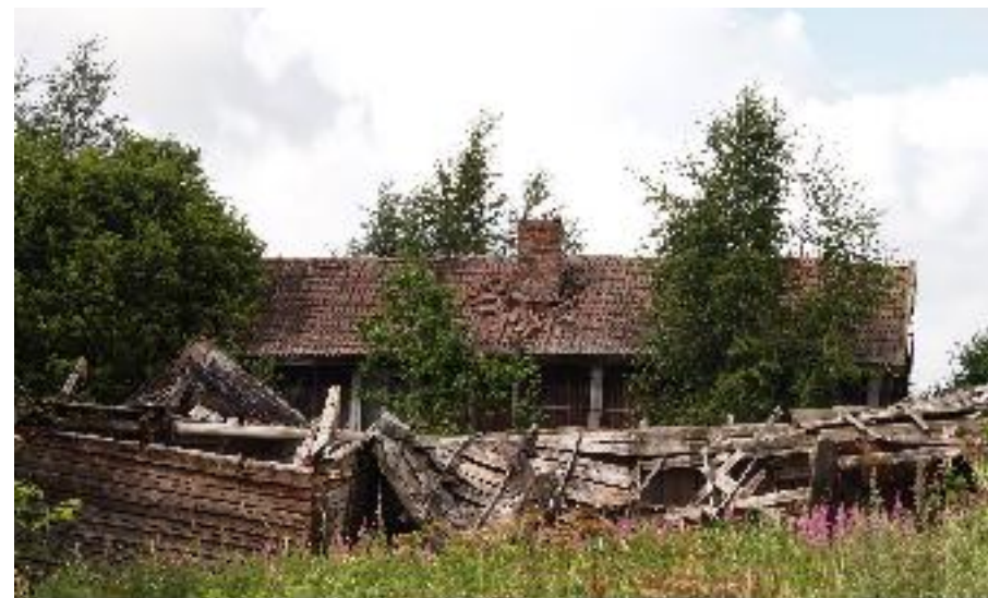
Vaikeasti lähestyttävissä olevaa asuinrakennusta (A) kaakosta kuvattua. Etualalla ulkorakennus (B).
