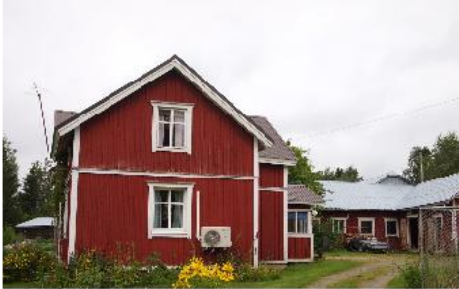
Asuinrakennuksen (A) länsipääty ja taustalla ulkorakennusta (B).
