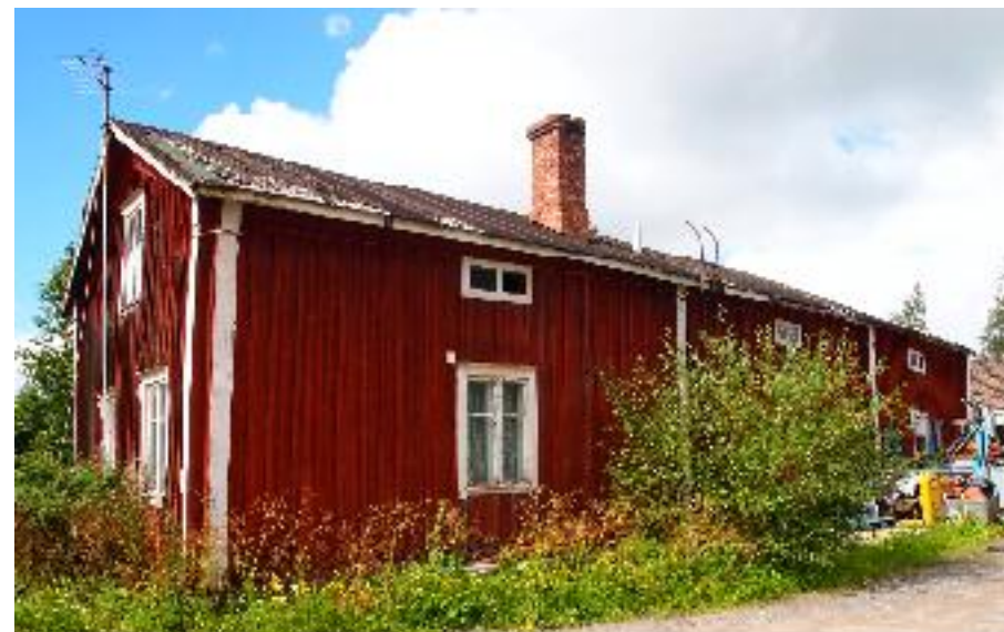
Asuinrakennuksen (A) pihanpuoleista julkisivua.
