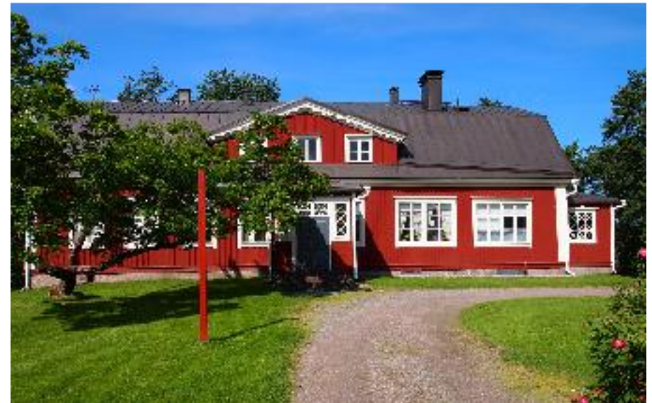
Pappilarakennuksen (A) pihanpuolista julkisivua. Kaakosta kuvattuna.
