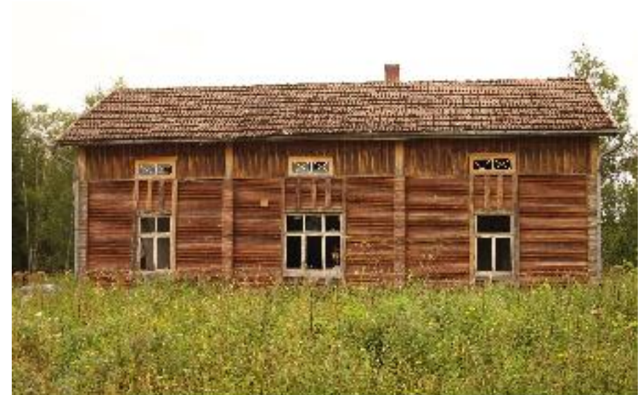
Asuinrakennuksen (A) julkisivu länteen, Mullolantielle.
