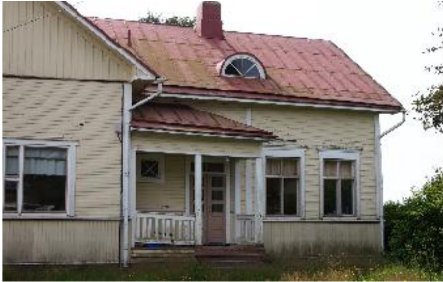
Pihanpuolen läntinen sisäänkäyntikuisti. Pohjoisesta kuvattuna.
