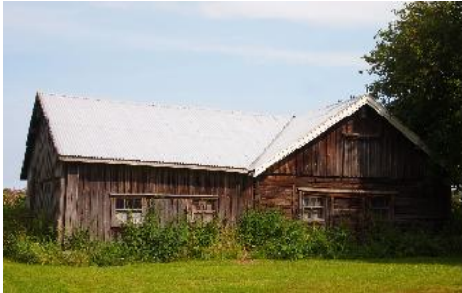
Ulkorakennuksen (B) pihanpuoleinen julkisivu lounaasta kuvattuna.
