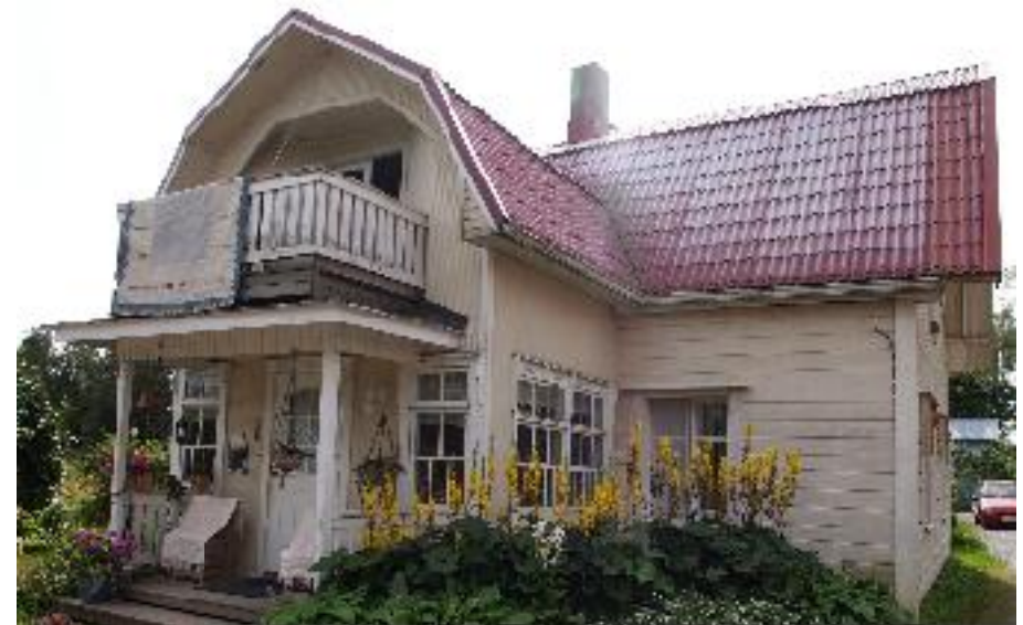
Asuinrakennus (A) pihanpuolelta, kaakosta kuvattuna.
