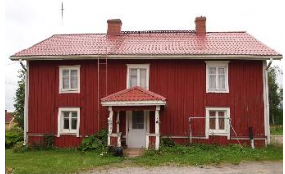
Asuinrakennuksen (A) pihanpuoleinen julkisivu.
