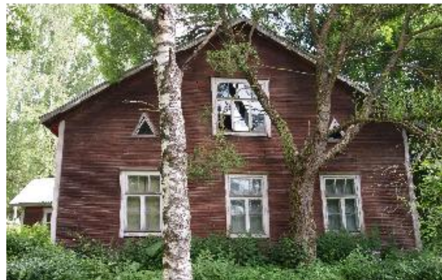
Asuinrakennuksen (A) länsipääty
