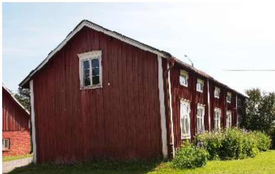
Asuinrakennuksen (A) luoteispäätä ja lounaisjulkisivua.
