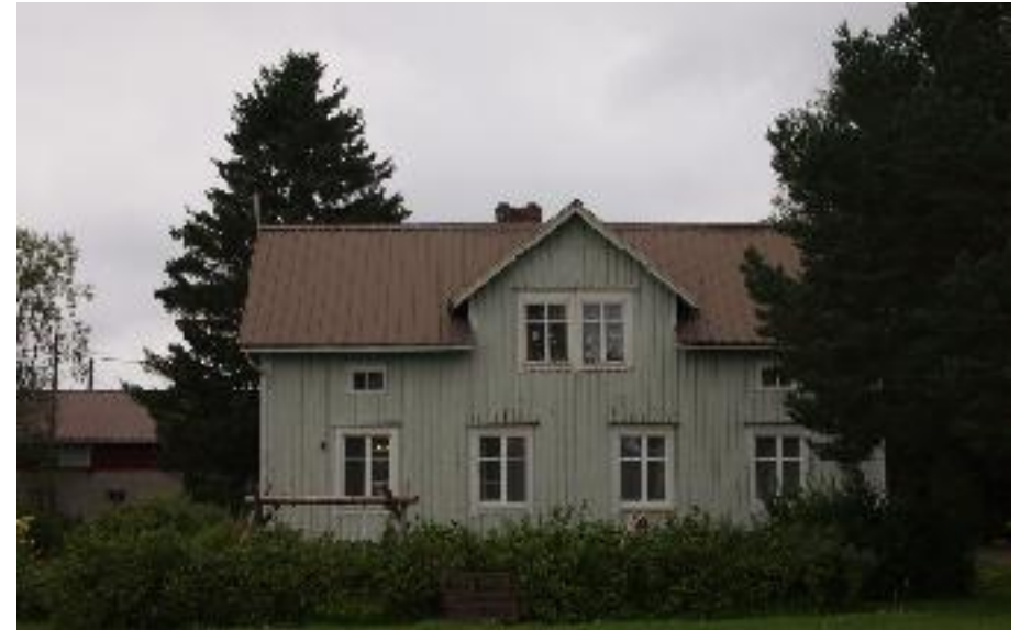
Asuinrakennuksen (A) julkisivu Mullolantielle, entiselle Karjakadulle.
