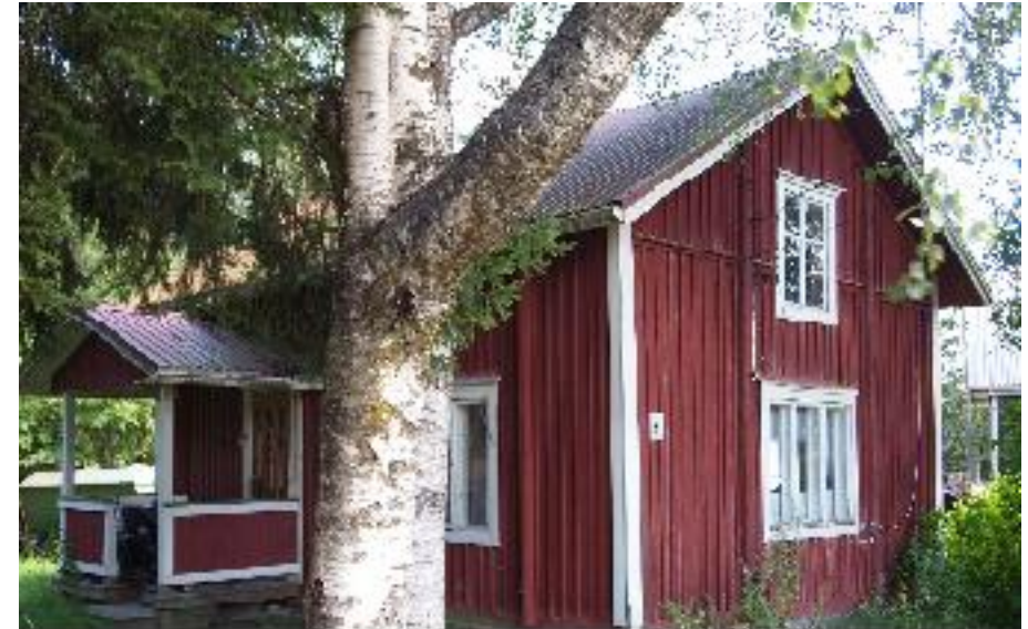
Asuinrakennus (A) Ainmaantieltä, luoteesta kuvattuna.
