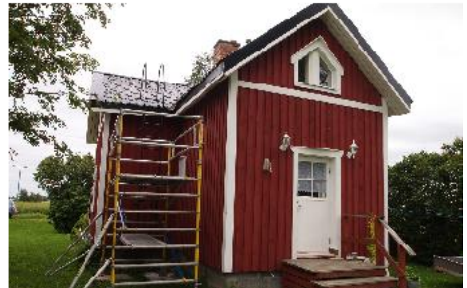
Asuinrakennuksen uutta päätylaajennusta lännestä kuvattuna.
