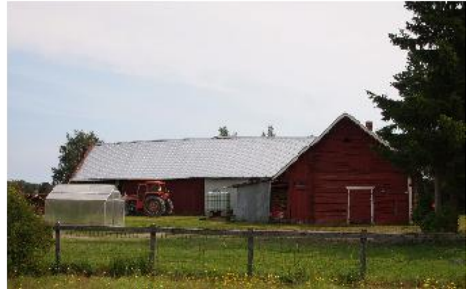
Ulkorakennus (B) kuvattuna lännestä, naapurin puolelta.
