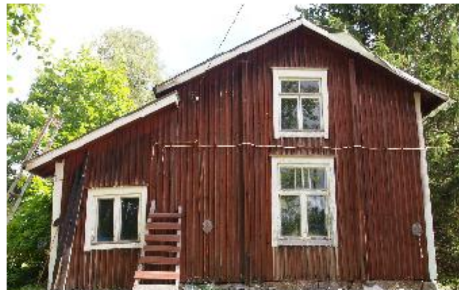
Asuinrakennus (A) kuvattuna luoteesta.
