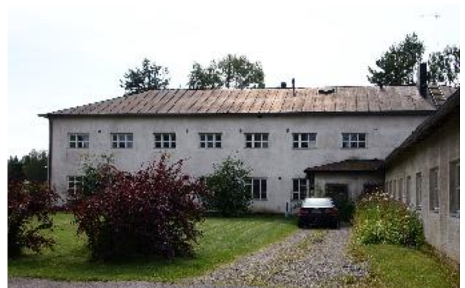
Tehdasrakennus (A) koillisesta kuvattuna.
