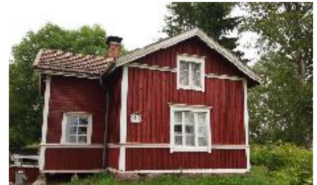
Asuinrakennuksen (A) pääty etelään, Kokkomäentielle.
