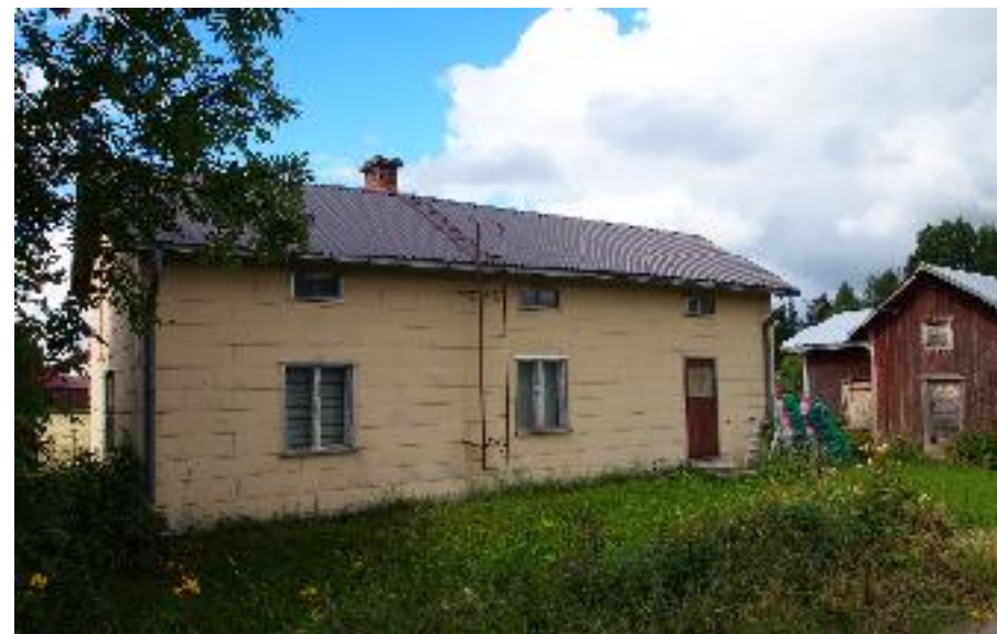
Asuinrakennuksen (A) pihanpuoleinen julkisivu kaakosta kuvattuna.
