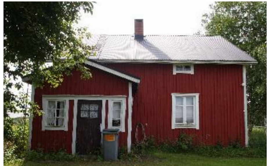
Asuinrakennuksen pihan puoleinen julkisivu, koillisesta kuvattuna.
