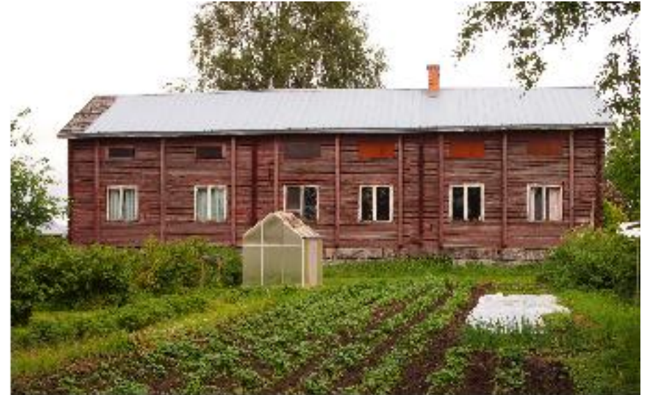
Asuinrakennuksen (A) lounaanpuoleinen julkisivu.
