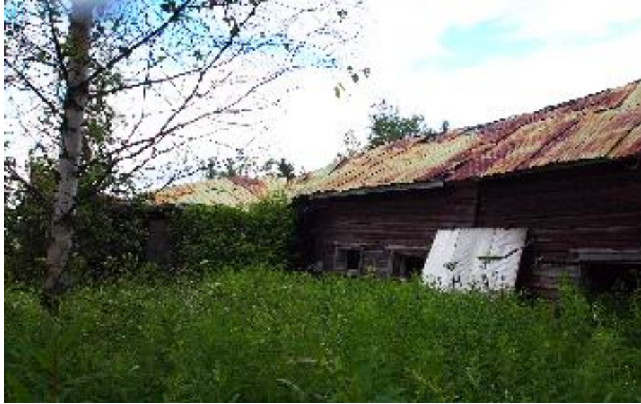
Ulkorakennus (B) luoteesta kuvattuna.
