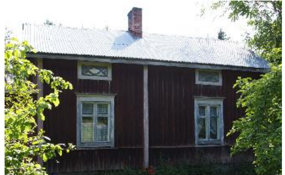
Asuinrakennuksen (A) julkisivu länteen tielle päin.
