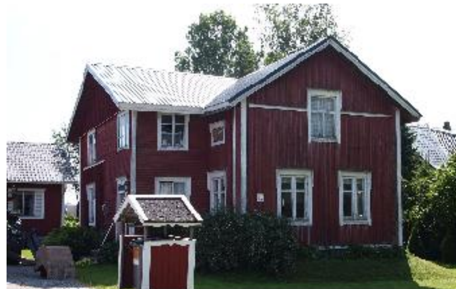
Asuinrakennuksen (A) pihanpuoleinen julkisivu.
