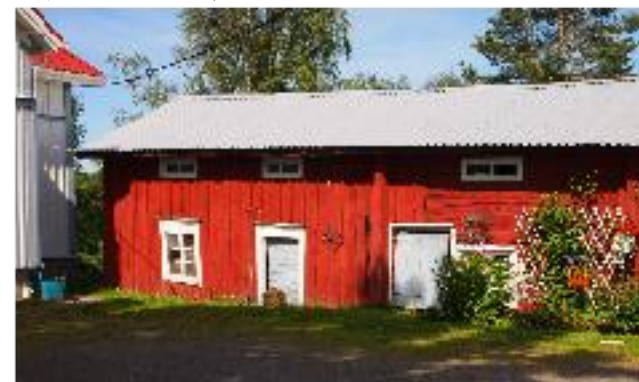
Piharakennuksen (B) perinteinen ulkoasu ja ilme on säilynyt hyvin. Etelästä kuvattuna.
