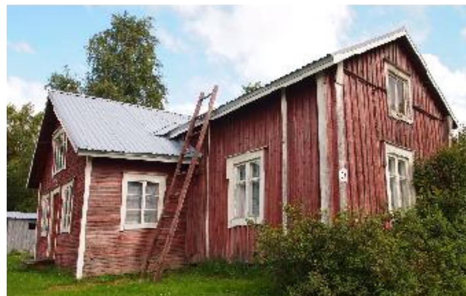
Asuinrakennus (A) lounaasta kuvattuna.
