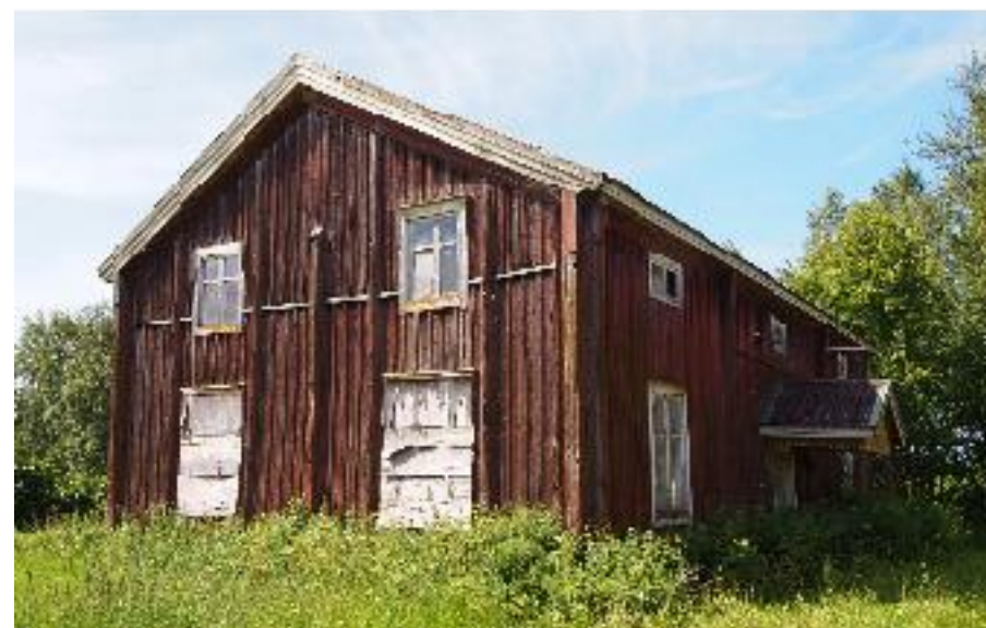
Rakennuksen kaakkoispäätä ja pihanpuoleista julkisivua.
