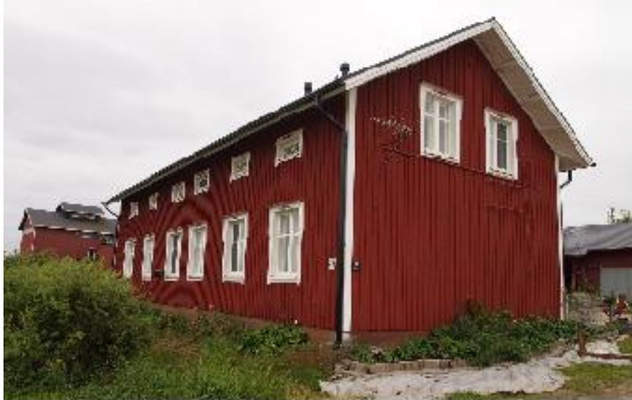
Asuinrakennuksen (A) tienpuoleista julkisivua ja pohjoispäätä.
