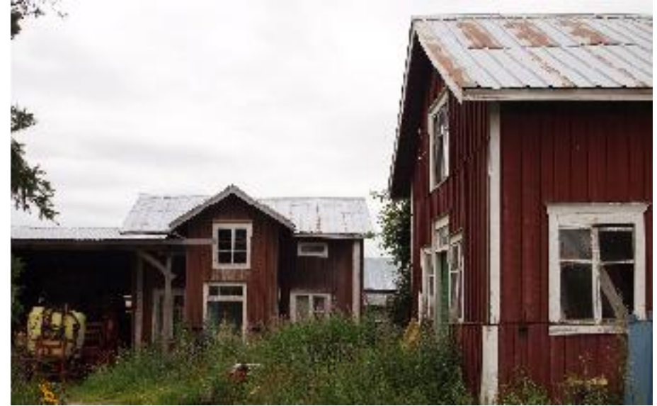
Taustalla Vanha-Mullon vähätuvan (D) julkisivu länteen. Etualalla oikealla vähätupa (D).
