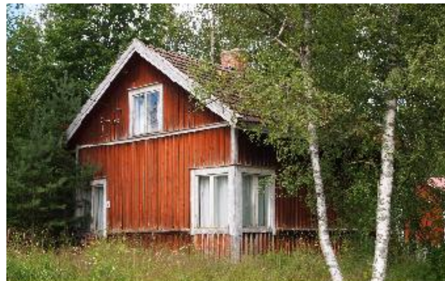
Asuinrakennus (A) kuvattuna Läkkitieltä päin kaakosta.
