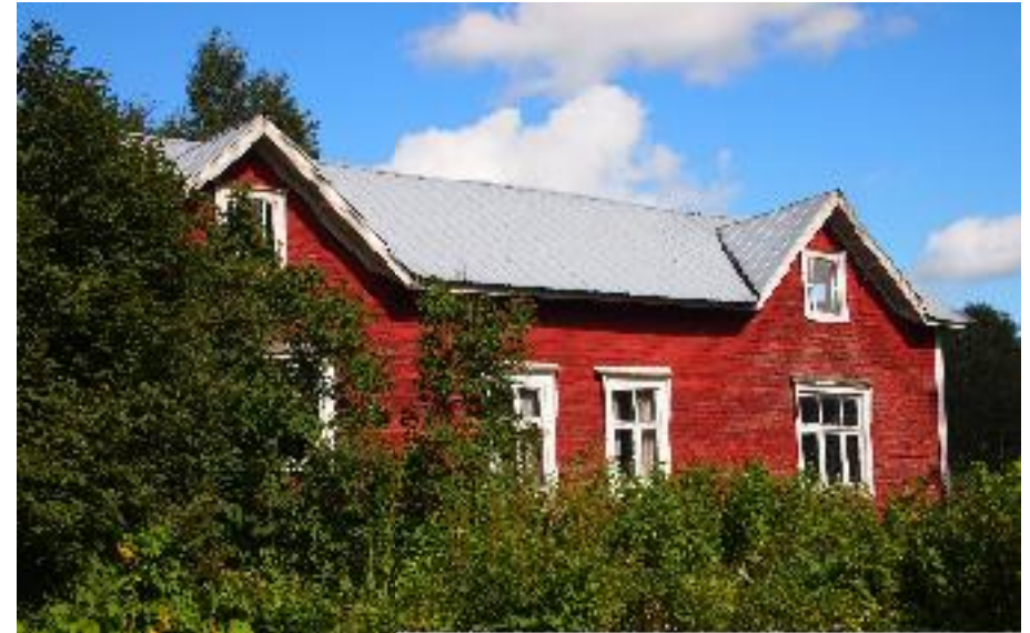
Asuinrakennus (A) lounaasta kuvattuna.
