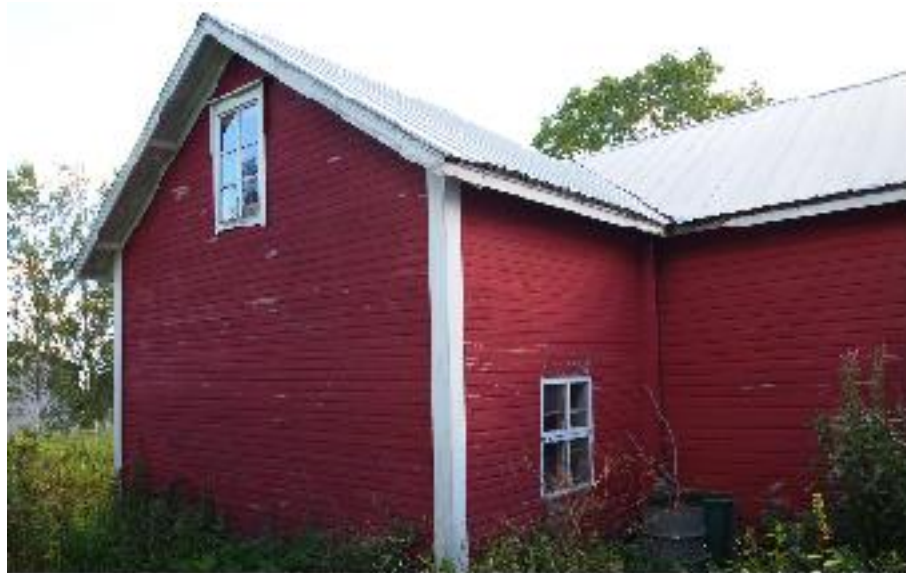
Asuinrakennuksen (A) aikaisempaa poikittaislaajennusta pohjoisesta kuvattuna.
