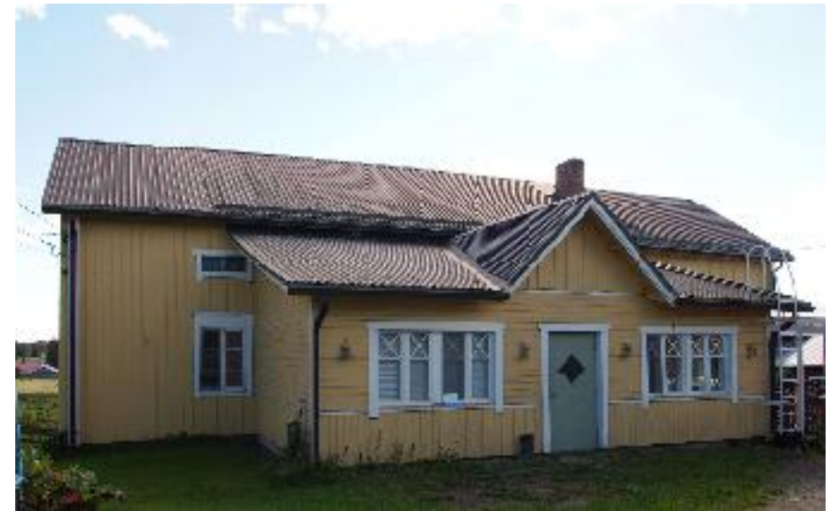
Asuinrakennuksen pihanpuoleista julkisivua, koillisesta kuvattuna.
