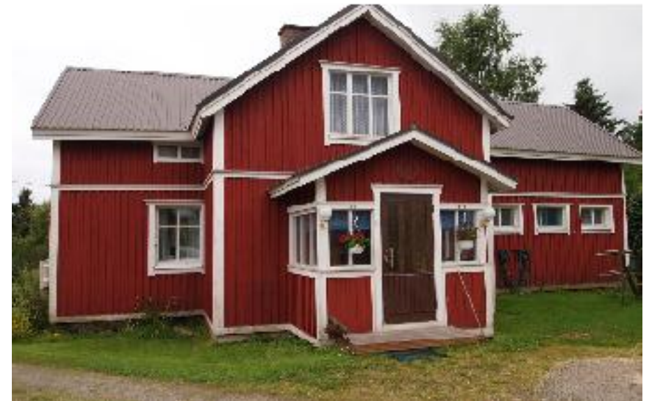
Asuinrakennuksen (A) pihanpuoleista julkisivua, koillisesta kuvattuna.
