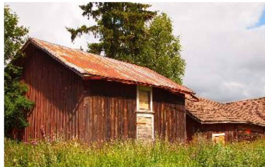
Ulkorakennuskokonaisuuden (B) pihanpuoleista osaa koillisesta kuvattuna.
