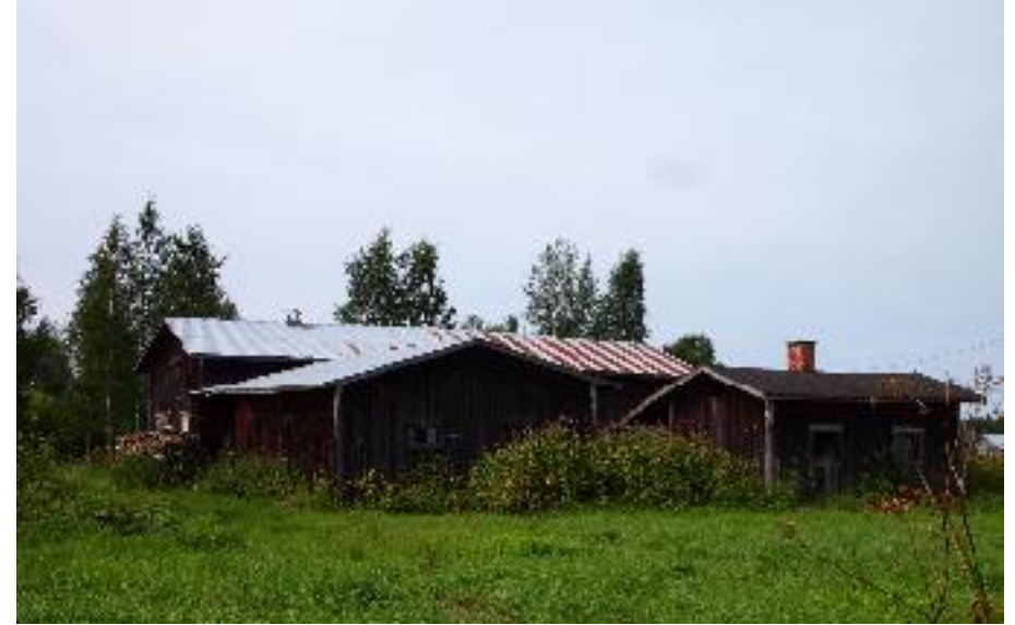
Harmaantuneiden ulkorakennusten tiivis rykelmä Jokivarsitieltä kuvattuna.
