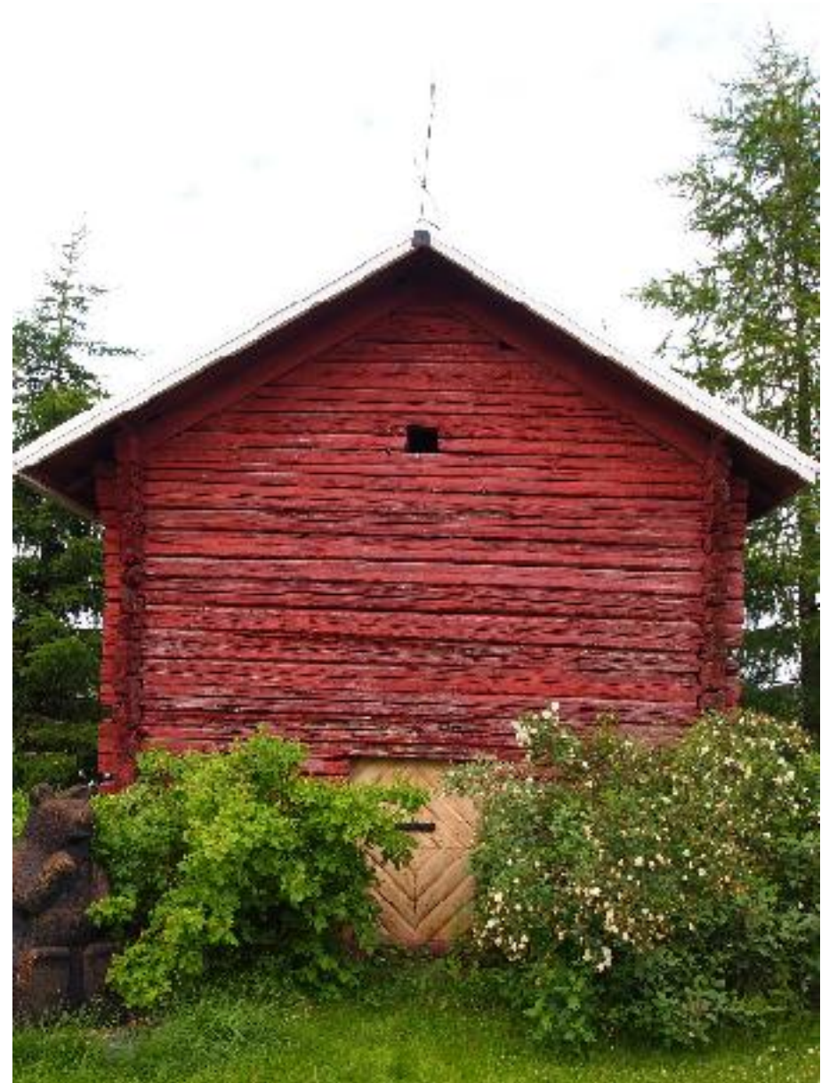
Vuonna 1792 rakennetussa aitassa (B) on harvinaisen matala ovi ja yläosastaan ulosviistetyt sivuseinät. Leveäräystäinen katto ei ole alkuperäinen. Etelästä kuvattuna
