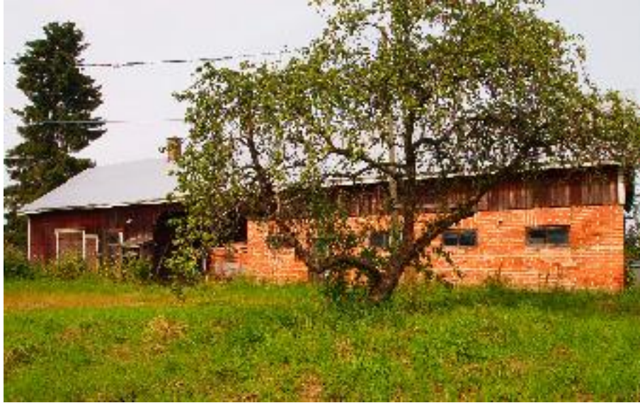
Ulkorakennus (B) pihasta päin pohjoiseen kuvattuna.
