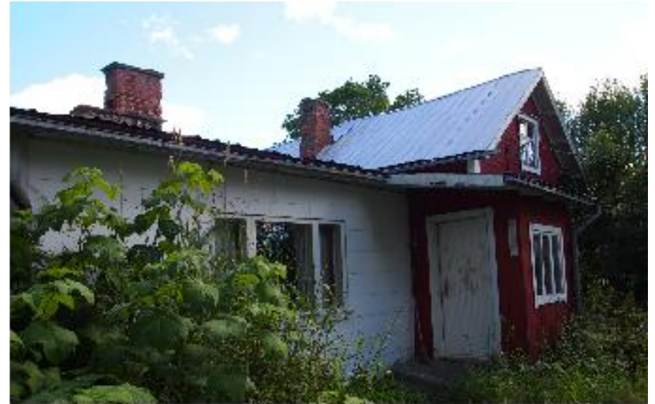
Asuinrakennuksen (A) 1960-luvun laajennusta luoteesta kuvattuna.
