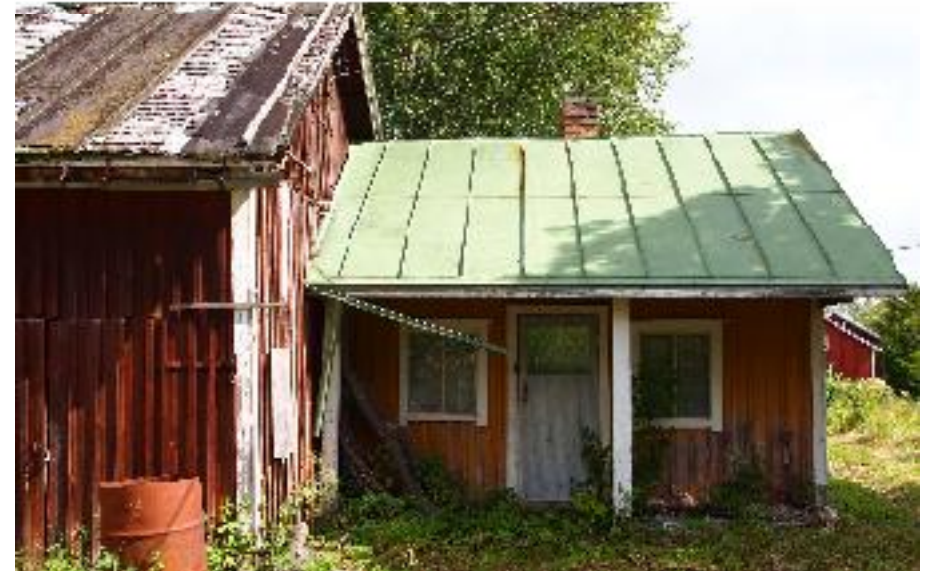
Ulkorakennuksen (B) eteläpään pieni asuinosa lännestä kuvattuna.
