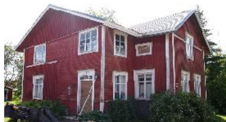
Asuinrakennuksen (A) pihanpuoleinen julkisivu.
