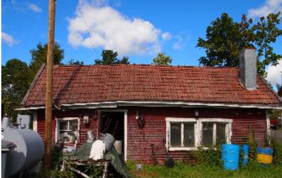
Pläkkiverstaan (A) pihanpuoleinen julkisivu, etelästä kuvattuna.
