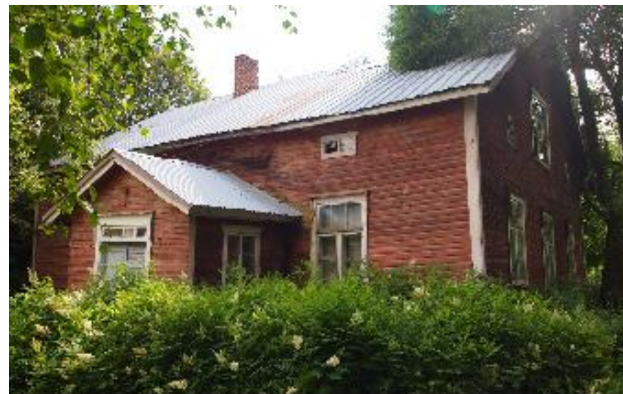
Asuinrakennuksen (A) pihanpuoleista julkisivua luoteesta kuvattuna.
