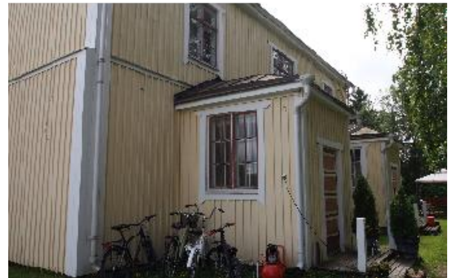
Asuinrakennuksen (A) sisäänkäyntikuistit on pihan ja joen puolella.
