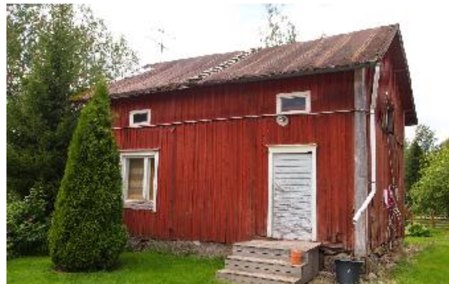
Asuinrakennus (B) kuvattuna koillisesta.
