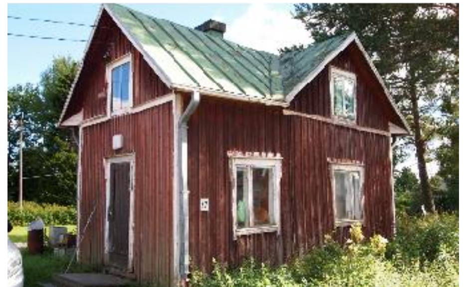
Asuinrakennuksen pohjoispäätä ja Hyyriäntienpuoleista julkisivua.
