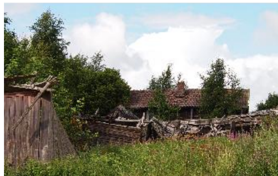
Kohde kaakosta kuvattuna, vasemmalla etualalla ulkorakennus (C).
