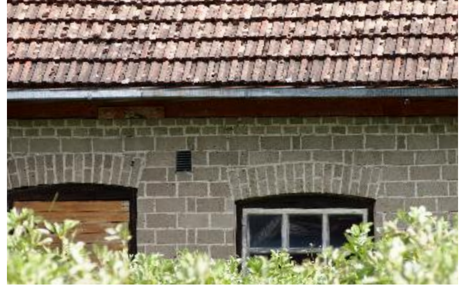
Navetan (D) huolellista muurausjälkeä.
