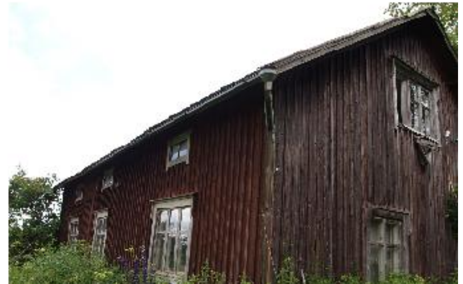
Asuinrakennuksen (A) lännenpuolista julkisivua ja eteläpäätä.
