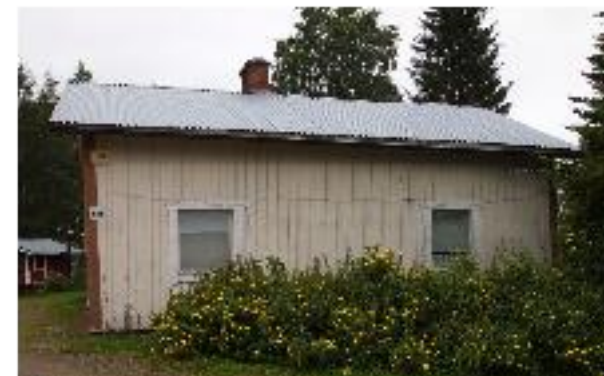
Asuinrakennuksen (A) julkisivu lounaaseen. Kuvassa näkyy selvästi miten vasemmanpuoleinen nurkka on ylöspäin viistottu, mikä viittaa siihen, että rakennus olisi varsin vanhan pohjalaistalon osa.
