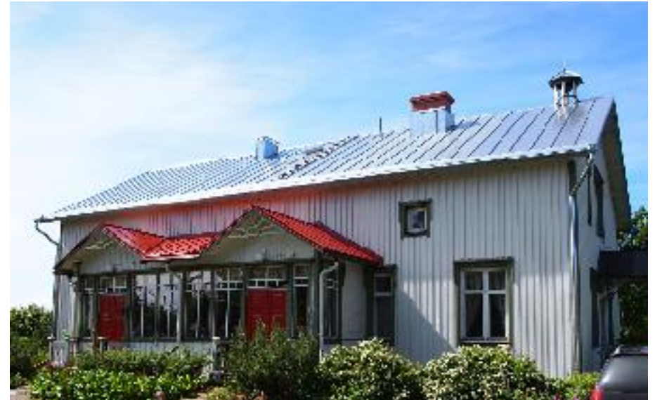
Asuinrakennuksen (A) pihanpuoleinen julkisivu. Kuistin alkuperä on epäselvä.
