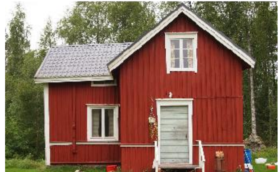
Asuinrakennuksen (A) julkisivu itään.
