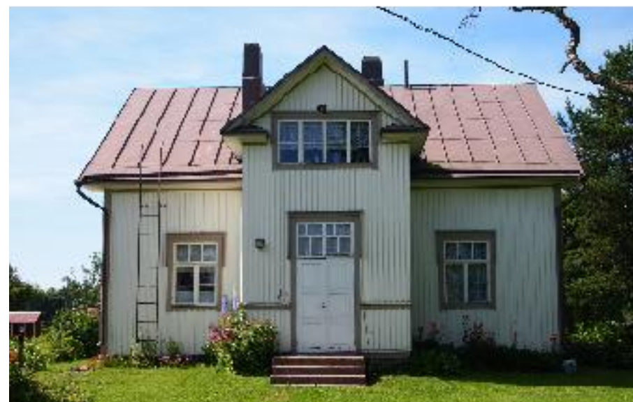
Asuinrakennuksen (A) pihanpuoleinen julkisivu.
