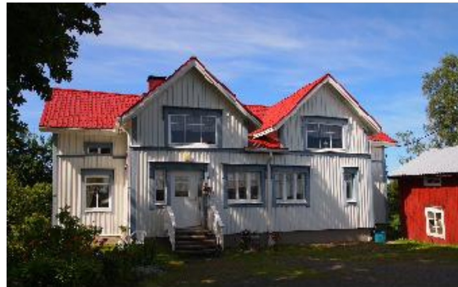
Asuinrakennuksen (A) pihanpuoleinen julkisivu.
