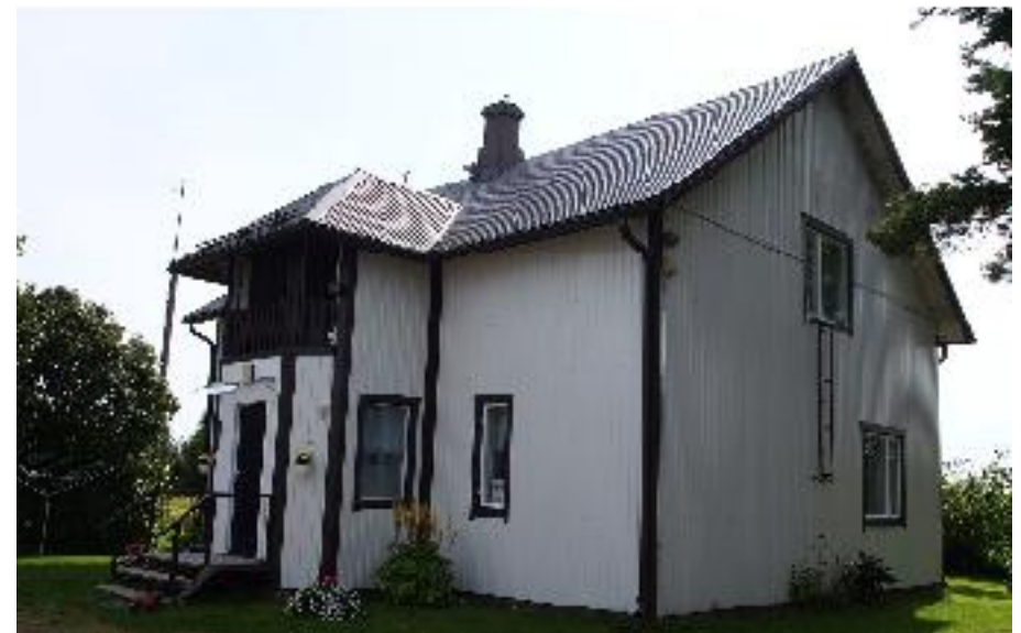
Asuinrakennus luoteesta kuvattuna.
