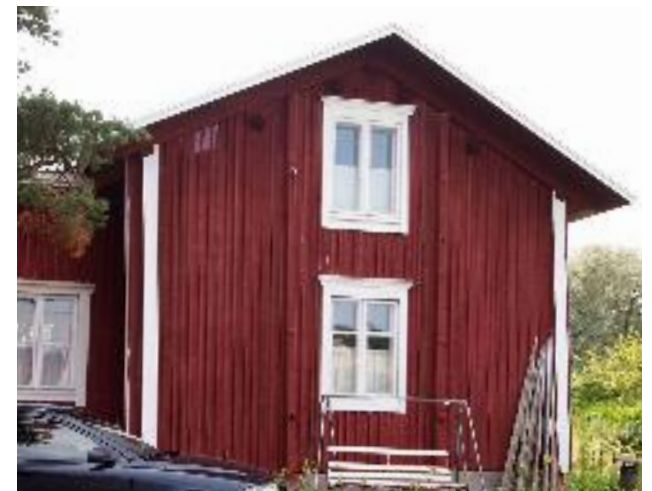
Alkujaan Salmen talon pääty. Koillisesta kuvattuna.
