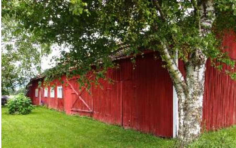
Ulkorakennuksen (B) pihanpuoleinen julkisivu ja päätyä tielle.
