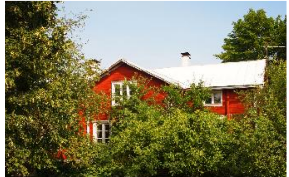
Vaikeasti kuvattava asuinrakennus (A) tieltä päin, lounaasta kuvattuna.
