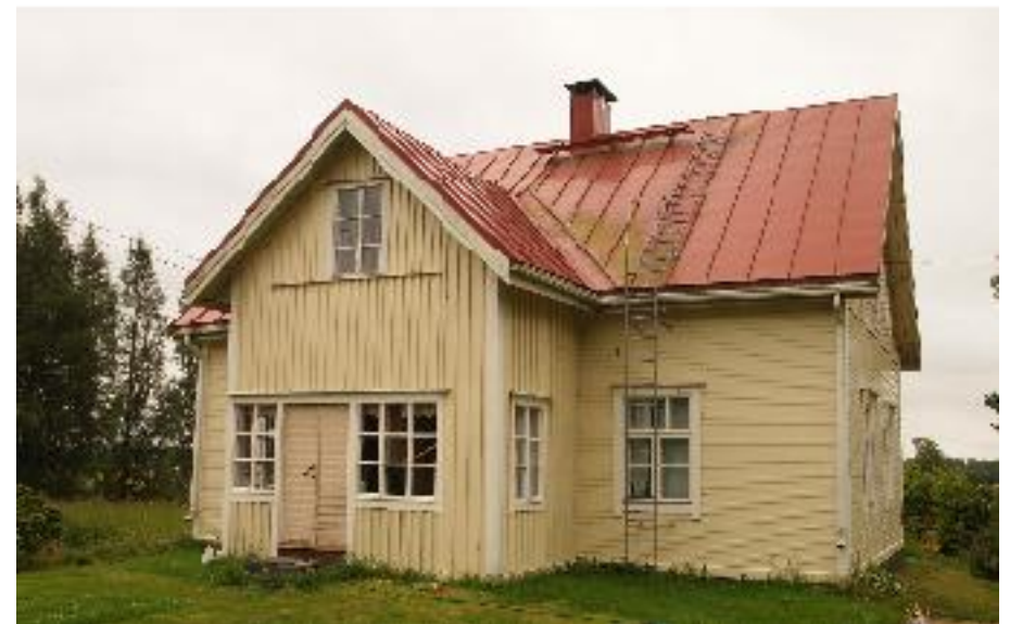
Asuinrakennuksen (A) pihanpuoleista julkisivua, pohjoisesta kuvattuna.
