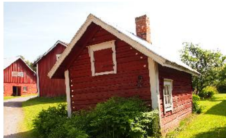
Saunarakennuksen (B) luoteispäätä ja lounaisjulkisivua. Taustalla vasemmalla pilkottaa asuinrakennus (A) ja ulkorakennus (C).
