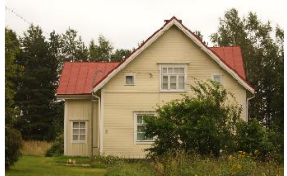
Asuinrakennuksen (A) julkisivua länteen.
