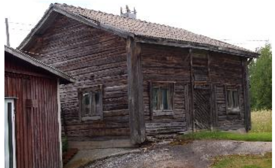
Ulkorakennus (C) etelästä kuvattuna.
