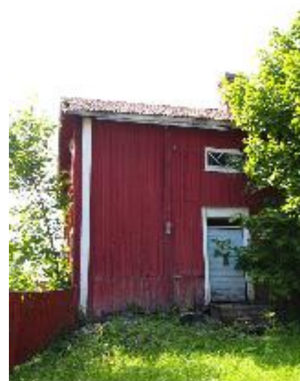
Pihanpuolella koillisessa on rakennuksen sisäänkäynti.
