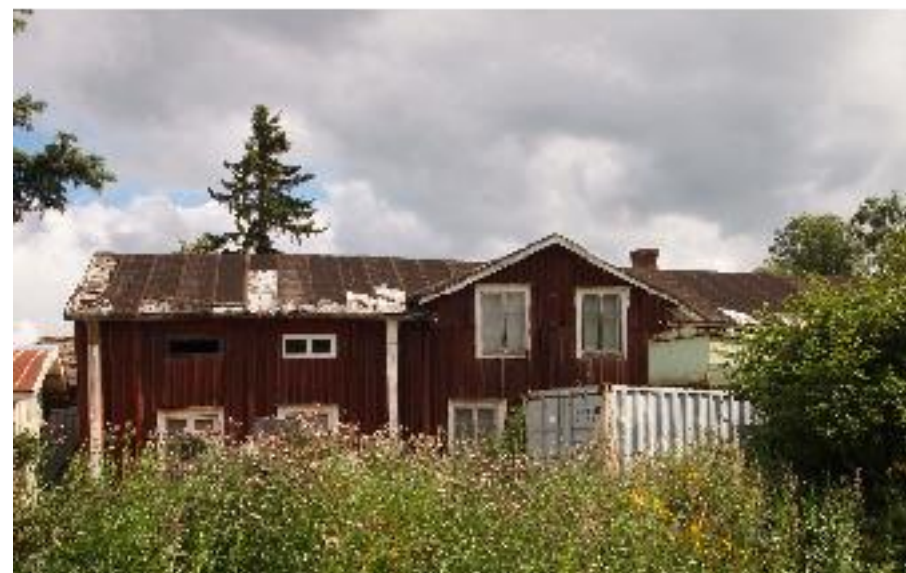
Asuinrakennuksen (A) julkisivua Jokivarsitielle.
