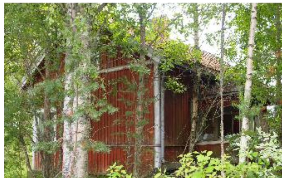
Asuinrakennuksen (A) sisäänkäyntijulkisivu pilkkottaa vesakon takaa. Luoteesta kuvattuna.
