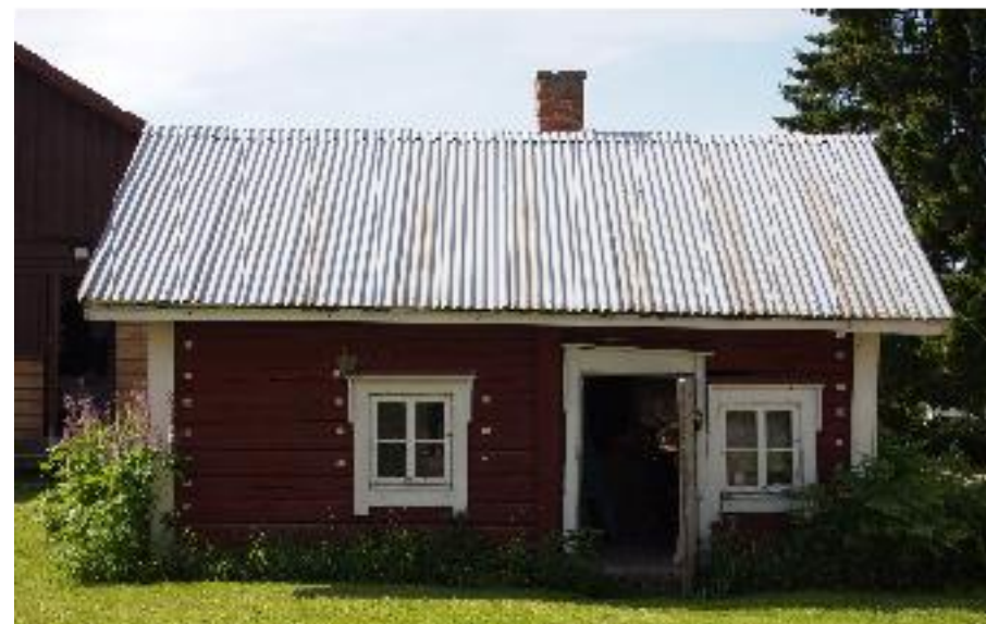
Saunan (B) pääjulkisivu koilliseen.
