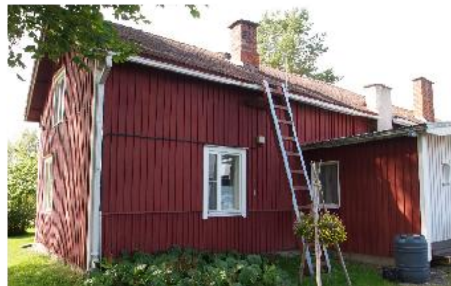
Asuinrakennus (A) pihanpuolelta, koillisesta kuvattuna.
