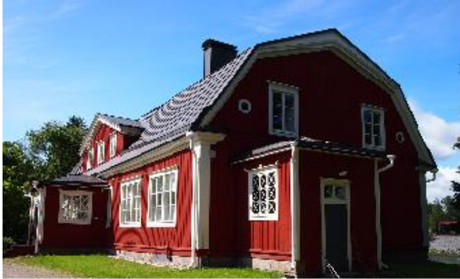
Pappilarakennuksen (A) kuistit ristipröissättyine ikkunoineen ovat muuta rakennusta uudempiä perua. Pohjoisesta kuvattuna.
