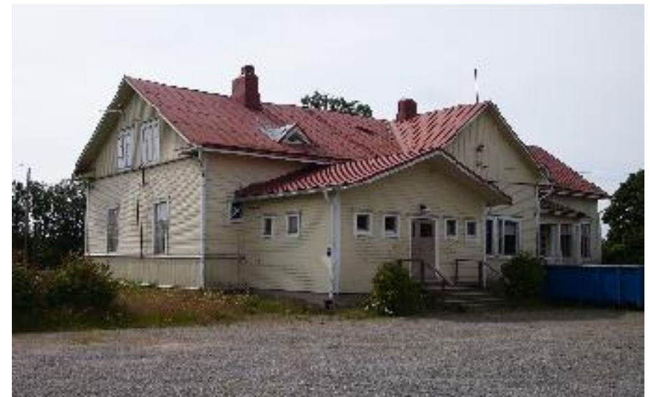
Koulurakennuksen pihanpuolen eriaikaisia laajennusosia. Koillisesta kuvattuna.
