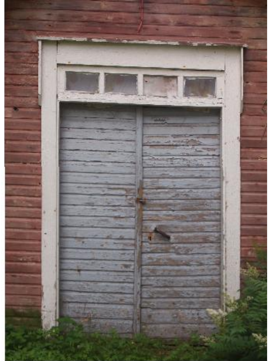
Asuinrakennuksen (A) lautarakenteinen ulko-ovi yläikkunalla.
