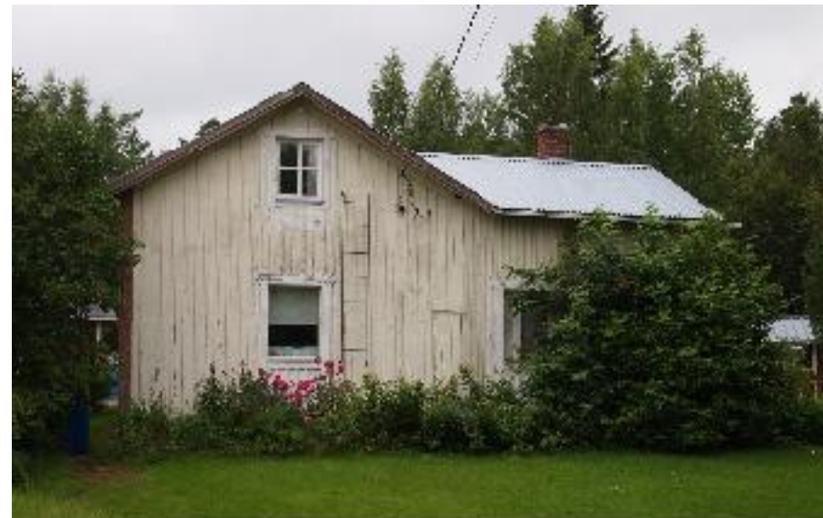
Asuinrakennuksen (A) julkisivu kaakkoon.
