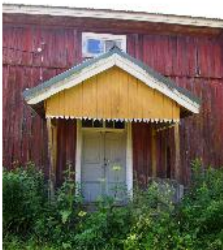
Pihanpuoleinen muuta rakennusta uudempi avokuisti.
