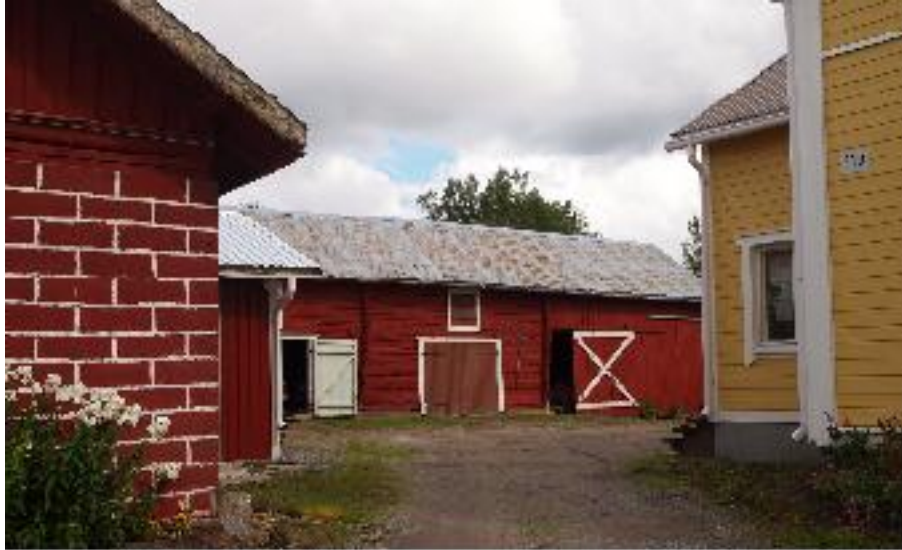
Kohteen pihapiiriin kuuluu rakennuksia eri ajoilta. Taustalla keskellä ulkorakennus (B). Lounaasta kuvattuna.
