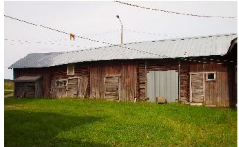
Ulkorakennuksen (B) pihanpuoleista julkisivua etelästä kuvattuna.
