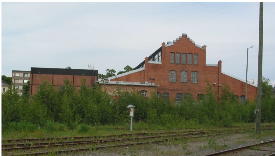
Etelään suuntautuva julkisivu sekä 1977 valmistunut levytyöosasto
